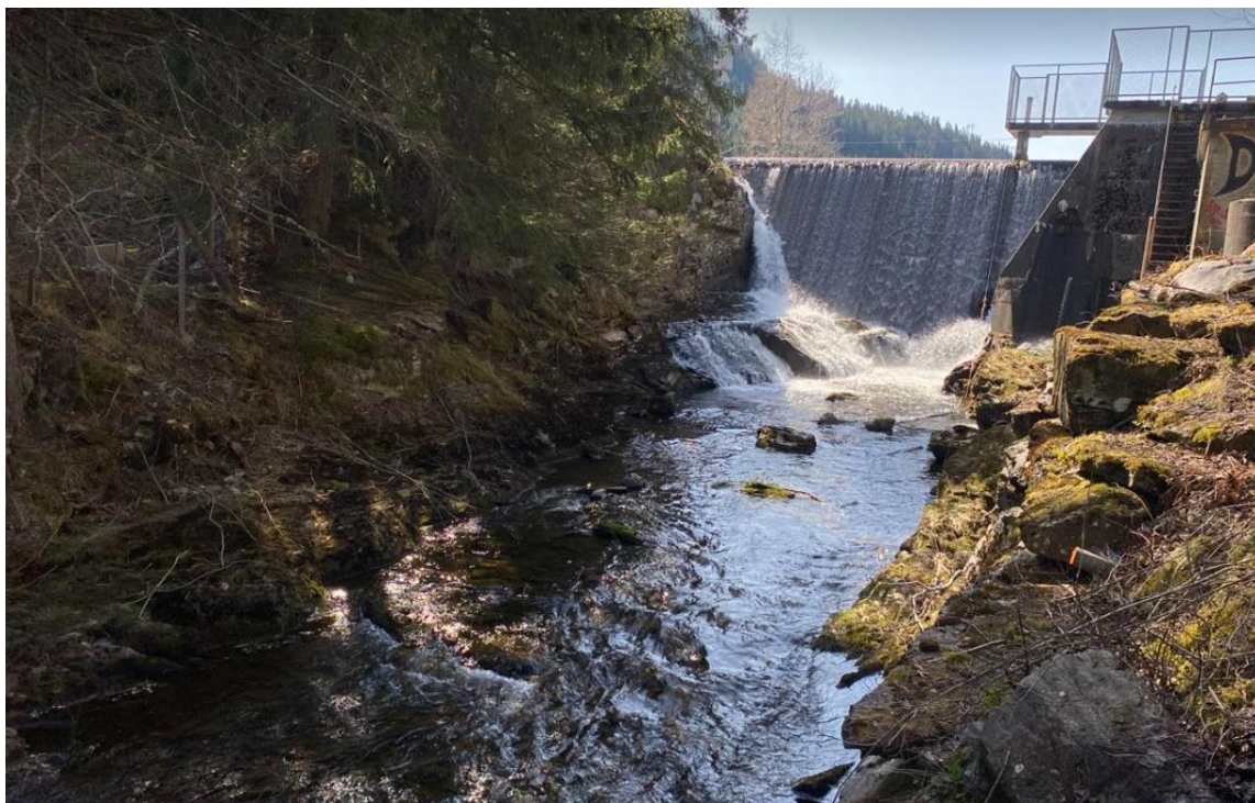
Figur 37. Demning ved Nydammen og Vikelva ovenfor utslippspunktet for kalkslam fra VIVA. Foto: @Morten André Bergan
