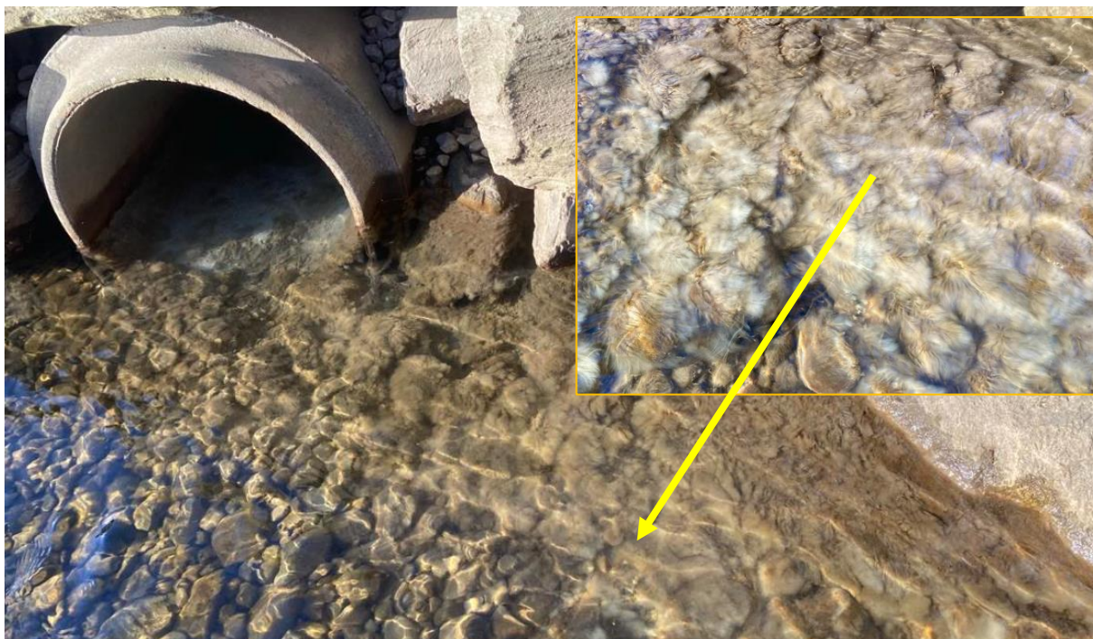
Figur 60. Et øvre utslippsrør til Vikelva ved stasjonsområde 1, og oppblomstring av sopp-/bakteriekolonier nedstrøms. Foto fra mars 2024. Foto: @Morten André Bergan
