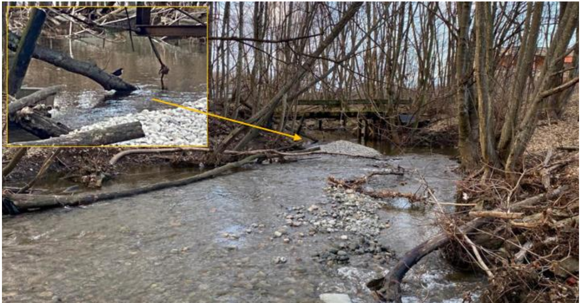
Figur 5. Stasjonsområde 1 sett ovenfra og nedover elva i mars 2024. Innfelt. Fossefall sitter under en gammel bru i stort bilde. Foto: @Morten André Bergan
