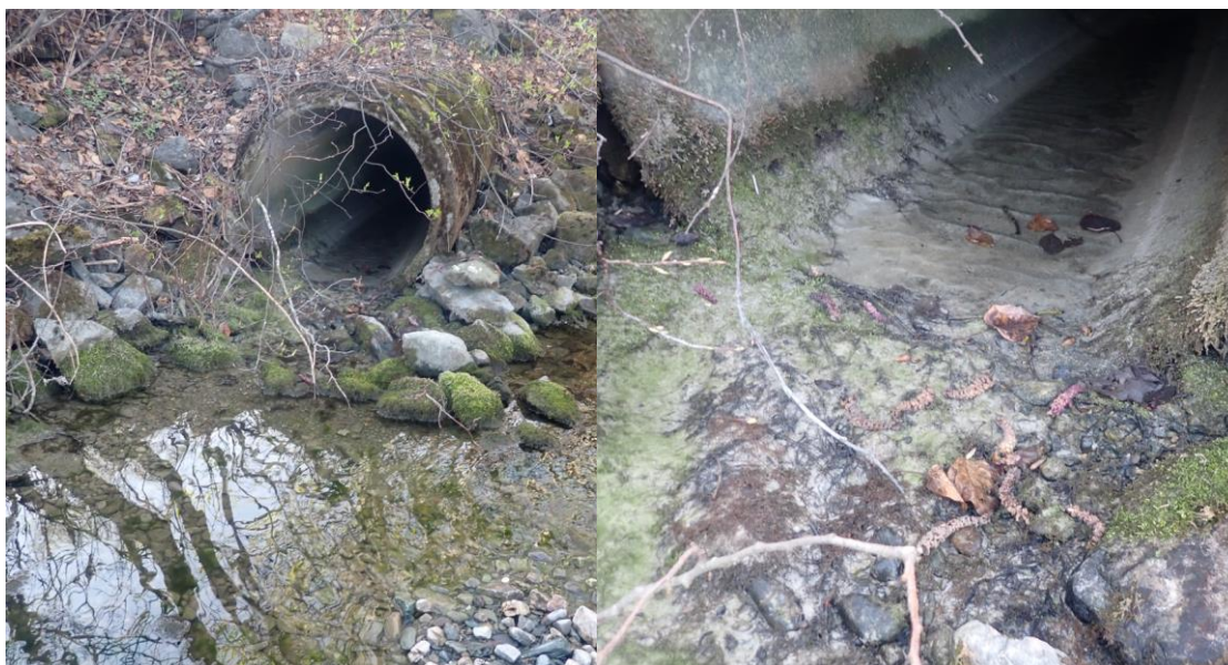
Figur 57. Rør til Vikelva fra E6 i stasjonsområde 2. Foto: @Morten André Bergan
