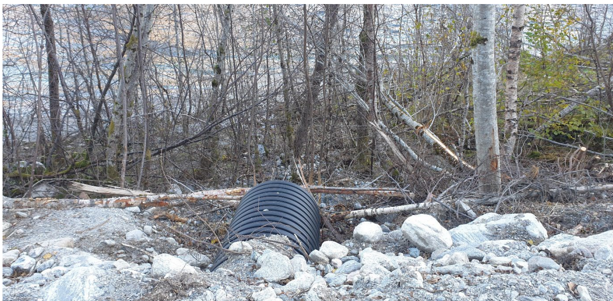
Bilde 10. Nyanlagt vegkulvert i Kvitnesbekken like oppstrøms bekkeutløpet i Eikesdalsvatnet. Foto: Marius Berg.
