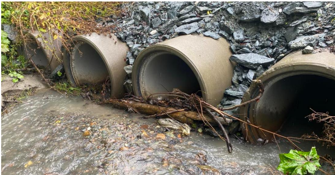
Figur 34. Den nye kulverten under Statsråd Nissens veg i Varmubekken i 2023. Foto ovenfra og nedover i bekken. Foto: @Morten Andre Bergan
