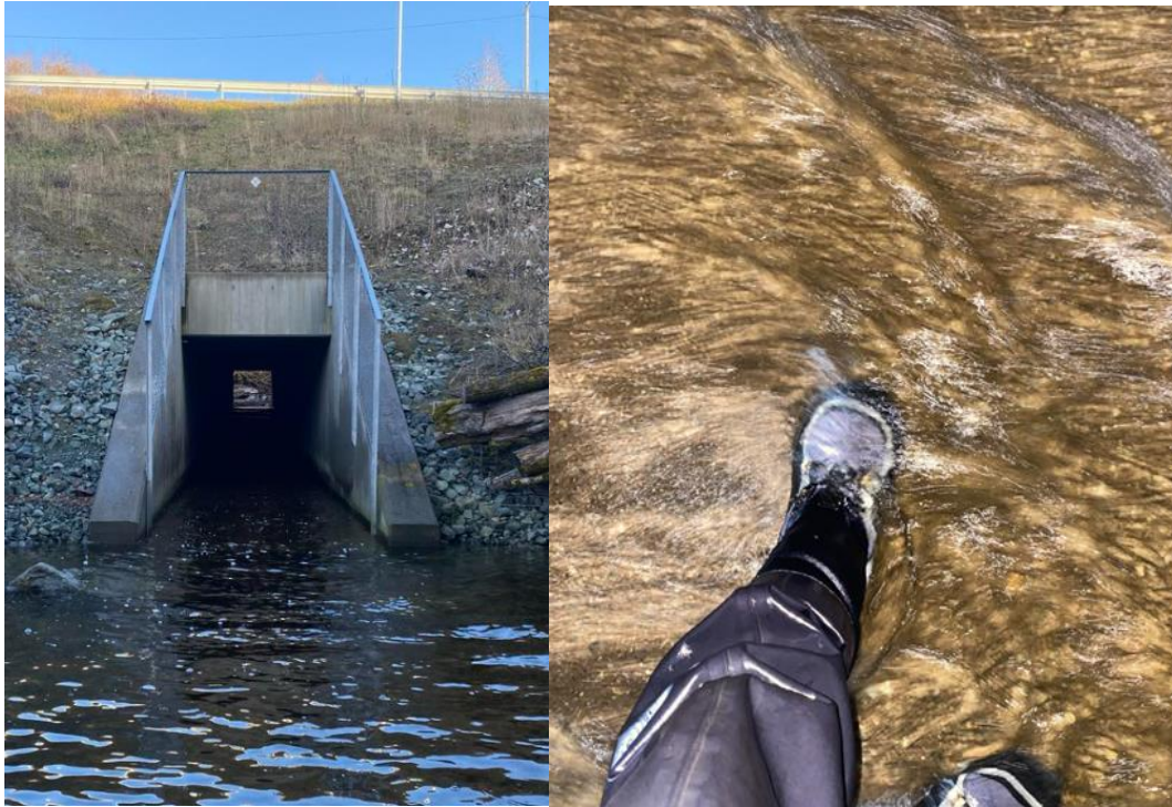
Figur 44. Veikulvert under gamle E6 Kvålsvegen. Foto: @Morten Andre Bergan
