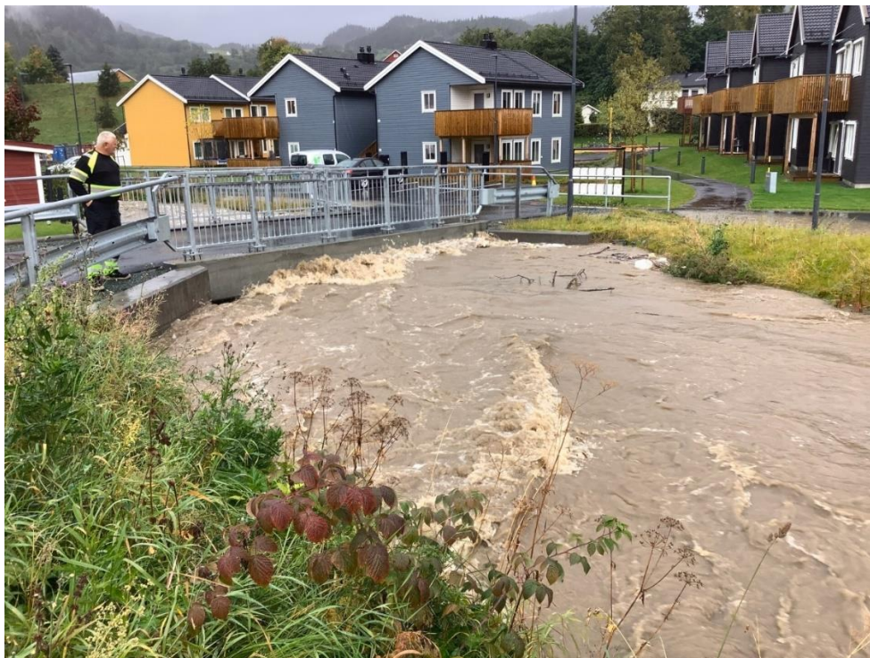
Figur 48. Kaldvella like ovenfor E6 i september 2022. For fisk og biologisk mangfold har Kaldvellas samlede hydromorfologiske inngrepsstatus stor negativ effekt. Bygging av ny bru i 2021, og ytterligere avsmalning av en allerede sterkt kanalisert og avsmalnet elvebredd, synes å ha økt faren for oversvømmelser av vei og boligområder nært elva. Foto hentet fra https://www.melhus.kommune.no/
