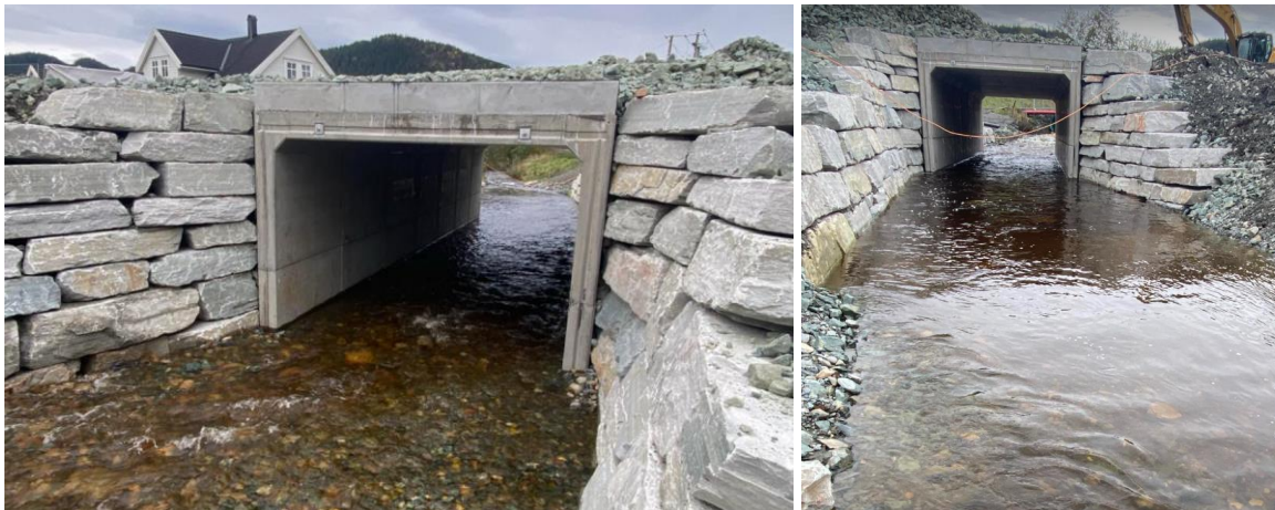
Figur 54. Permanent veikulvert under Nyhusvegen ivaretar fiskevandring, men kunne med fordel vært 1-2 meter bredere. Foto den 10. oktober 2023. Foto: @Morten Andre Bergan
