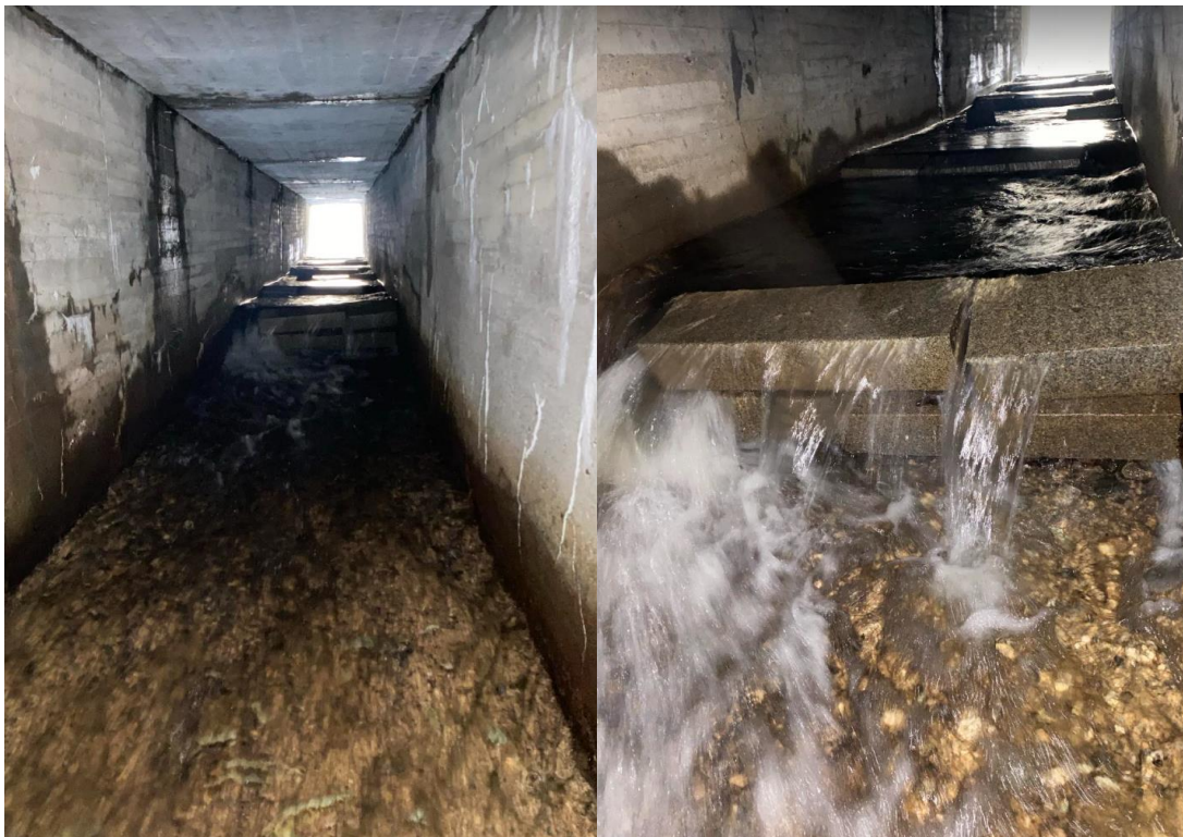
Figur 45. Stablede betongklosser (?) i kulvert under gamle E6. Foto: @Morten Andre Bergan
