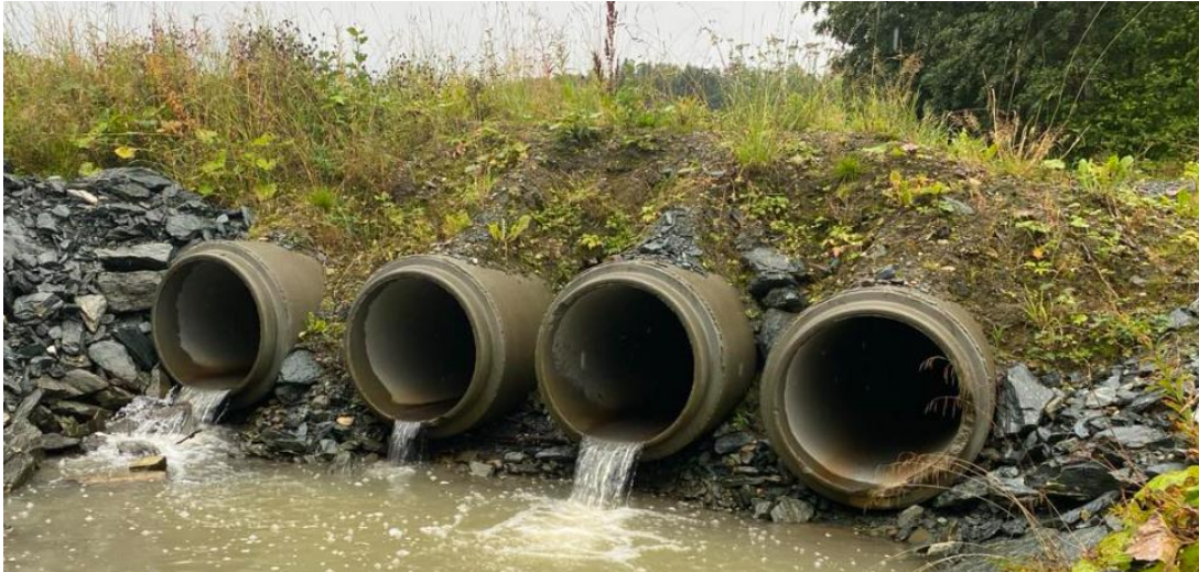
Figur 35. Den nye kulverten under Statsråd Nissens veg i Varmbubekken i 2023. Foto nedenfra og oppover i bekkeløpet. Foto: @Morten Andre Bergan
