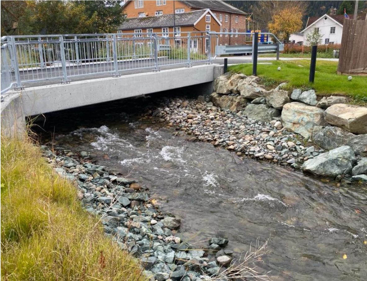
Figur 50. Vassdragspartiet som har fått ny bru i Kaldvella har blitt ytterligere avsmalnet, slik at vannhastigheten er enda høyere. Uten storstein er dette uproduktive, monotone strykstrekninger for fisk, og ytterligere et bidrag i samlet hydromorfologisk belastning på vassdraget. Foto: @Morten Andre Bergan
