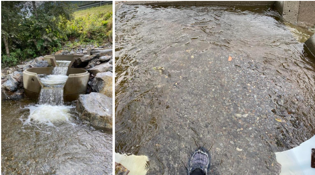
Figur 97. Status for første (t.v.) og siste kulp i Havsbakkbekken's fisketrapp nedstrøms Rørosveien i 2023. Foto: @Morten Andre Bergan
