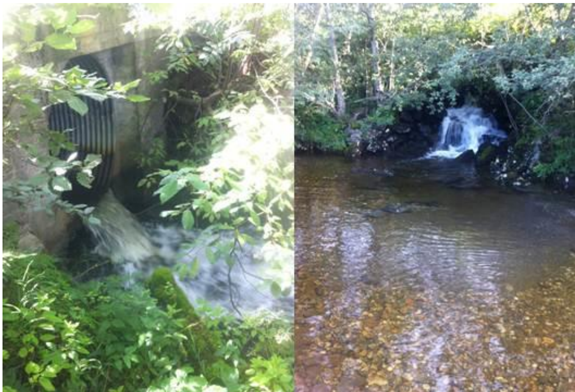
Figur 88. Veikulverten under Rørosveien, som tidligere stoppet all oppgang av sjørørret og laks i Havsbakkbekken. Arkivfoto fra 2011, som viser status før tiltak. Foto: @Morten André Bergan.
