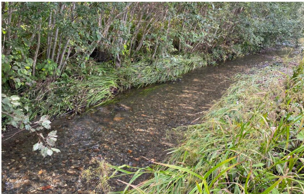
Figur 80. Kanalisert strekning av Skårvollbekken ved industriområde ovenfor Rørosveien i 2023. Foto: @Morten Andre Bergan
