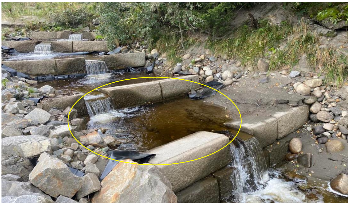
Figur 68. Trinn to med tilknyttet kulp i fisketrappa. Foto: @Morten Andre Bergan
