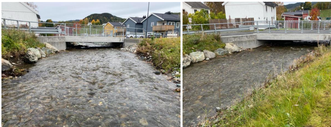
Figur 49. Vassdragspartiet som har fått ny bru i Kaldvella har fått tilført elvestein i gytesubstratstørrelser, men mangler storstein. Det avbøtende tiltaket er derfor bare å anse som halvferdig. Foto: @Morten Andre Bergan
