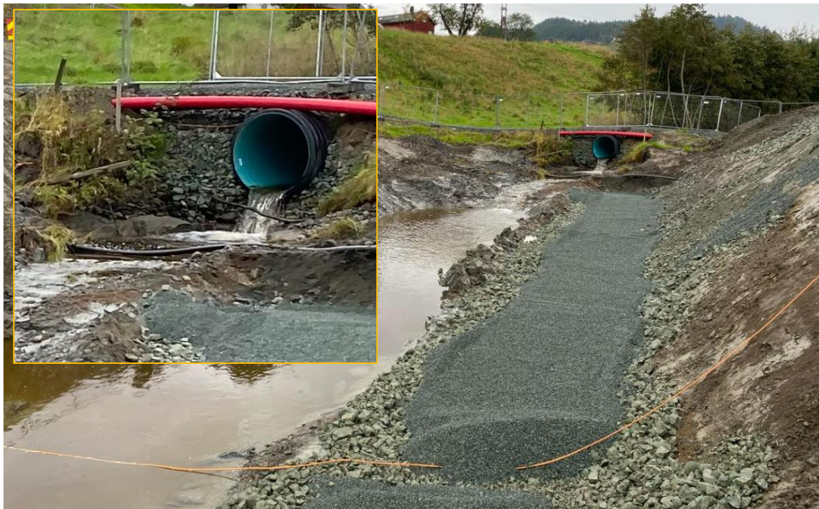
Figur 52. Status i anleggsområdet for ny kulvert i Bortna den 8. september 2023. Midlertidig løsning hindrer eller stopper vandrende gytefisk. Foto: @Morten Andre Bergan
