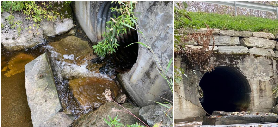
Figur 12. Veikryssning under Fv 707. Foto: @Morten Andre Bergan
