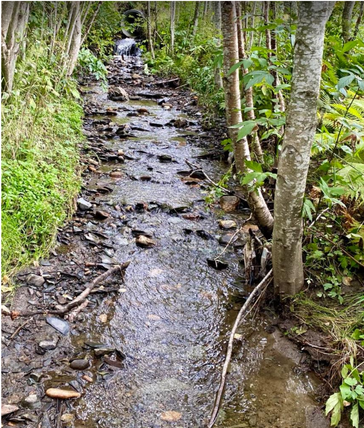
Figur 10. Sidebekk til Gyllbekken nedstrøms vandringsstoppende veikulvert (øverst i bildet). Foto: @Morten Andre Bergan
