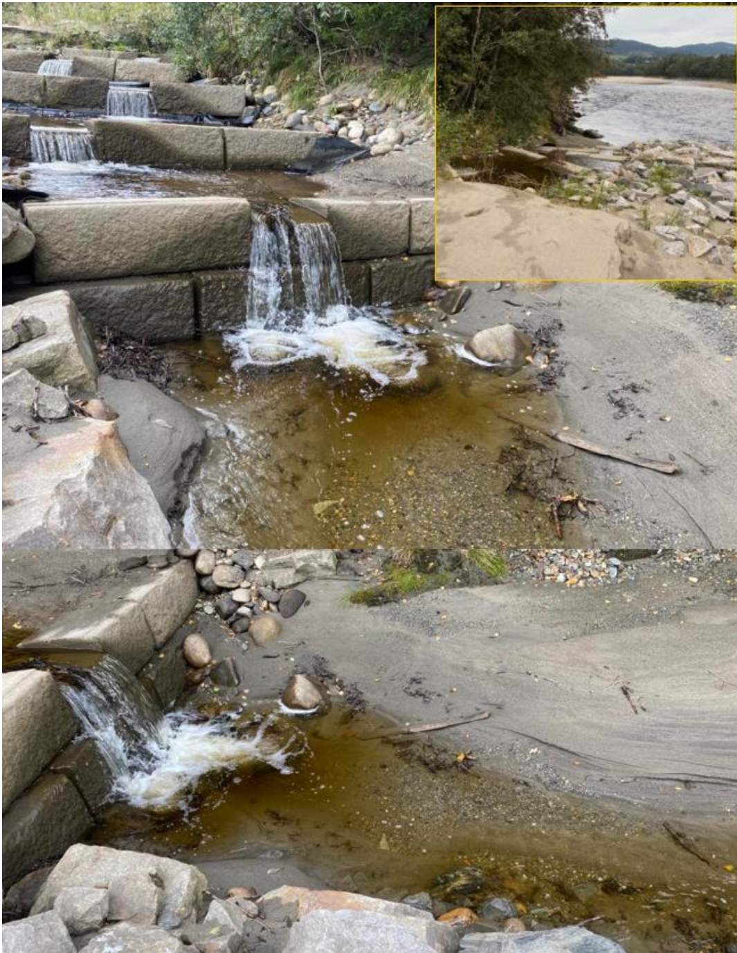
Figur 67. Nederste trinn i fisketrappa, med tidligere satskulp som nå gjenfylt av sand. Foto: @Morten Andre Bergan
