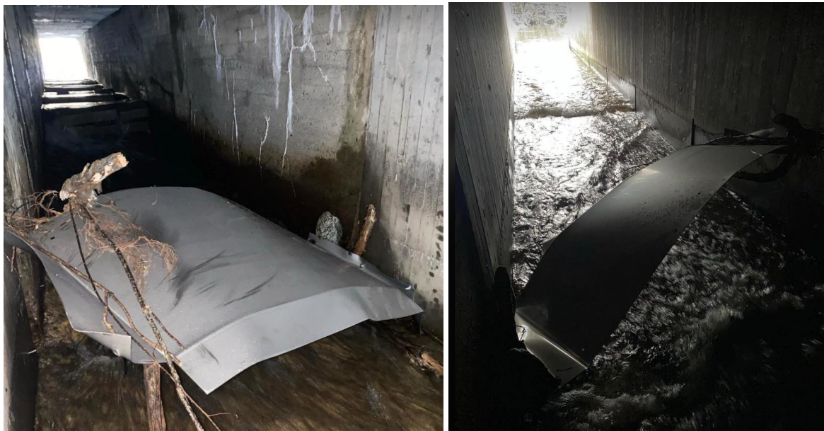
Figur 46. Blikk-konstruksjon montert i kulvertsidene under gamle E6. Foto: @Morten Andre Bergan
