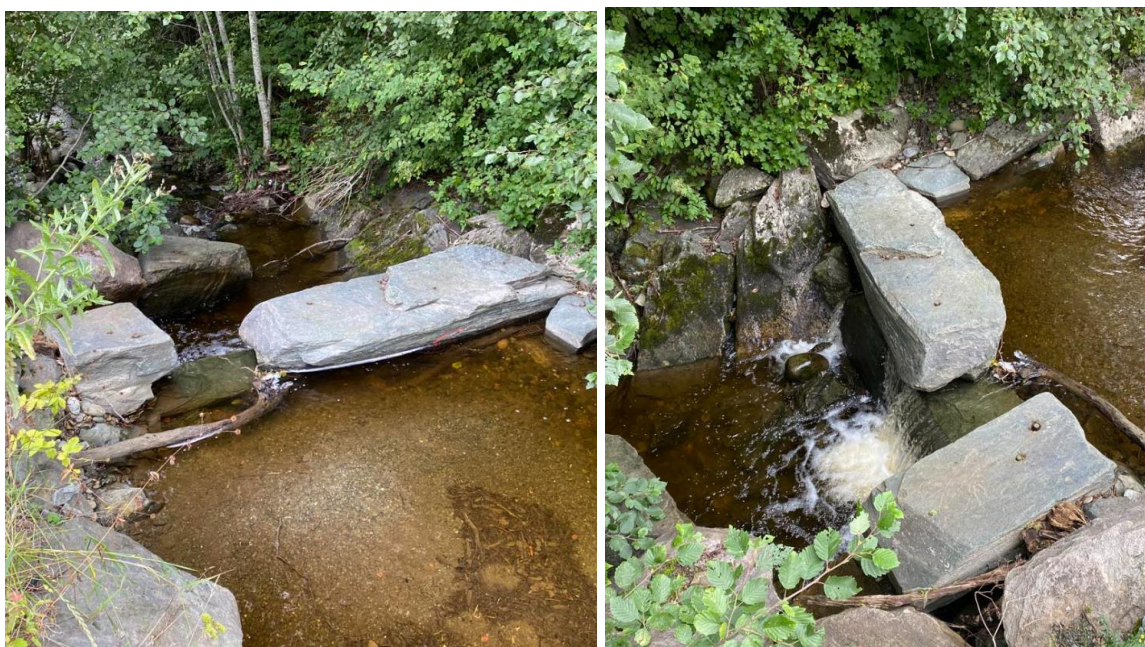
Figur 13. Steinbasert terskel-/trappeløsning i Lauglobekken like nedstrøms kulverten i figur 12 . Status i 2023. Foto: @Morten Andre Bergan
