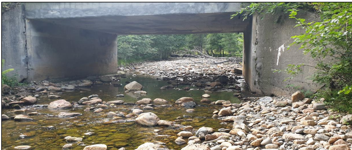
Bilde 24. Noe grovere substrat der Tverrelva krysser Lauvsnesvegen, men med større sammenhengende gyteområder både oppstrøms og nedstrøms. Veg kryssingen er utformet på en god måte, og dekker hele elvas naturlige bredde samtidig som at elvebunnen er bevart.
