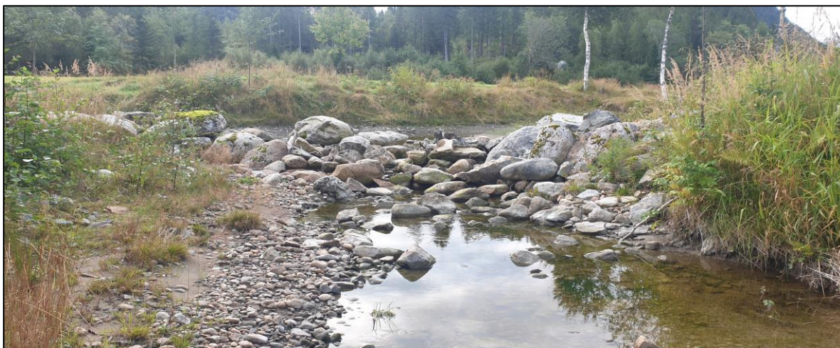
Bilde 15. Det er laget en kunstig kulp i Aunskarelva 30 meter fra utløpet til Oksdøla ved å fylle opp elva med stor stein. Voksen fisk vil trolig ikke klare å gå ut av kulpen når vannstanden går ned.
