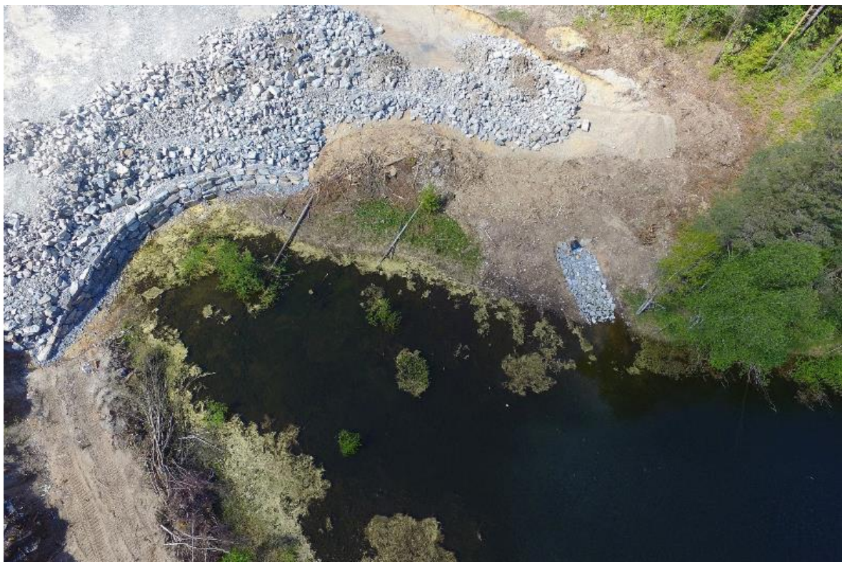
Figur 6. Fyllingsfronten ved dammen på Arsenalet 31. mai 2019. Utløpet til overvannsledningen til høyre midt i bildet. Foto: Eva Kristin Eri, KTP ©
