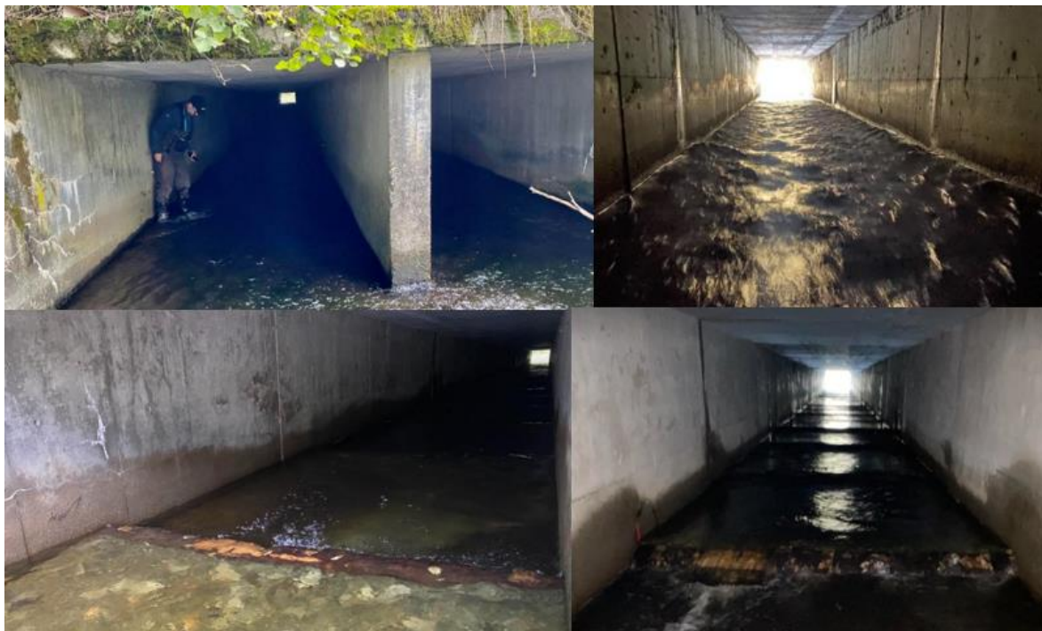
Figur 20. Øverst: Status på dobbelkølvert før tiltak høsten 2023. Nederst: Status etter tiltak. Foto: @Morten Andre Bergan
