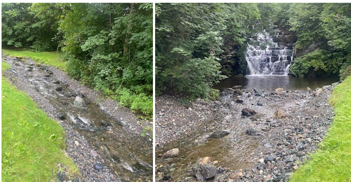
Figur 70. Utlagt gytesubstrat og utgravd kulp nedstrøms foss i Iilabekken i 2023. Foto den 28. august 2023. Foto: @Terje Henrik Nøst
