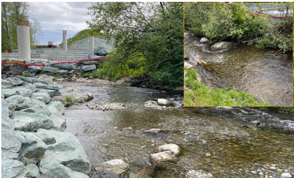
Figur 14. Bildet viser tilført gytesubstrat i nedre del av Leirelva ved Sluppen i mai 2022, i området der ny bru ifbm av-/påkjøringsrampe til E6 bygges. Dette elvepartiet var mer eller mindre uegnet for gyting av laks og sjøørret før tiltak. Samlet årsyngeltetthet av ørret og laks i 2023 var 373,3 fisk per 100 m 2 . Foto: @NINA
