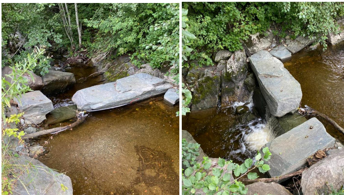
Figur 99. Steinbasert terskel-/trappeløsning i Lauglobekken like nedstrøms kulverten og strekningen vist i figur 98 . Status i 2023. Foto: @Morten Andre Bergan
