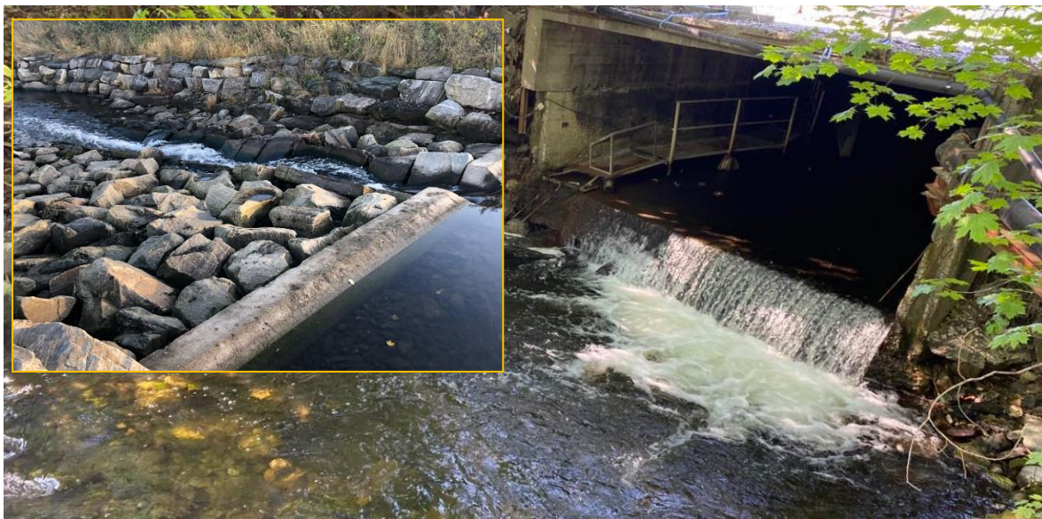
Figur 64. Terskler i nedre del av Vikelva (innfelt), og elvelukkingen nedstrøms papirfabrikken Foto: @Morten Andre Bergan
