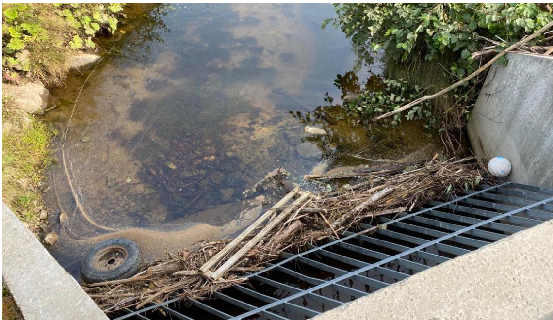
Figur 46. Delvis tilstoppet rist med potensiale for å stenge for oppstrøms fiskevandring i Storvollbekken. Foto fra august 2023. Foto: @Morten Andre Bergan
