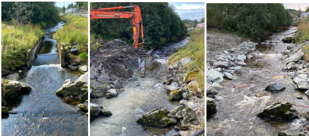
Figur 19. Før (t.v.), underveis (midten) og etter (t.h.) fjerning av en betongkonstruksjon i Leirelva like før samløp med Nidelva. Foto: @ Morten Andre Bergan
