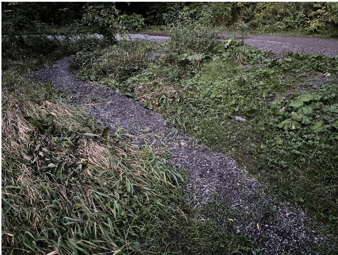
Figur 9. Grus fra turvei langs elva som er ført ut i tilgrensende våtmark etter styrtregn i august 2023.
