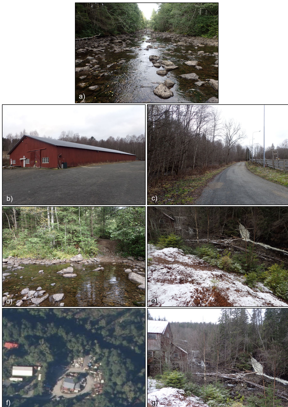
Foto 4.3.1a-f. Kantsoner og menneskelig påvirkning langs Lomma ovenfor Åmot. a. Gode kantsoner ovenfor Guribysagdammen. b. Lommedalen Kjøre- og Rideklubb. c. Adkomstvei til Lommedalen Kjøre- og Rideklubb. d. Vadested brukt av ryttere til hest. e. Sagflis deponert langs elven. f. Lagringsplass ved Lomma ved Guribysaga. g. Guribysagdemningen. Flyfoto i f. er hentet fra Norge i Bilder (2023). Alle andre foto: Jon H. Magerøy.
