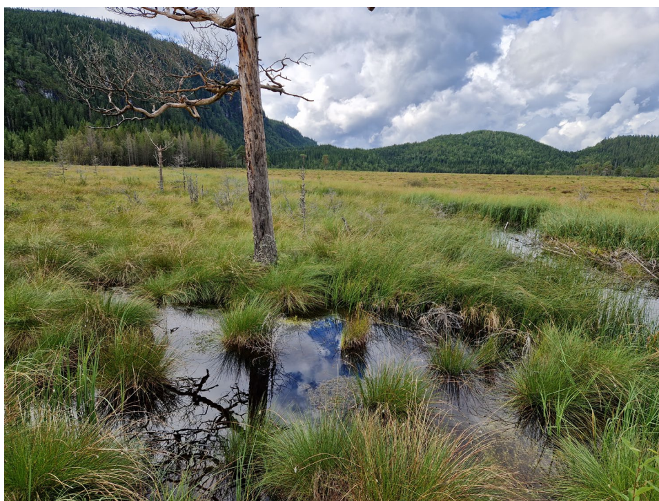
Figur 6. Grøfta på Kaldvassmyra er fortsatt åpen mellom pluggene. Vannspeilet er høyt og tømmer fra skogen som ble fjernet ligger i grøfta. Det er en del gjengroing i kantene av grøfta, men det er fortsatt svært lite vegetasjon i åpne vannspeil langs den tidligere grøfta. Furua i bildet har dødd som en følge av økt vannstand, og dette gjelder flere trær som etablerte seg i perioden med senket vassnivå. Foto: Magni Olsen Kyrkjeide 14.08.2023.
