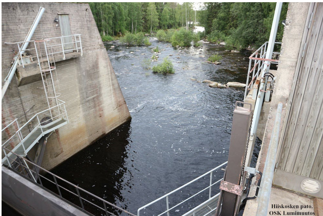
Figure 8. Hiiskoski side dam, Koitäjoki. Photo credit: Tero Mustonen.
