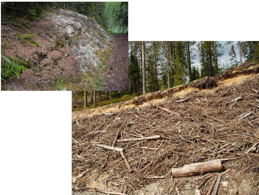
Figur 3.8. Veiskulderen i vest for traktorveien som går langs med dam 1 og 2 ned til Vesle Ossjøen før etablering av rørgata oppe til høyre og etter etablering av kvisthaug som potensiell overvintringsplass for salamander. Foto: Børre K. Dervo ©.
