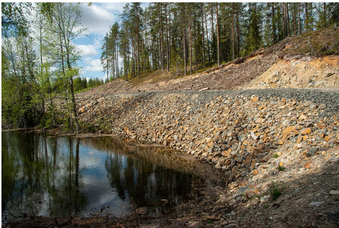
Figur 3.5. Skråning ned mot dam 1 er etablert som et stort salamanderhotell (rødt tall nr 6 i fig 3.1). Foto Børre K. Dervo ©.
