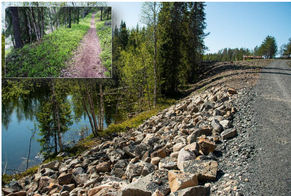
Figur 3.6. Skråning ned mot dam 1 sett mot sør (rødt tall nr 7 i fig 3.1 ). Bilde oppe til høyre er traktorveien i 2020 før etablering av rørgata og ny vei. Foto Børre K. Dervo ©.
