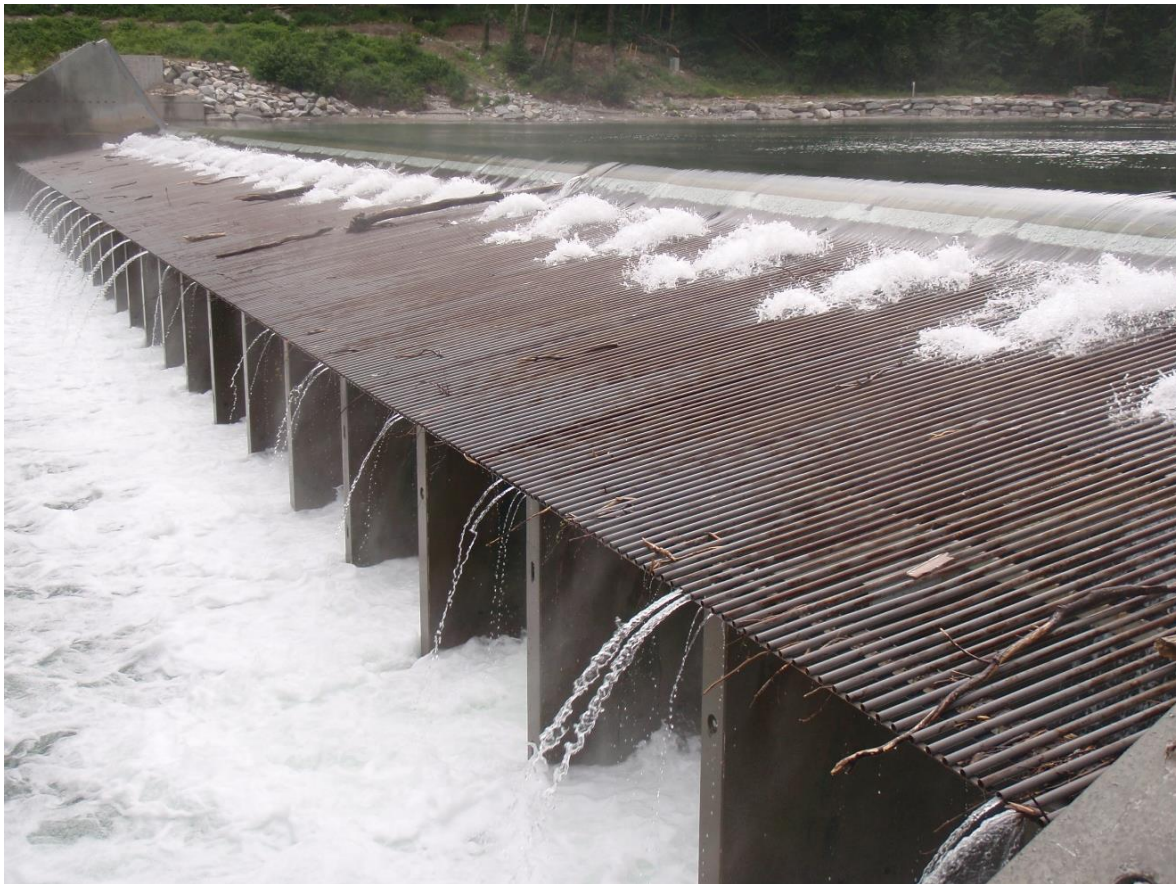
Bilde 2. Etter ombygging har fiskesperra i Driva en lengre rist bestående av metallrør. Denne ristkonstruksjonen tåler vesentlig større vanngjennomstrømming enn den opprinnelige gitterløsningen. Foto: Gunnbjørn Bremset.
