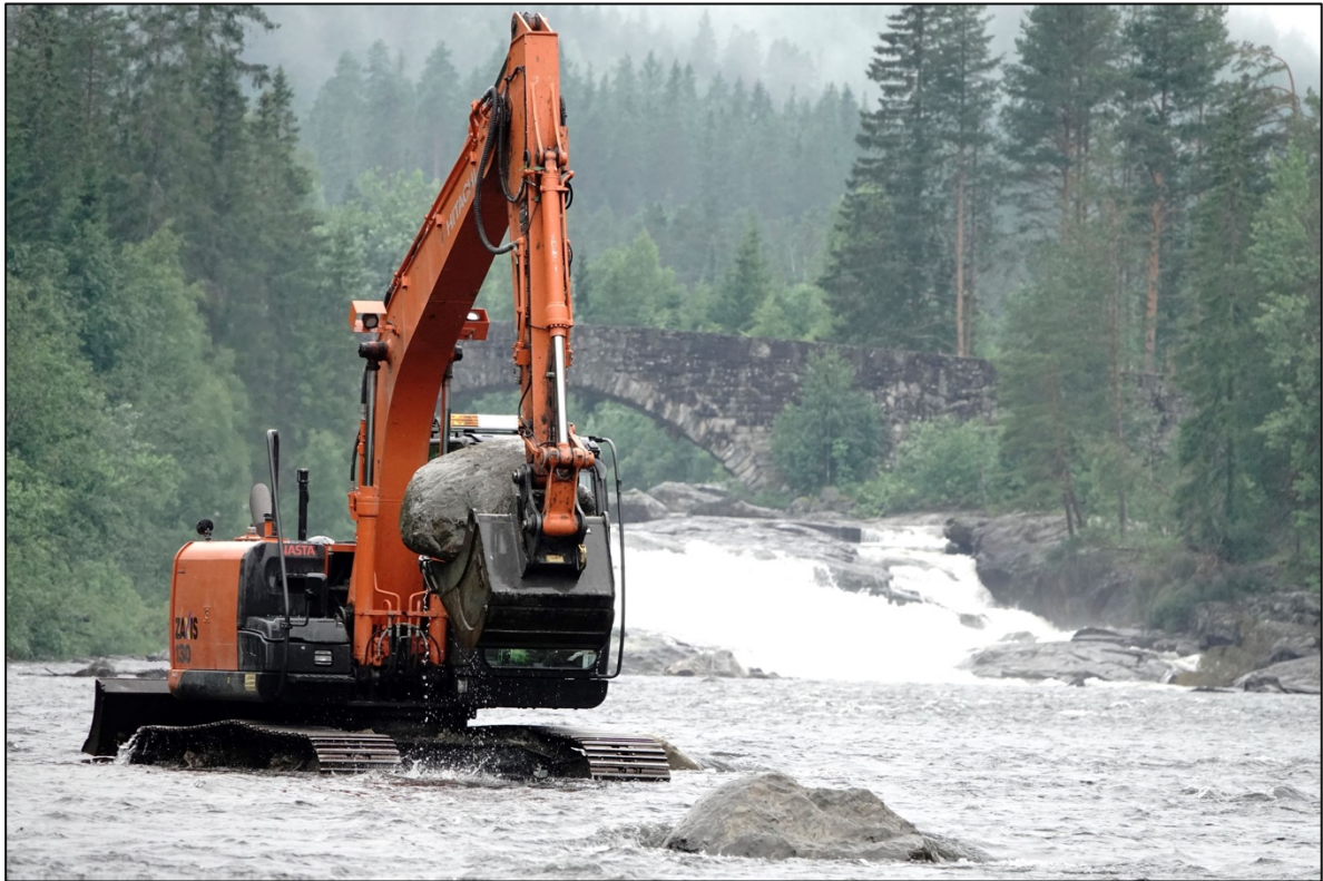
Figur 24. Tilbakeføring av stor stein i Etna ved Lundebrua sommeren 2022. Foto: Geir Høitomt.
