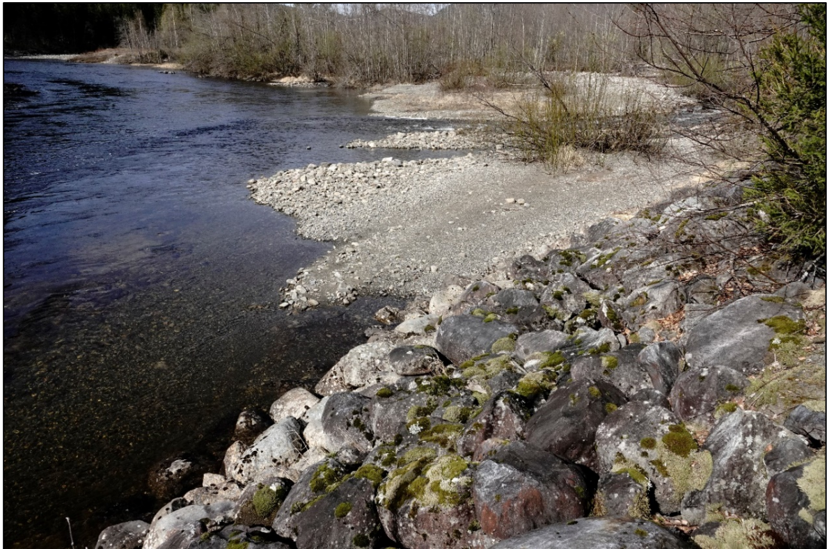
Figur 17. Leppas utløp i Etna, med kanalisert løp i Leppa og forbygning nedover langs Etna. Foto: Geir Høitomt.
