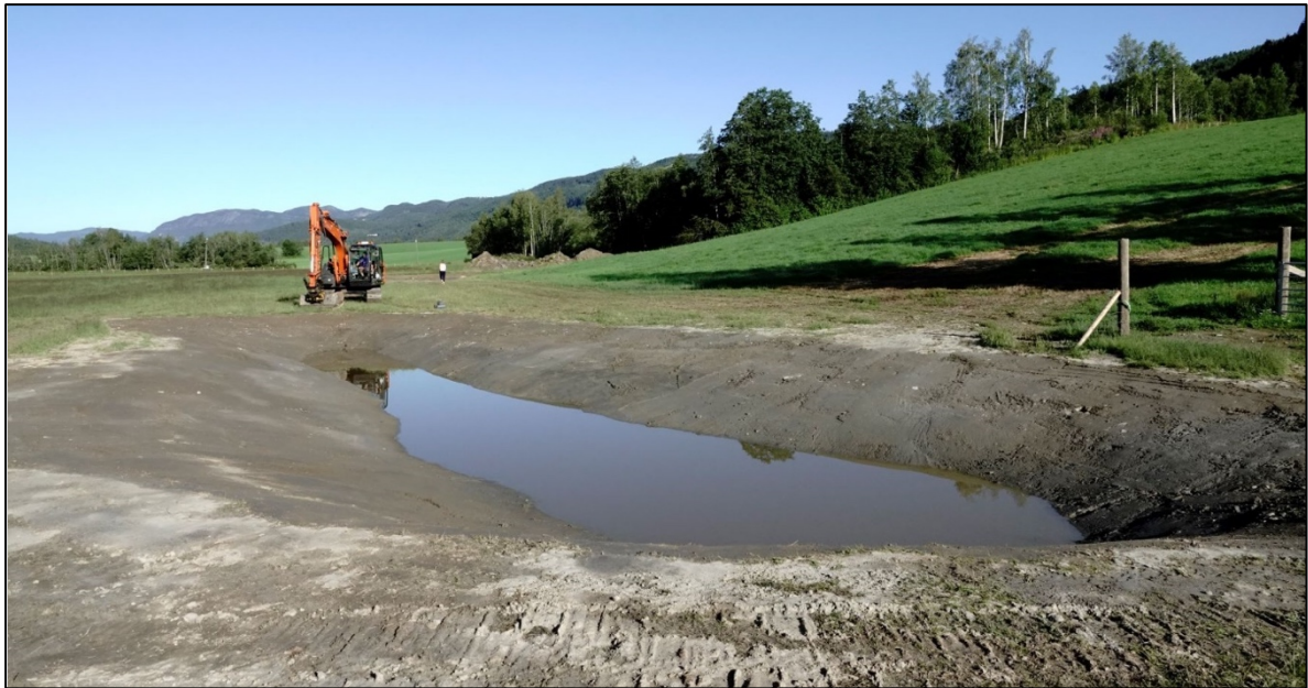
Figur 20. Reetablering av flomdam på dyrket mark langs Etna, ved Røste i Nordre Land kommune. Foto: Geir Høitomt.
