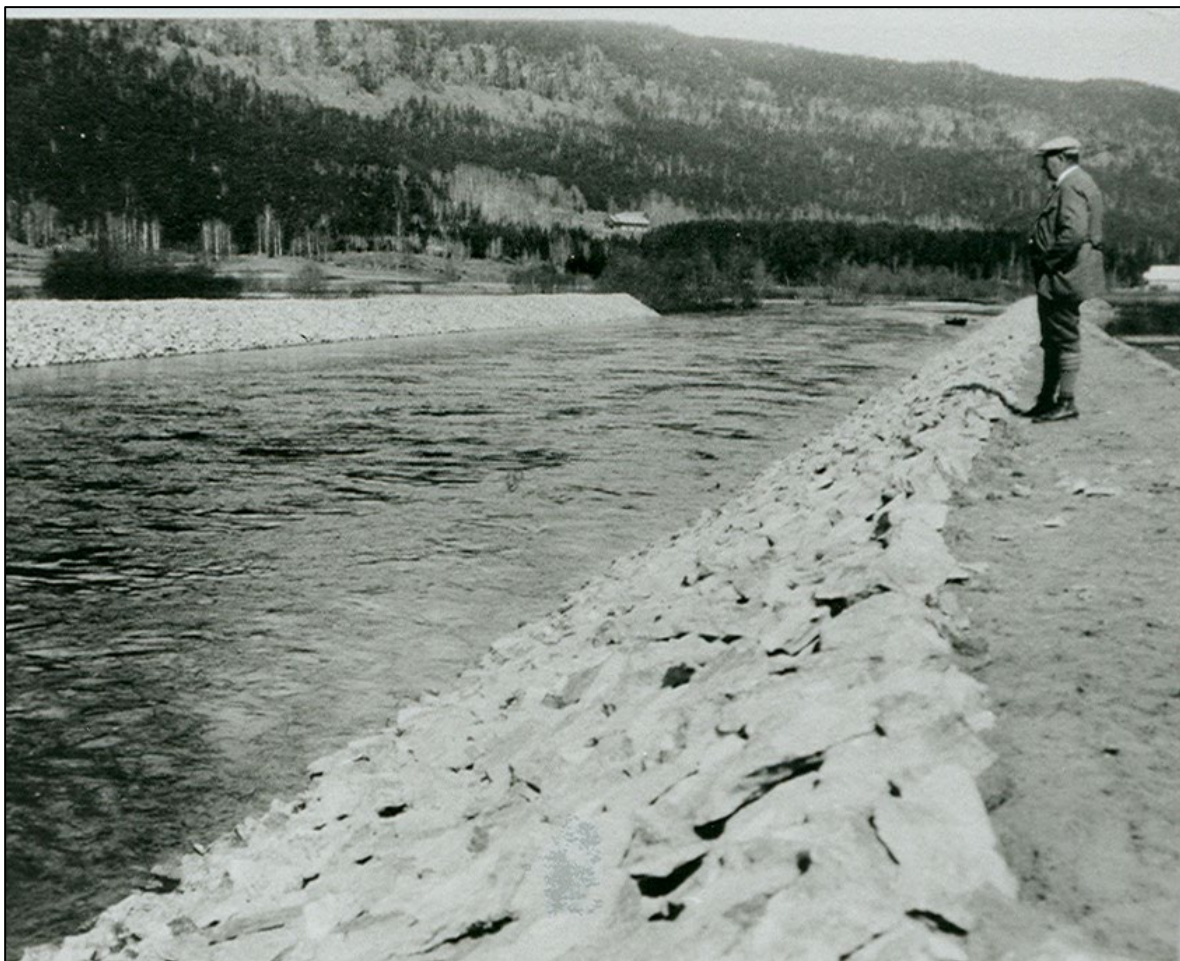
Figur 15. Kanalisering av Etna ved Ulvshus på Nordsinni. Gammelt foto utlånt av Randsfjordmuseene. Bildet er tatt ca. 1930.
