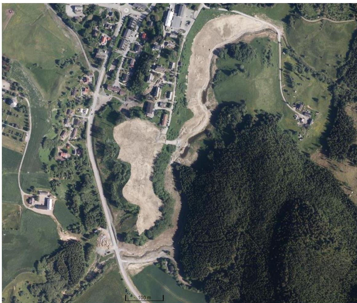
Figur 46. Storvollbekken og partier som nylig har gjennomgått rassikring og restaurering. Flyfoto fra 2019. Flyfoto: https://kart.finn.no/
