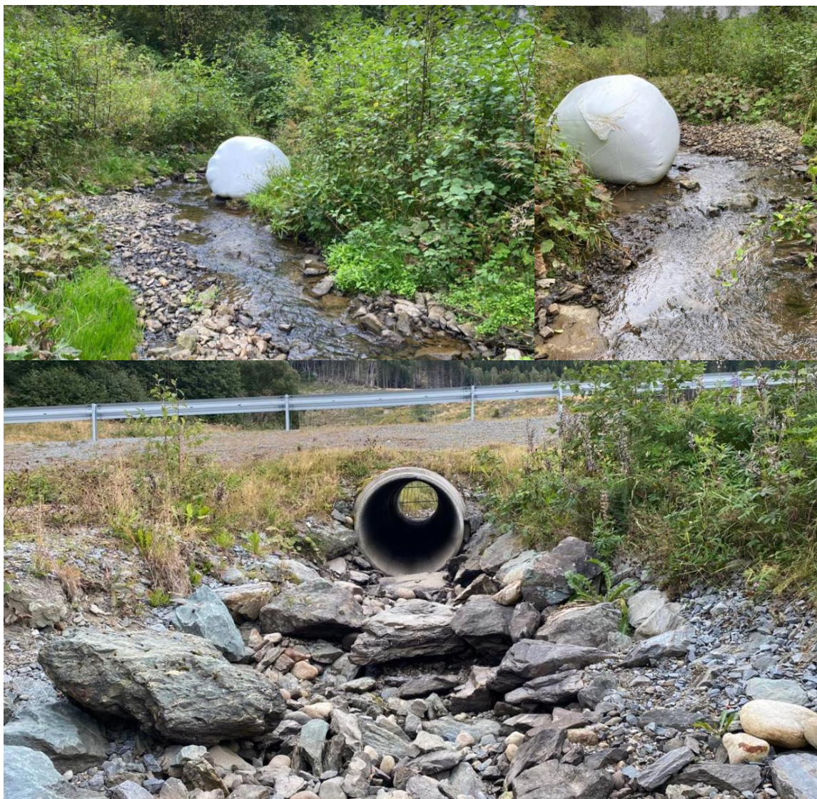
Figur 47. Foto fra 12. september 2022. Nye og gamle rundballer har ligget strødd i bekkeløpet nedstrøms Sveanvegen de siste tre årene (øverst), og nylig steinsatt strekning i bekkeløpet like nedstrøms Sveanvegen går helt tørr (nederst). Foto: @Morten André Bergan/NINA.
