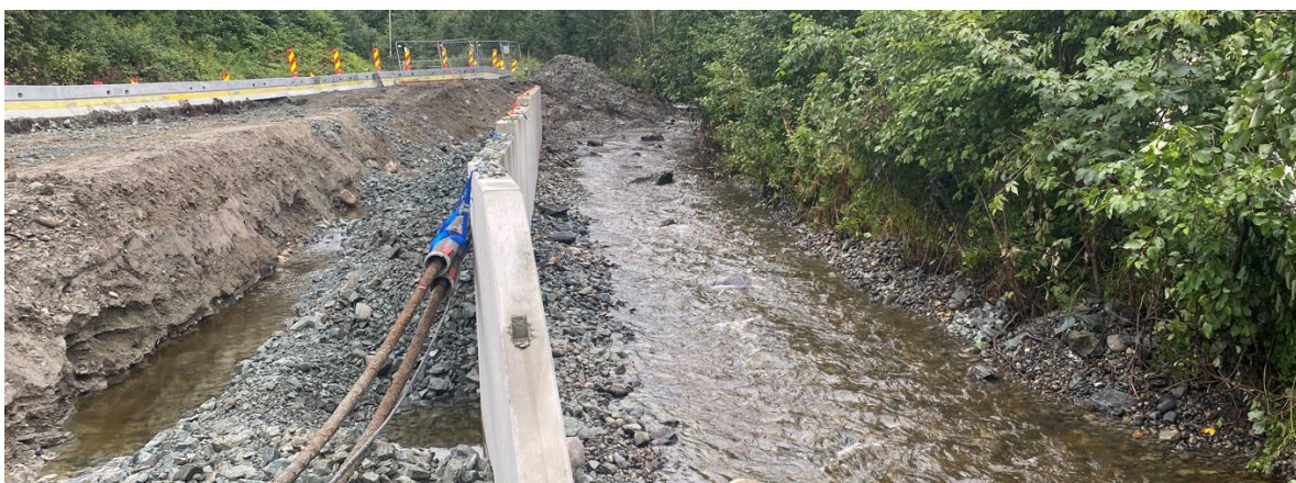
Figur 11. Oppføring av støttemur for vei mot elva medførte gravearbeider i og ved Leirelva i 2022 ved stasjonsområde 7. Foto: @Morten André Bergan/NINA.
