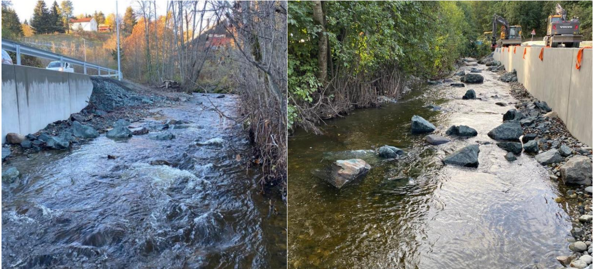
Figur 12. Nyrestaurert strekning etter anleggsarbeidet var ferdig ved Forsøkslia og stasjonsområde 7. Foto: @Morten André Bergan/NINA.
