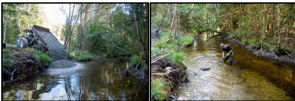
Foto 4.4.5-2. Utlegging av gytegrus i Lerangsbekken. Foto: Jarle Lunde.
