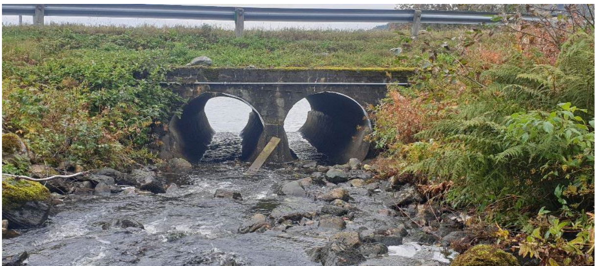
Bilde 1. Utløpsområdet til sjø. Kulverten til høyre på bildet stenger for oppvandrende fisk på grunn av stein og grus.
