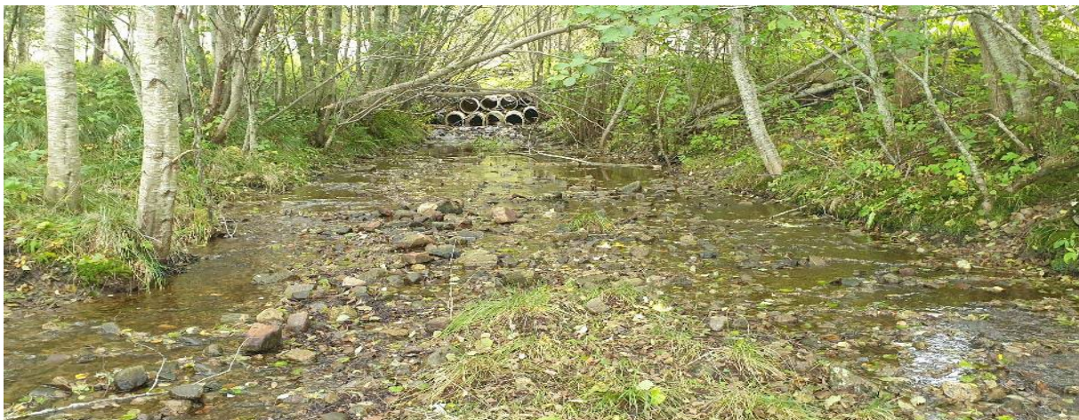
Bilde 2. Svært uheldig kulvertløsning under traktorveg som tettes igjen med kvist og annet organisk materiale og danner et hinder og delvis barriere for fisk.
