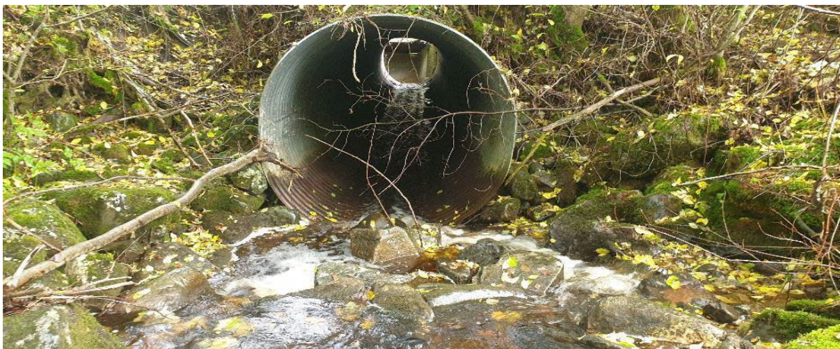
Bilde 1. Kulvert som leder ned til betongkumme ved vegkryssningen med fylkesveg 6430.
