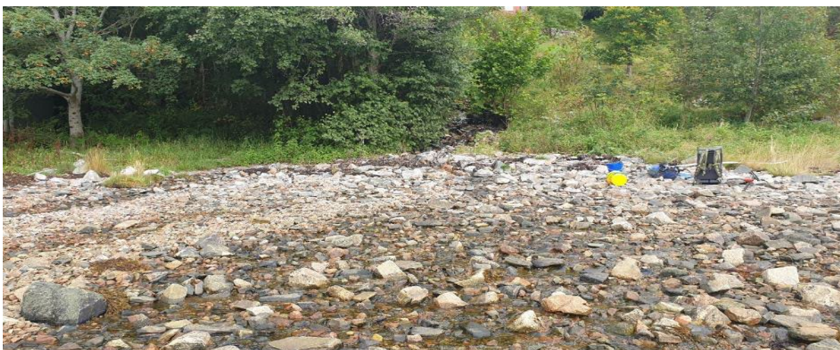
Bilde 1. Utløp i sjøen mangler definert løp.
