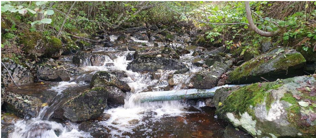
Bilde 2. Det som trolig er overvannsledning fra nærliggende bolighus er ført ut i elva.
