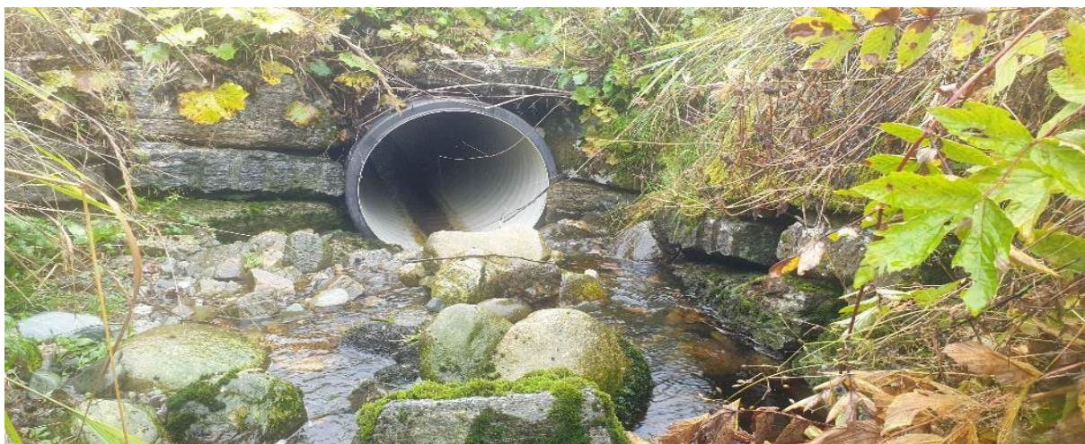
Bilde 1. Oversiden av kulvert som i dag er vandringsbarriere.
