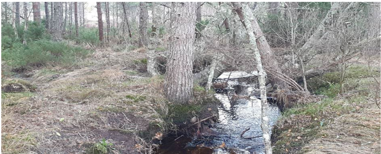
Bilde 5. Det andre bekkeløpet som krysser Mistfjordvegen via kulvert og går videre opp til Stavnesvatnet.
