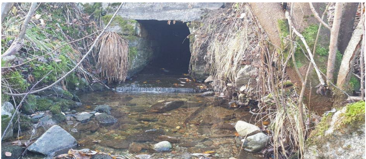
Bilde 3. Kulvert under veg. Stein har rast ut inni kulverten og oppvandrende fisk stopper derfor her.
