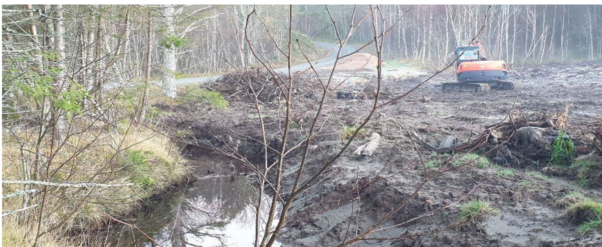
Bilde 6. Pågående grøftearbeider. Bildet er tatt 3.november 2021.
