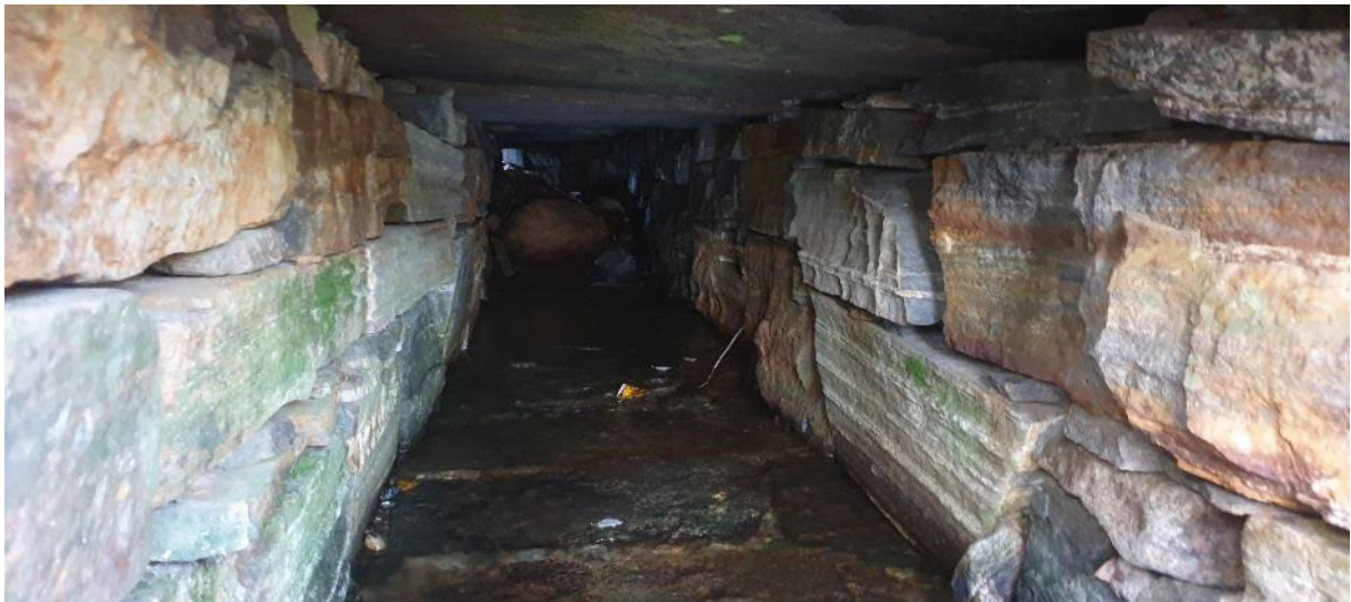
Bilde 4. Steinblokk som har rast ut i bekken og sperrer for oppvandring.
