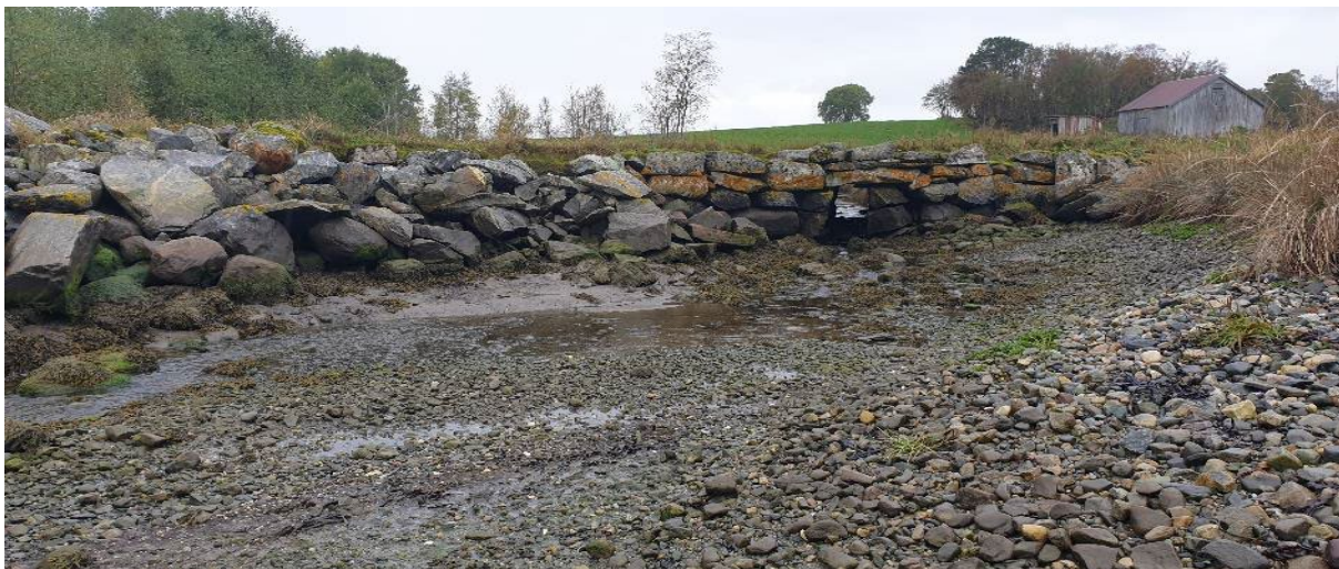
Bilde 2. Kulvert under Vollanesveien.
