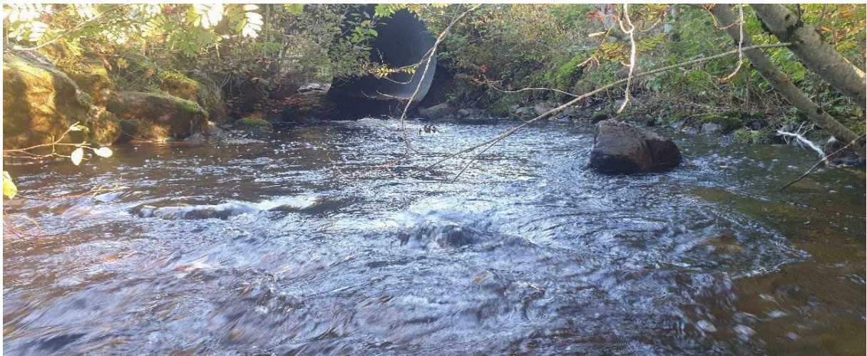
Bilde 4. Kulvert under Gjengstøveien. Det ble etablert en el-fiskestasjon nedstrøms kulverten.
