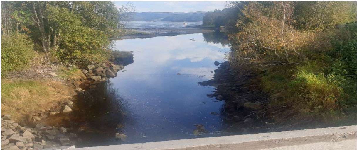
Bilde 1. Utløpet av Lerneselva ved Fitjavågen.
