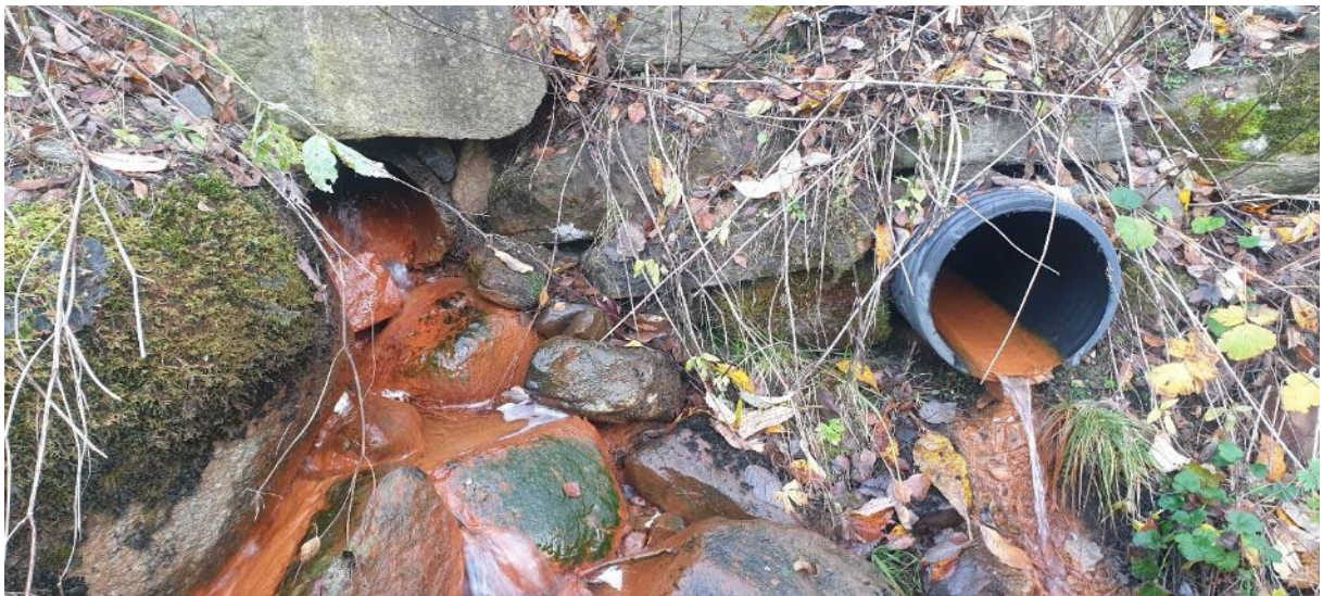
Bilde 3. Utløp av overvann fra bolighus/småbruk oppstrøms Røøyveien med tydelig jernutfelling.
