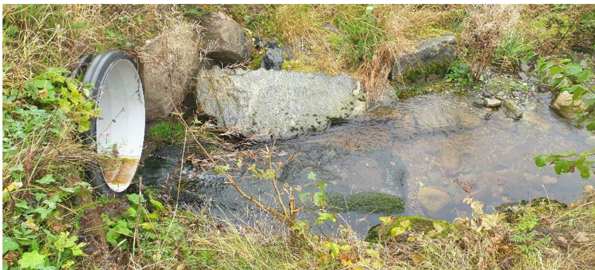
Bilde 2. Nedstrøms kulvert.
