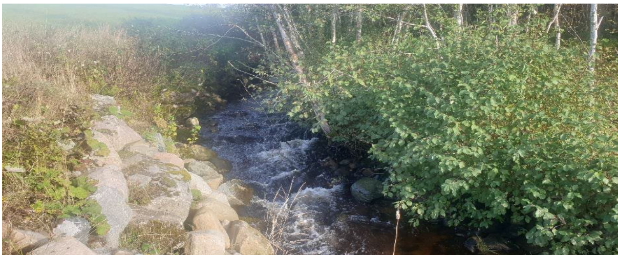
Bilde 2. Oppstrøms kulvert under Bjørknesveien.
