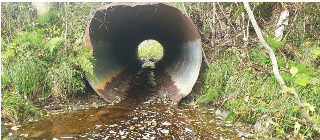
Bilde 1. Kulvert rett før utløpet til Hollaelva.
