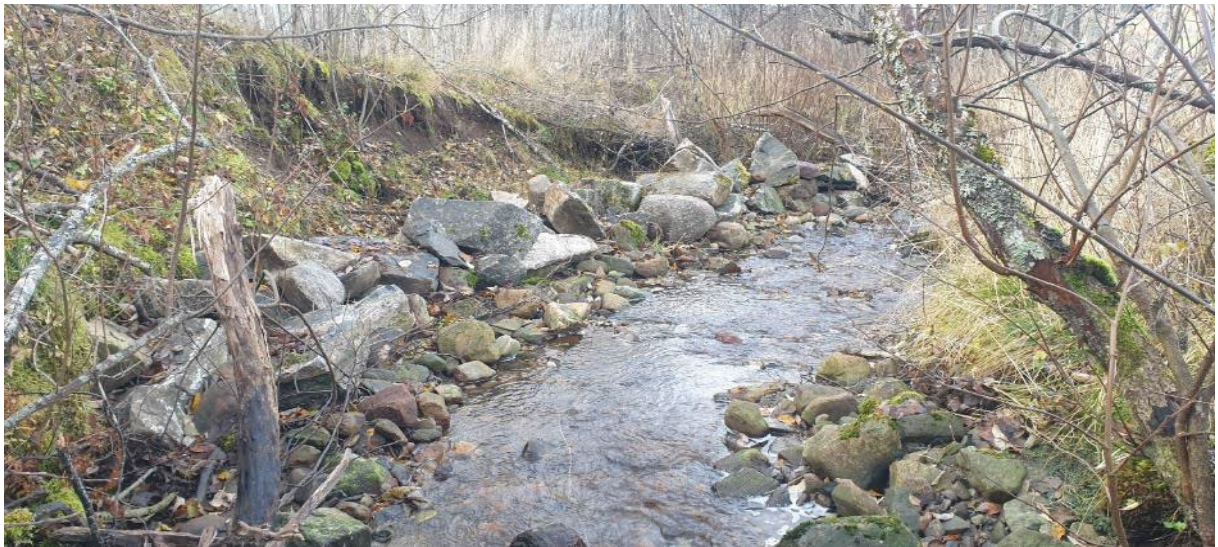
Bilde 2. Forbygning som ser ut til å være anlagt i nyere tid.
