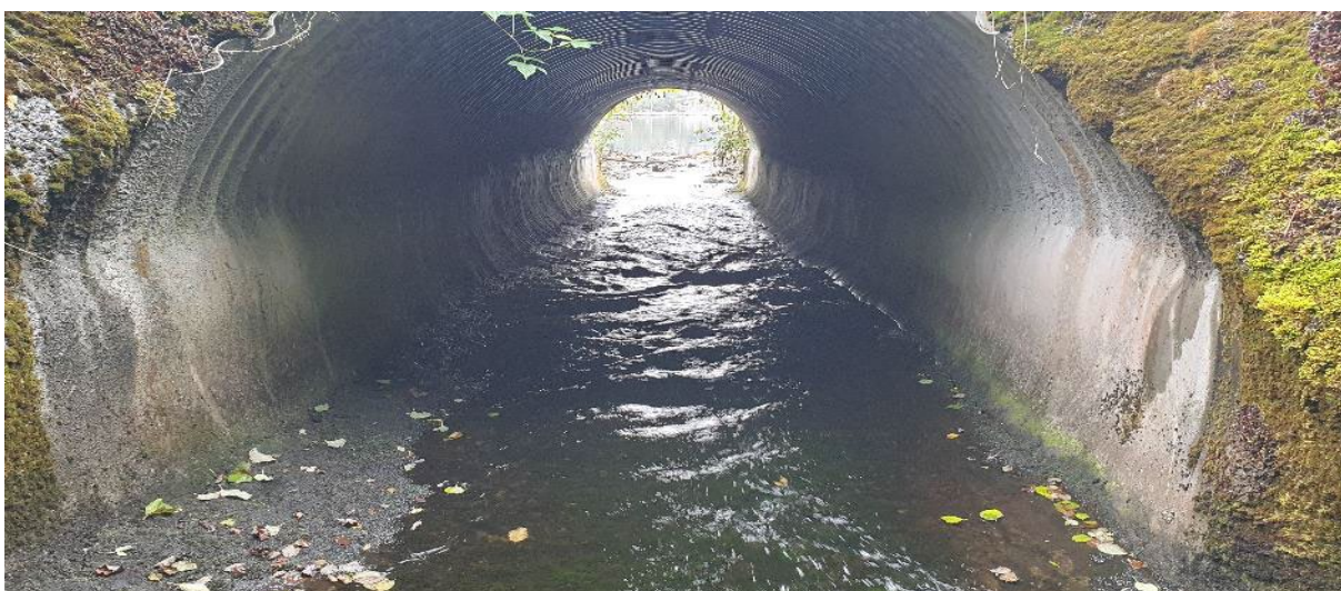
Bilde 1. Kulvert under fylkesveg 6432 i Karlsneselva med støpt betong i bunn.
