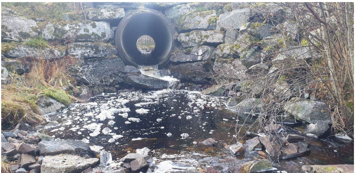
Bilde 6. Kulvert under Mistfjordvegen. Denne utgjør en barriere på lav vannføring.
