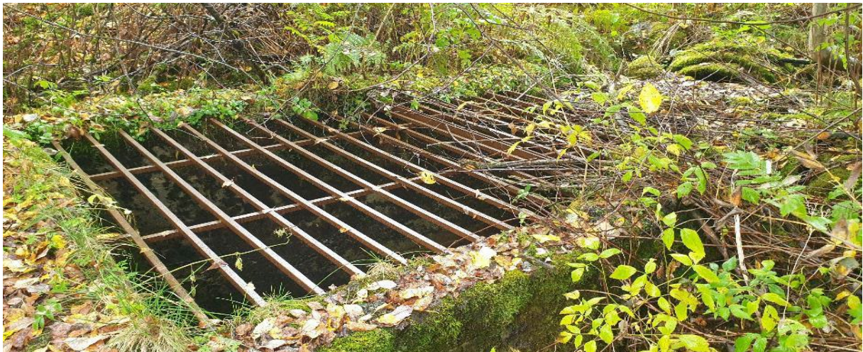
Bilde 3. Betongkumme som leder vannet fra stasjonær del av Alstadbekken i lukket rørgate forbi industriområdet ved Grøtvågen. Den anadrome strekningen er tapt for laksefisk.
