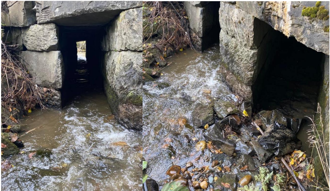
Figur 51. Stikkrenner under jernbane etter at NINA har ryddet vandringsveien for sjøørret. Foto: @NINA.
