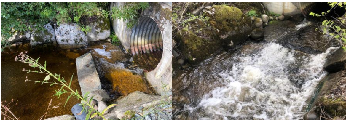
Figur 8. Veikrysning under Fv 707. Foto etter tiltak i 2022 (til venstre) og før tiltak i 2021 (til høyre). Foto: NINA.
