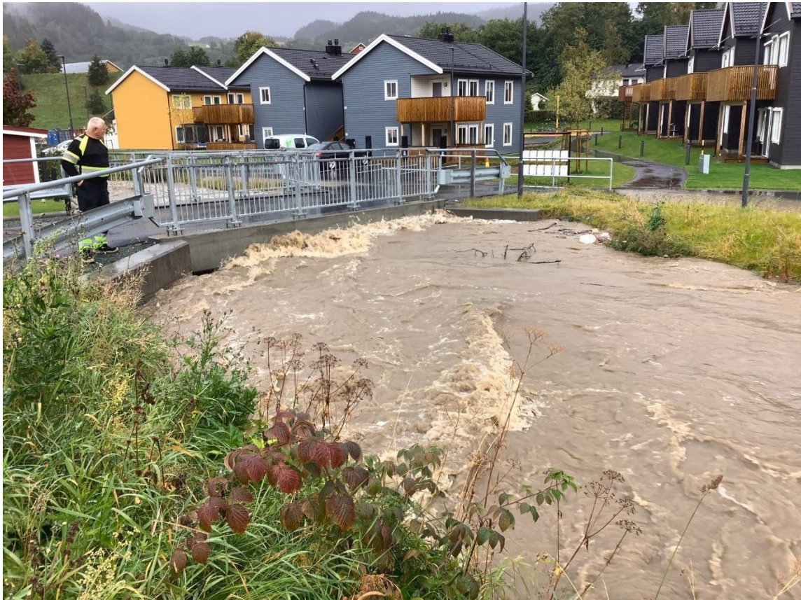
Figur 33. Kaldvella like ovenfor E6 i september 2022. For fisk og biologisk mangfold har Kaldvellas hydromorfologiske inngrepsstatus stor negativ effekt. Bygging av ny bru i 2021, og ytterligere avsmalning av en allerede kanalisert og avsmalnet elvebredd, synes å øke faren for oversvømmelser av vei og boligområder nært elva. Foto hentet fra https://www.melhus.kommune.no/
