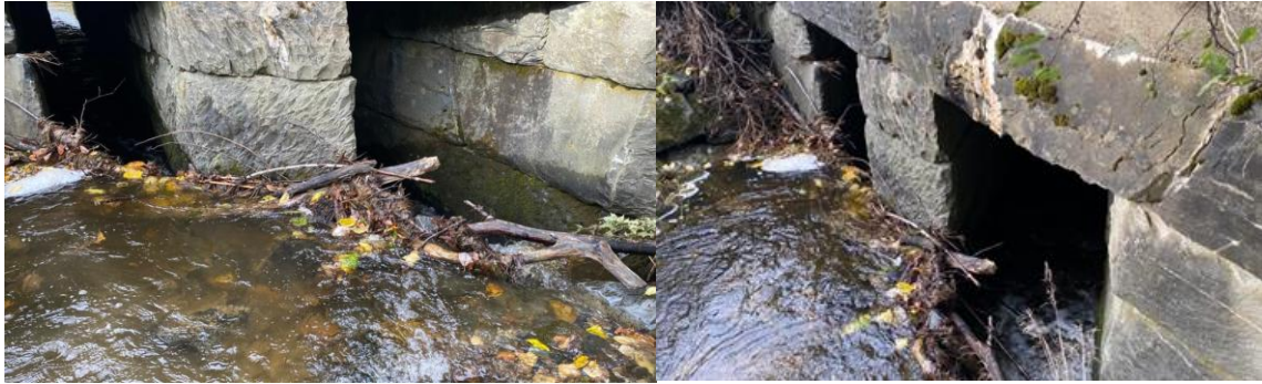
Figur 50. Stikkrenner under jernbane høsten 2022, før rydding. Foto: @NINA.
