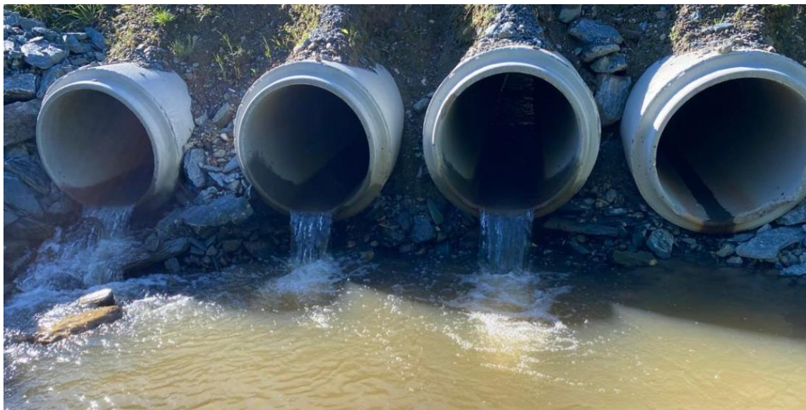
Figur 27. Sterkt vandringshindrende kulvert er lagt i Varmbubekken i løpet av det siste året. Se også denne rapporten forsidebilde. Foto: NINA.
