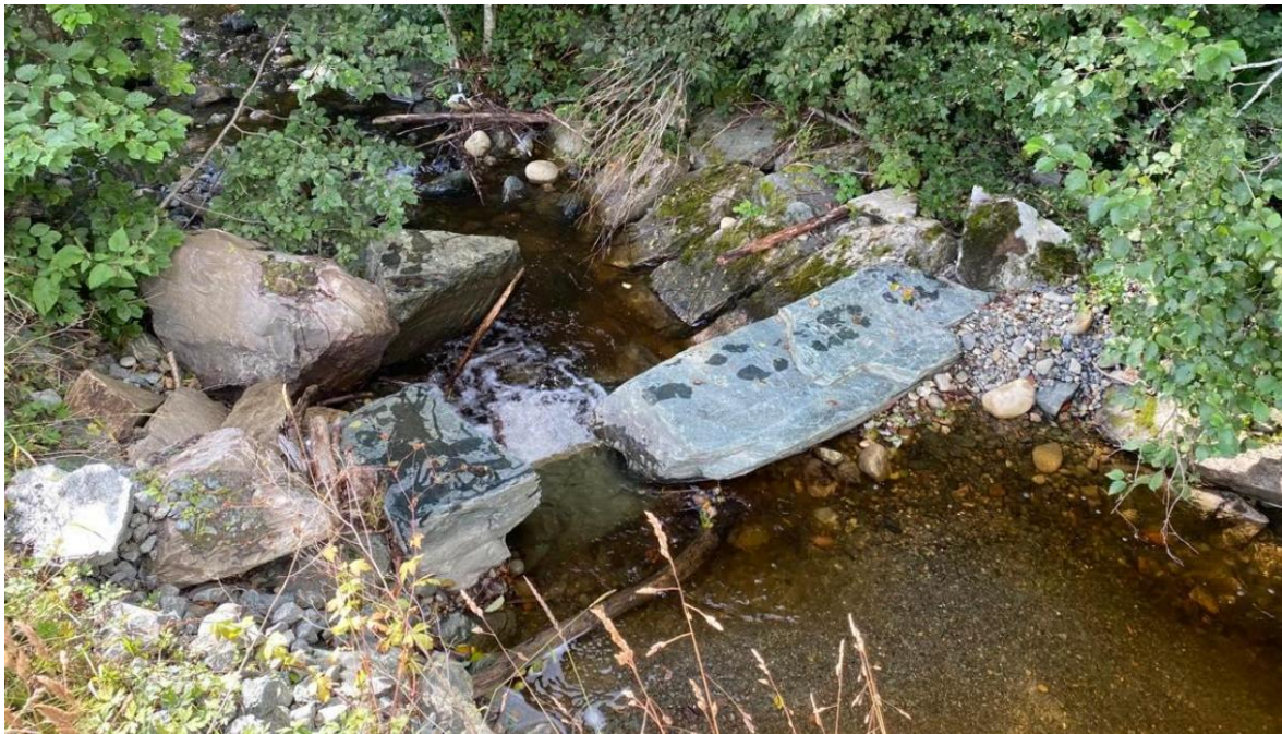
Figur 9. Steinbasert terskel-/trappeløsning i Lauglobekken like nedstrøms kulverten og strekningen vist i figur 8. Foto: NINA.
