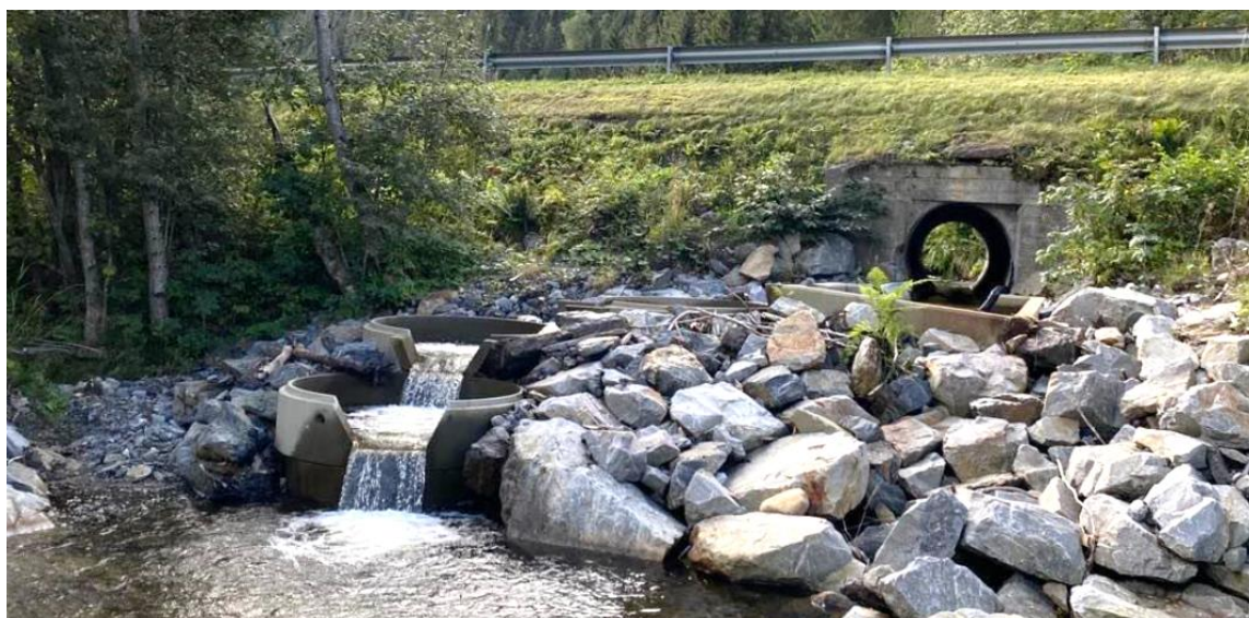
Figur 61. Den nye fisketrappløsningen i Havsbakkbekken. Status i 2022, etter tiltak på bekkepartiet vist i figur 60 . Foto: Morten André Bergan.
