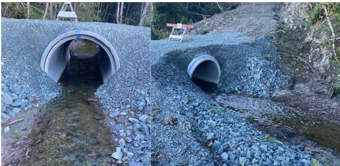
Figur 41. Ny kulvert over bekken i tilknytning til skogs- og anleggsarbeid er fiskeførende, men har samtidig redusert gyte- og oppvekstmulighetene for laksefisk på den berørte strekningen. Foto: NINA.
