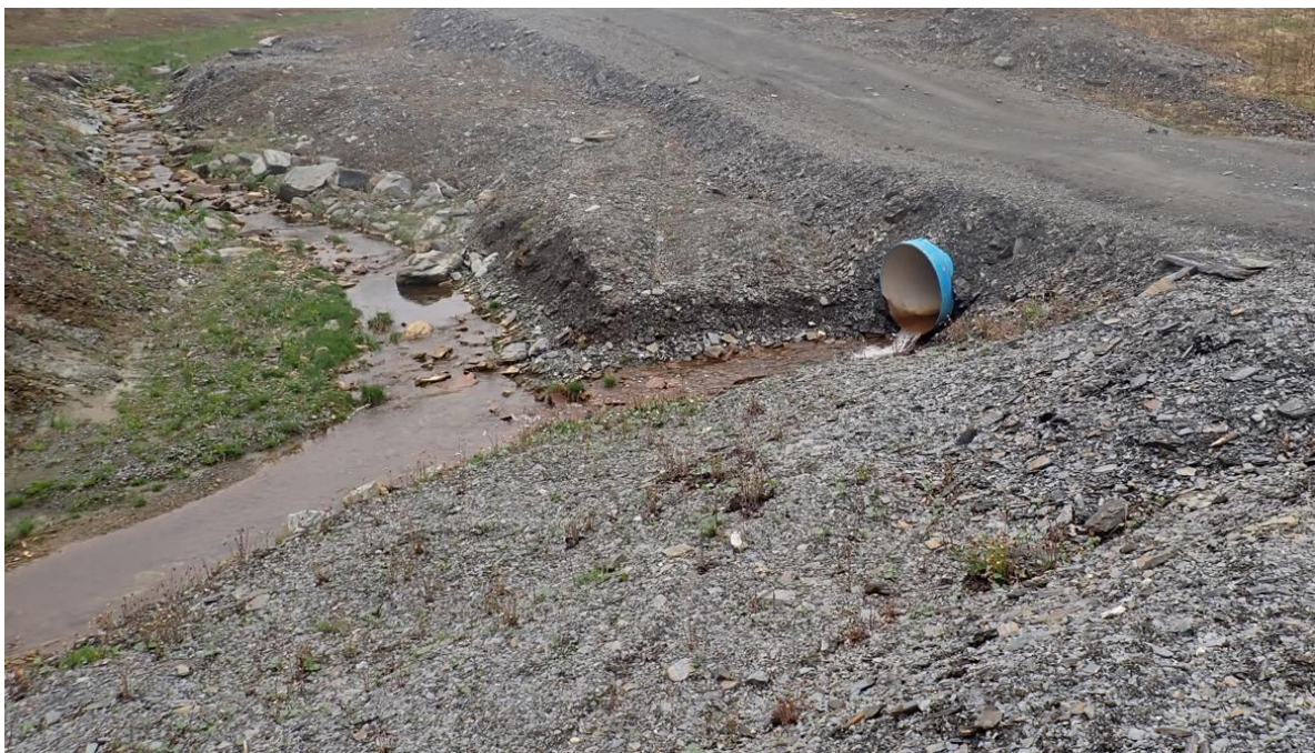
Figur 36. Sidegrein fra Sørborgen kommer inn i Osbekken til høyre i bildet, via en provisorisk kulvert under anleggsvei. Bunndyrstasjon 32 ble lokalisert ovenfor samløpet, mens bunndyrstasjon 33 ble lokalisert ovenfor kulverten i det øverste bildet. Foto: @NINA.
