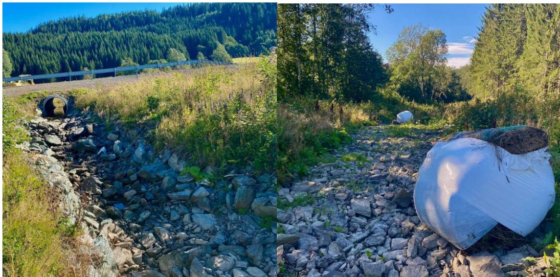
Figur 31. Til venstre: Det nylig steinsatte bekkeløpet i Storvollbekken like nedstrøms Sveanvegen. I perioder uten nedbør går bekkeløpet tørt, noe som er svært ugunstig for ørret fra Nidelva på gytevandring om høsten. Til høyre: Rundballer ligger strødd i det tørre bekkeløpet nedstrøms Sveanvegen. Foto: @Morten Andre Bergan.
