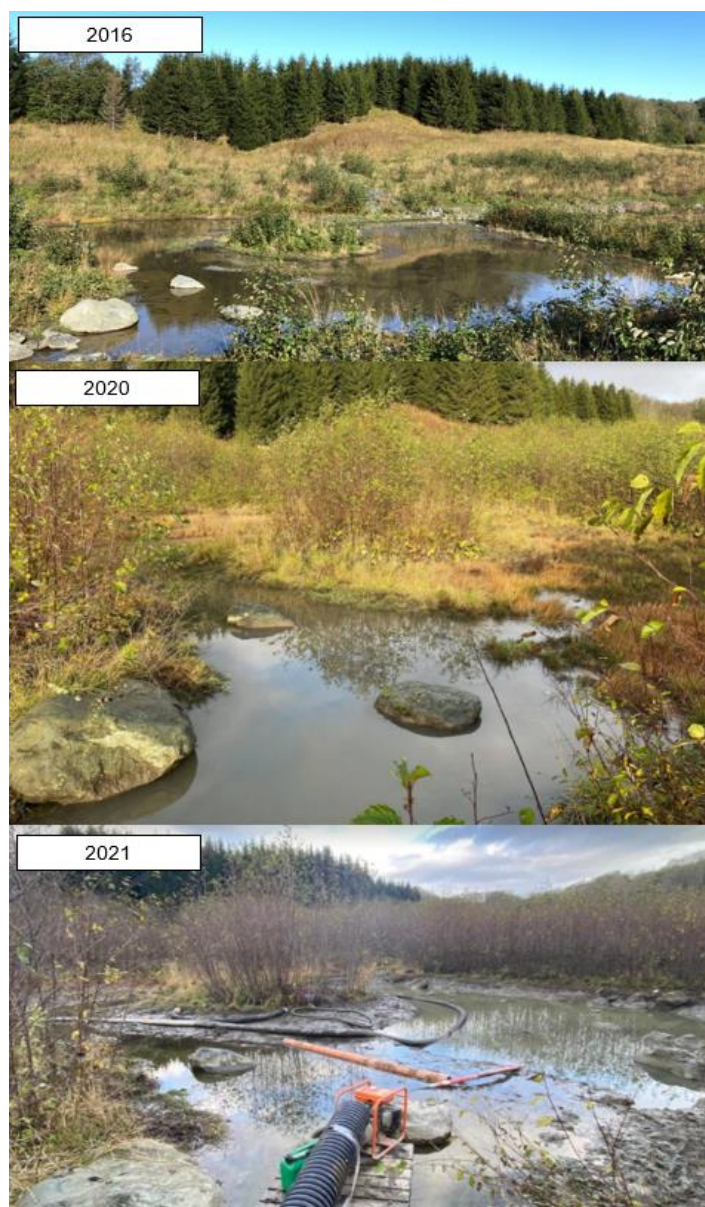
Figur 29. Utvikling i fangdam i Heggstadbekken fra høsten 2016 og fram mot status etter slam-suging høsten 2021. Foto fra samme sted, med retning oppover bekkeløpet. Foto: Morten Andre Bergan.
