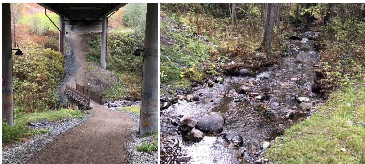
Figur 14. Kystadbekken og stasjonsområde under Kystadbrua. Foto: Morten Andre Bergan.
