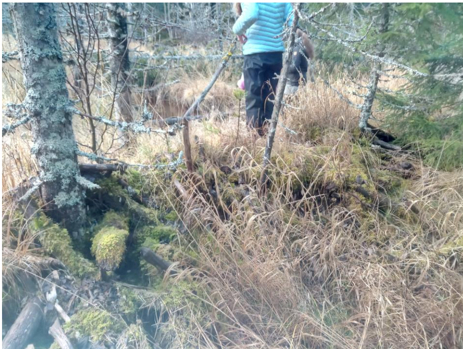
Figur 34. Rester av forlatt demningen, Skifersteinbekken. 12.11.2021.
