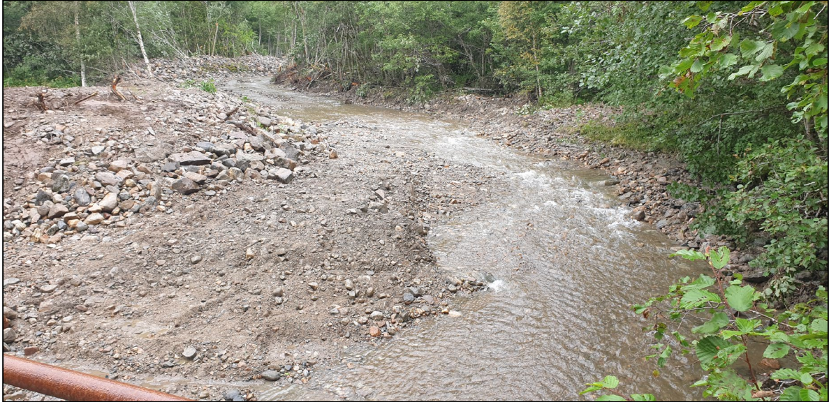
Figur 10. Bilde tatt oppstrøms fra bro langs Kvistdalsvegen. Store steinfragmenter er flyttet fra elvesenga og opp på bredden med det formål å hindre at elva tar et nytt løp i perioder med flom.
