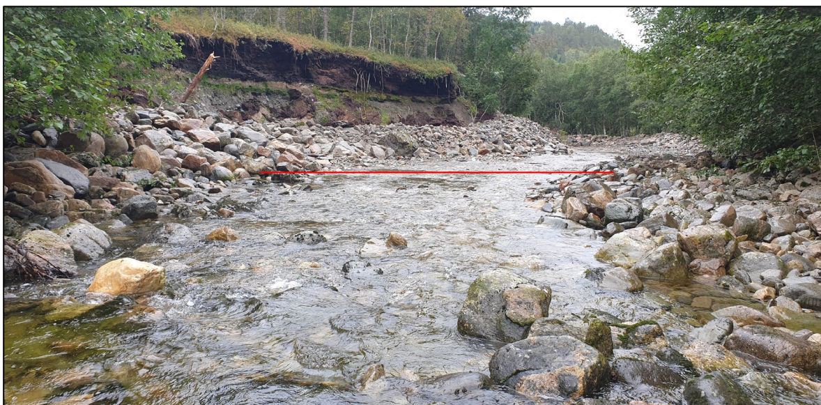
Figur 9. Bilde av Kvistdalselva tatt nedstrøms. Den røde linjen angir startpunktet for flomsikringsarbeidet. Tiltaket er avsluttet oppstrøms vegbro (Kvistdalsvegen) 200 meter lengre ned.
