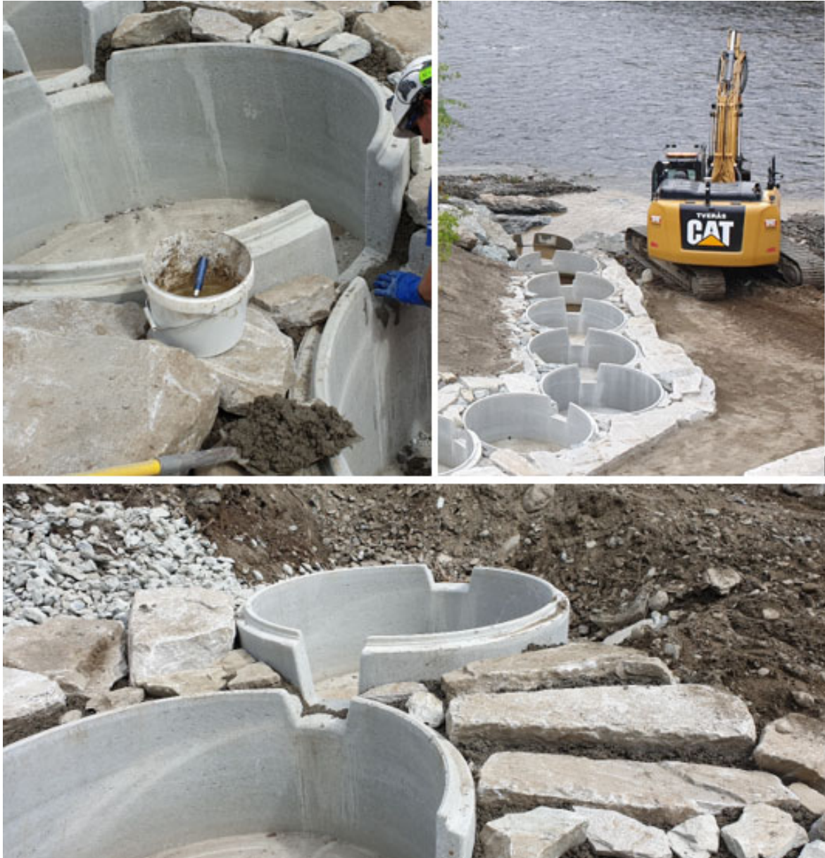
Figur 8. Arbeidet med ny fisketrapp i juni/juli 2019. Foto: Arne Jørgen Kjøsnes, NVE.
