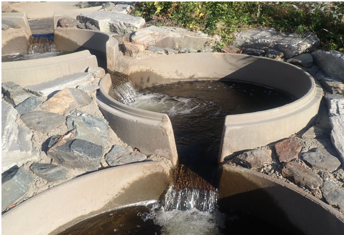
Figur 19. Fall i terskelceller i fisketrappa synes stort sett innenfor det akseptable for god fiskevandring. Foto: Morten Andre Bergan.
