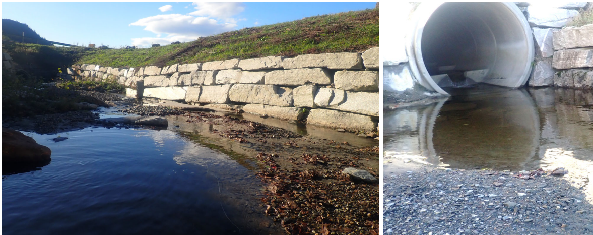
Figur 3. Florbekken mellom E14 og Melmyrvegen høsten 2021, og kulvert under Melmyrvegen (t.h.). Foto: @Morten André Bergan.
