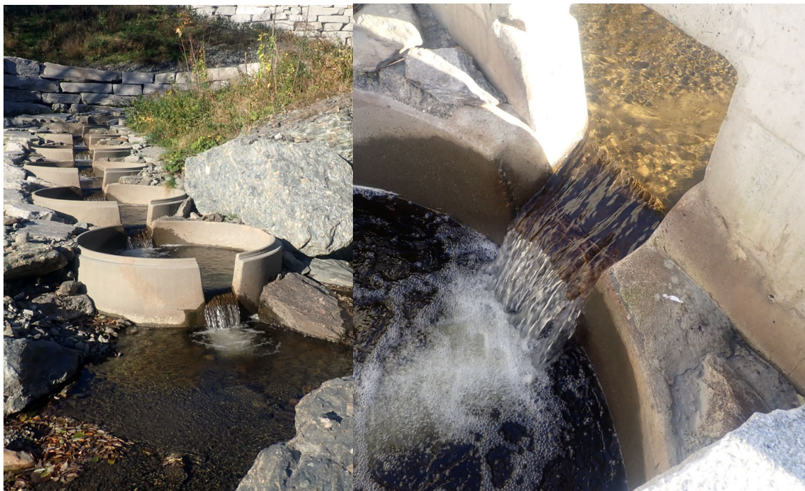
Figur 18. Nederste (t.v.) og øverste fall i terskelceller i fisketrappa har noe høyere fall enn øvrige terskler. Foto: Morten Andre Bergan.
