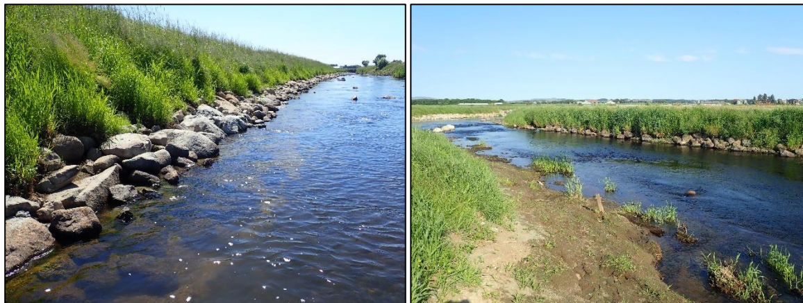
Figur 55. Det ble gjennomført et omfattende gravearbeid i Håelva i 2019 og 2020 med restaurering og gjennomføring av habitattiltak på hele strekningen fra Haugland til Kaffiholen (inkluderte stasjon 7 og 8 i overvåkingsprogrammet). Elvekanten skulle sikres og masse ble fjernet for å lage slakere elveskrånninger. Noen steder ble også den nederste delen av skrånningen steinsatt. Foto: Bjørn Mejdell Larsen.
