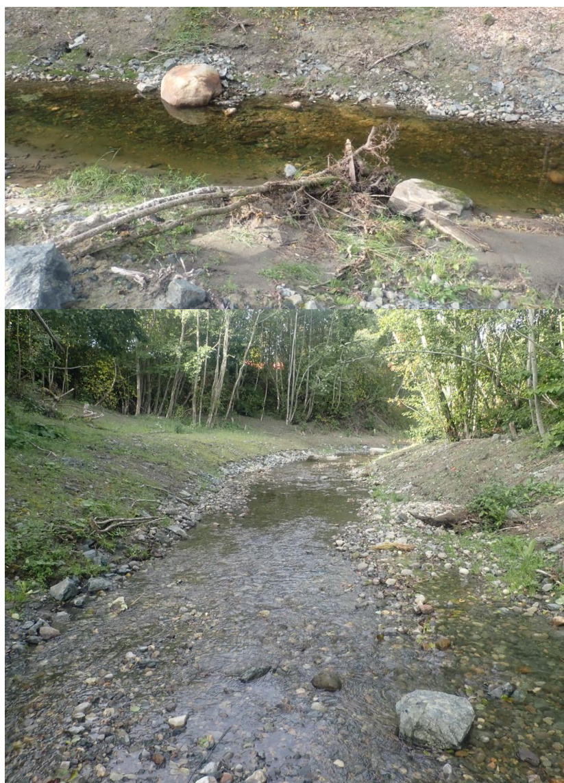
Figur 24. Status restaurerte bekkestrekninger i Langbekken høsten 2021. Foto: NINA.
