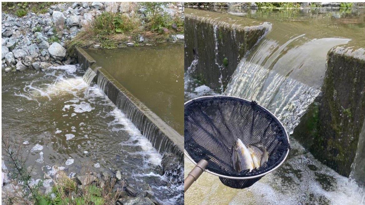
Figur 12. Nederste terskel er utformet ugunstig for fiskevandring, og oppvandrende ungfisk under 14 cm ser ikke ut til å passere dette punktet. Foto: NINA.
