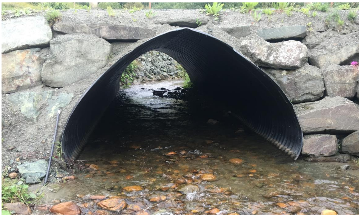
Figur 41. Den nye kulverten i Loa under Lebergsveien er et forbilledlig eksempel på en god løsning på krysning av vei over vassdrag. Foto: NINA.
