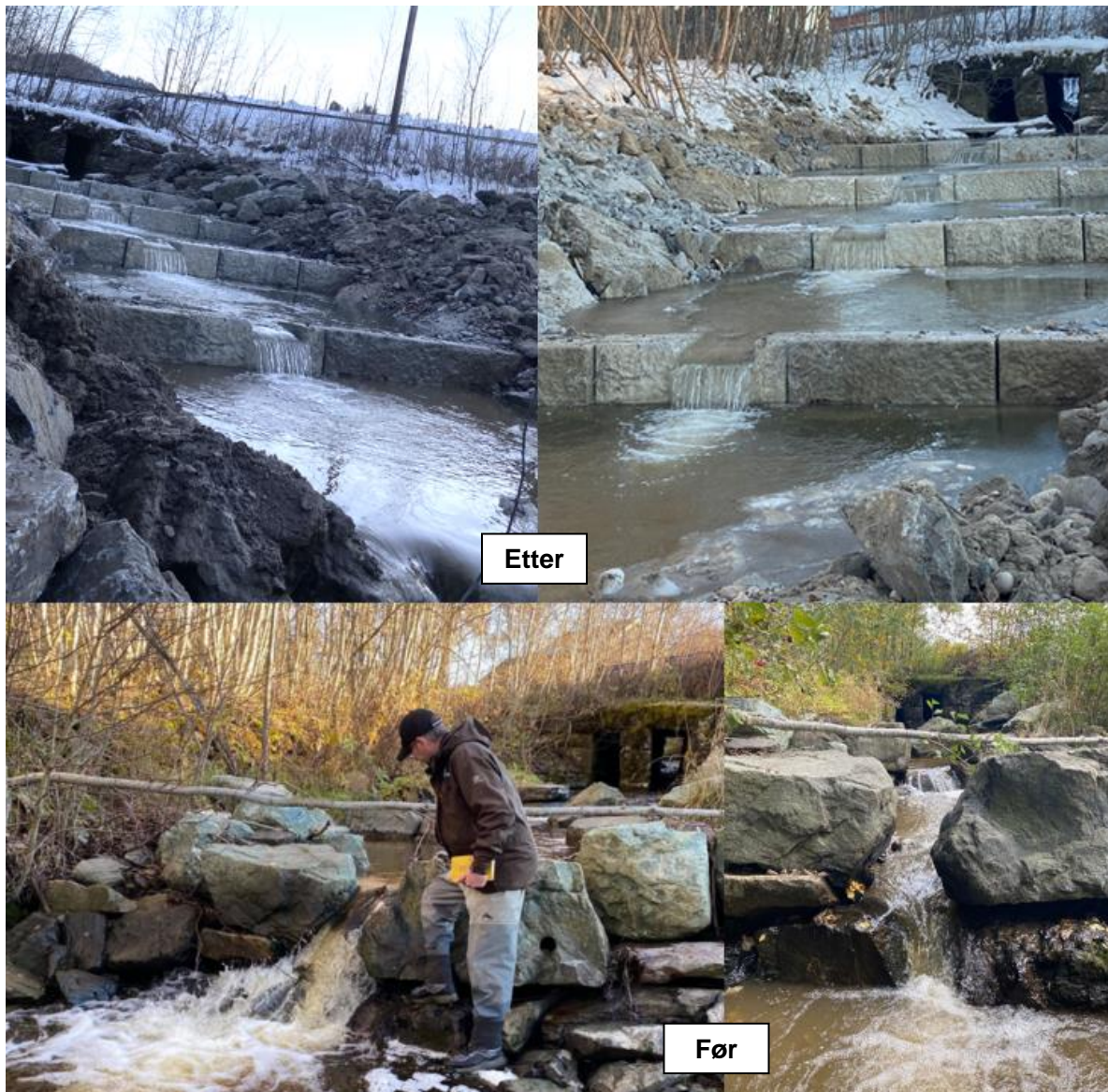
Figur 55. Terskler nedstrøms stikkrenne under jernbane i Lynga etter tiltak høsten 2021 (bilder øverst, tatt den 07.12.2021), sammenlignet med status i oktober 2020 (nederst t.v.) og september 2021 (nederst, t.h.). Foto øverst: Torstein Rognes, Gaula Fiskeforvaltning. Foto nederst: NINA
