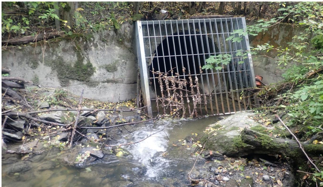
Figur 26. Overside av kulvert under E6, med rist som er fri for kvist, trevirke og annet. Foto: NINA
