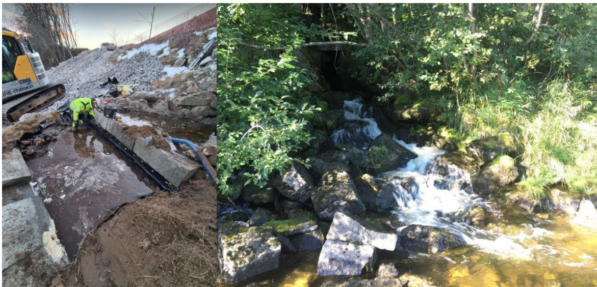
Figur 58. For å avbøte tidligere dårlige oppgangsforhold i den menneskeskapte forbygninga der Ørbekken munner ut i Gaula (t.h., foto fra 2015), ble det iverksatt utbedring av fiskepassasjen i munningsområdet høsten 2020 (t.v.). Foto t.v.: Torstein Rognes, Gaula Fiskeforvaltning. Foto t.h.: NINA.
