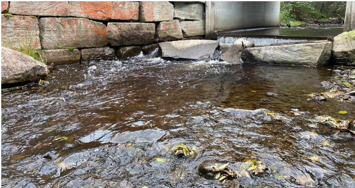
Figur 68. Det er mulig å terskle/bune opp bekkepartier nedstrøms, slik at spranget i kulverten utlignes, samtidig som at det med fordel kan monteres buner/terskler i selve kulverten. Foto: NINA.
