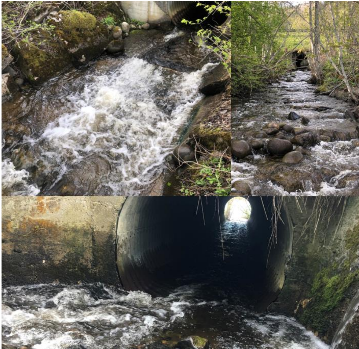
Figur 8. Veikrysning under Fv 707. Foto nedstrøms veien (øverst), og inngangen til kulverten oppstrøms veien (nederst). Foto: NINA.
