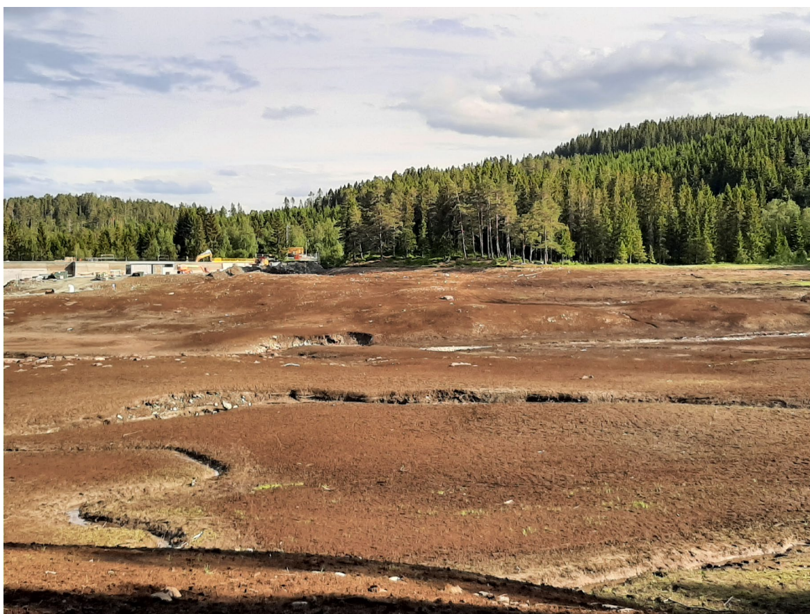
Figur 3. Oppgradering av denne dammen i Trondheim, med midlertidig senket vannstand illustrerer de potensielle visuelle effektene av damfjerning (Foto: Dagmar Hagen)
