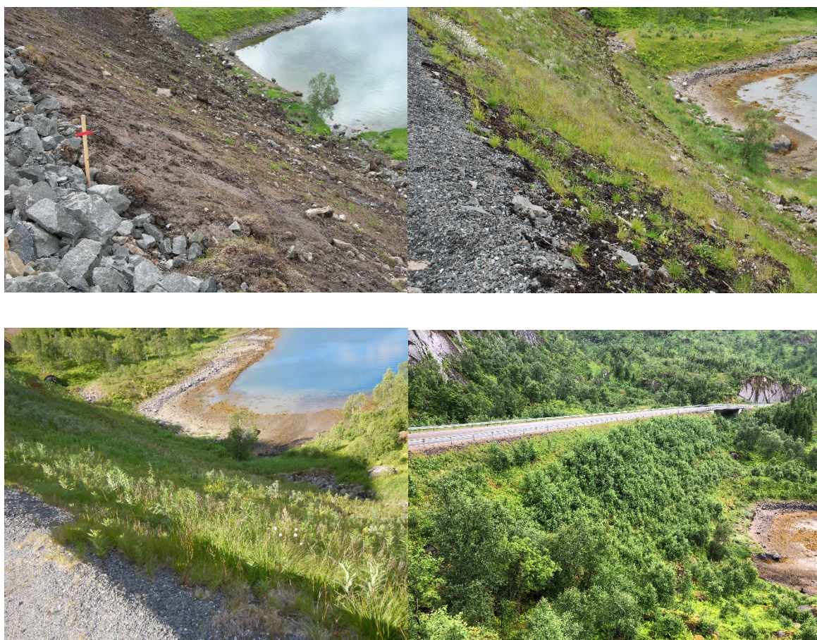
Figur 15. Revegeteringen med toppmasser direkte på bratt steinfylling. Foto: Astrid Brekke Skrindo (2006, 2008 og 2014), Marte Dalen Johansen (2021).
