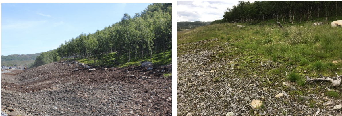
Figur 35. De humusholdige toppmassene (brun jordfarge) brukes nærmest inngrepsgrensen slik at størst mulig areal kan utvikle seg til samme naturtype som områdene rundt.
