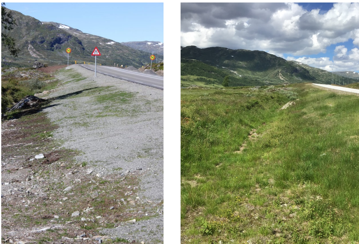
Figur 30. Lite toppmasser som er prioritert lengst unna vegen (år 2017). Fire år etter, er det vanskelig å se skillet, men artssammensetningen er ulik artene i omgivelsene omgivelsene. Toppmassene kommer fra den gamle vegens sideområde som trolig var sådd til med grasfrøblanding.
