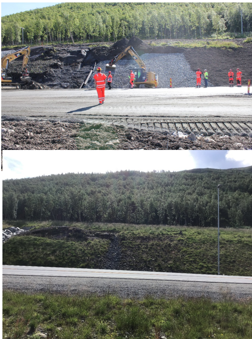
Figur 33. For å unngå erosjon, er det lagt et lag med stein under toppmassene.
