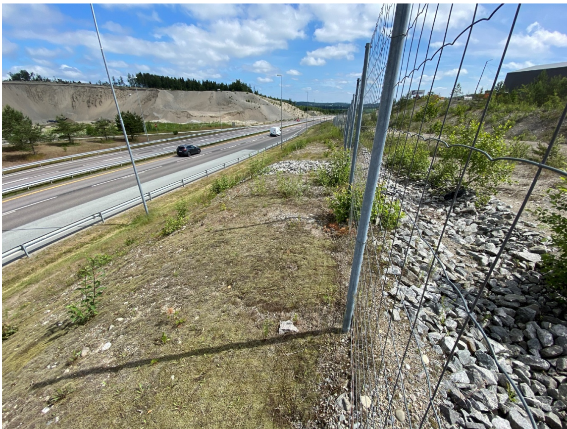
Figur 10. Vegkant dominert av moser oppå sandige masser. Foto: Astrid Brekke Skrindo.
