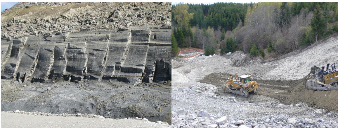
Figur 13. Bygging i leire og utlegging av toppmasser. Foto Astrid Brekke Skrindo.
