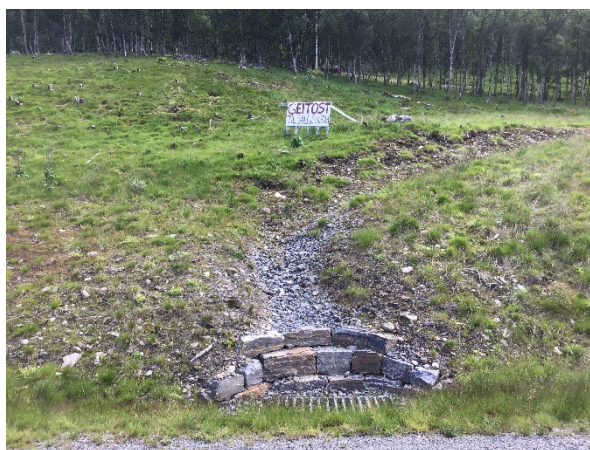
Figur 32. Ny vannvei for å unngå erosjon i sideterreng, 2017 og 2021.
