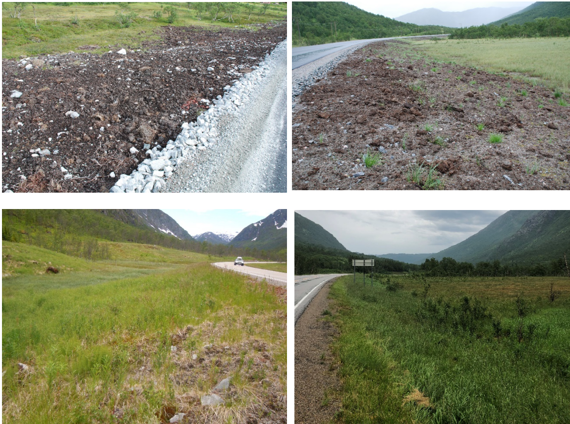
Figur 16. Myrmassene ble lagt ut på slake vegskuldre med jevn overgang til myrene på hver side av vegen (øverste bildene). Selv etter 15 år er inngrepsskillet tydelig med ulik vegetasjonssammensetting i myra og i vegkanten. Foto: Astrid Brekke Skringo (øverste bilder), Marte Dalen Johansen (nederste bilder).
