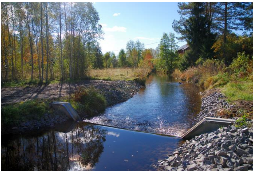
Bilde 3. Vandringsperra for å hindre oppstrøms spredning av signalkreps (se Johnsen mfl. 2008).
