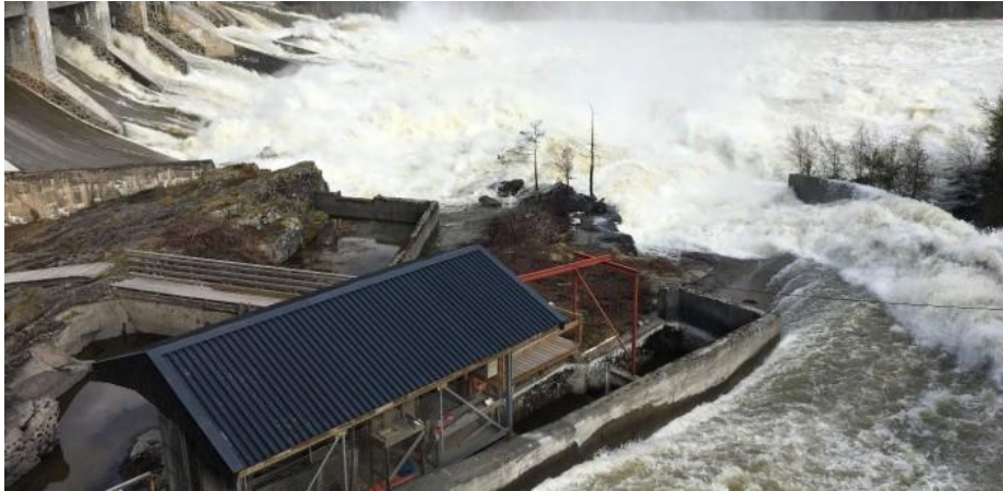
2000 kubikkmeter vann per sekund over Hunderfossen i 2018. Foto: KM Myrvold, NINA
