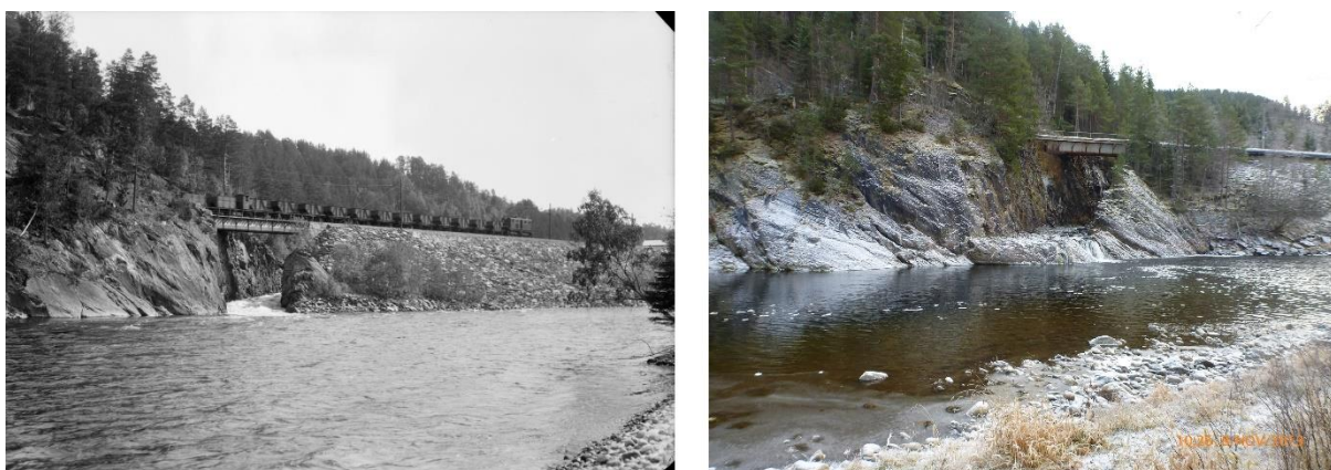
Figur 6.5. Svorkas utløp i Orkla ca 1940 (venstre, Foto: Karl August Berg/ Digitaltmuseum.no) og 2013 (høyre, Foto: Morten Bergan), viser tydelig senkning av elveløpet.
