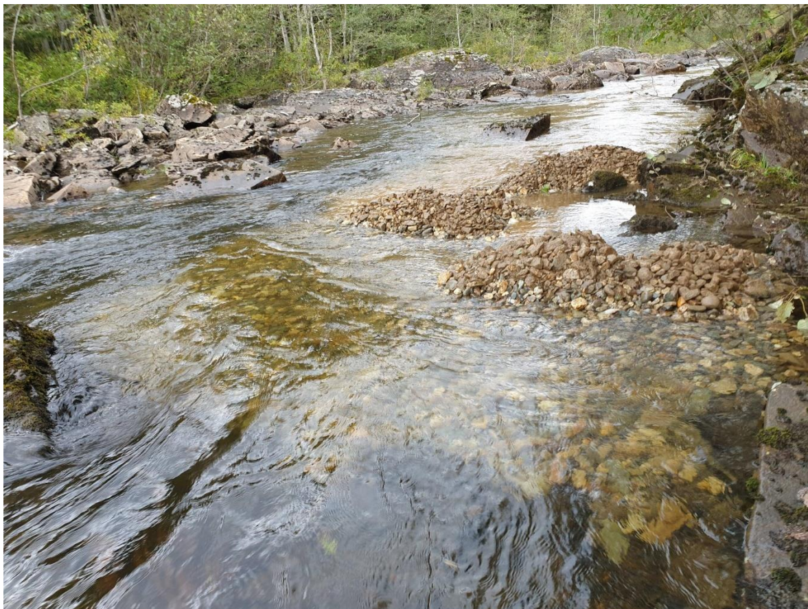
Bilde 8.2. Utlagt gytegrus i sideløpet ved Ingridøya. Når vannet stiger vil elva selv transportere grusen til egnede steder langs sideløpet. Foto: Espen Holthe, NINA.
