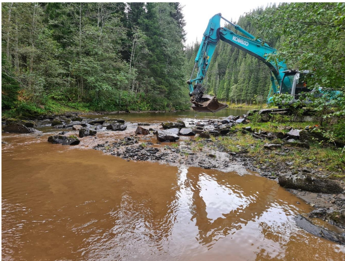
Bilde 8.1. Senking av terskelen ved innløpet til sideløpet ved Ingridøya. Foto: Harald Holm, Trønder Energi kraft AS.
