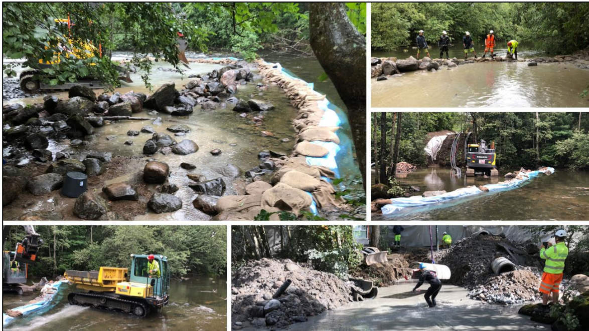
Figur 5. Kryssing av Akerselva med strømkabel var et utfordrende prosjekt som også inkluderte flytting av elvemusling og kreps. Foto: Hannu Stöckell, Veflen Entreprenør AS.
