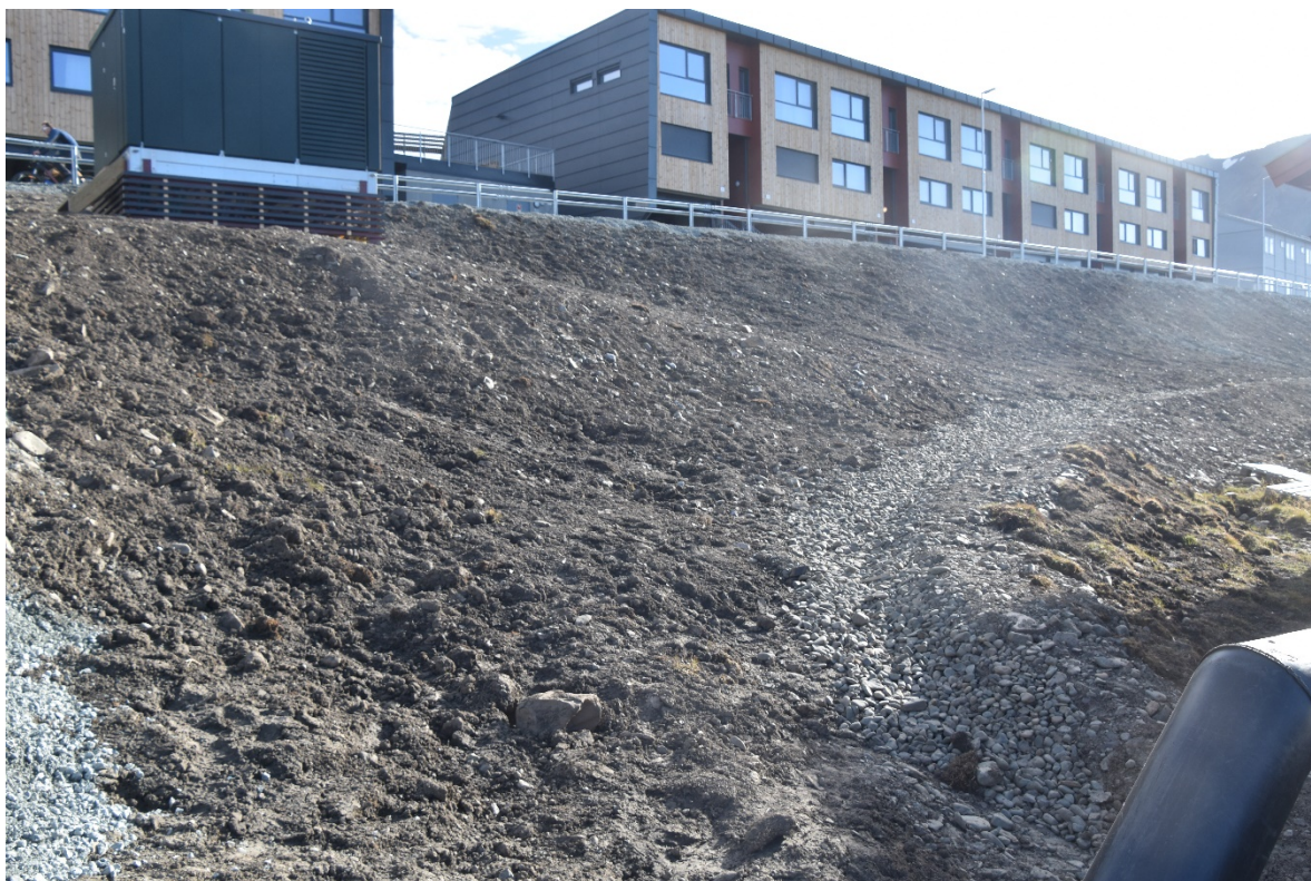
Figur 21. Ved utbygging i Gruvedalen ble det gravd ut store mengder organisk jord og vegetasjon. Neon av jordmassene ble lagt tilbake mellom husene for å bedre forhold for gjenvekst og gi bedre visuelt inntrykk.
