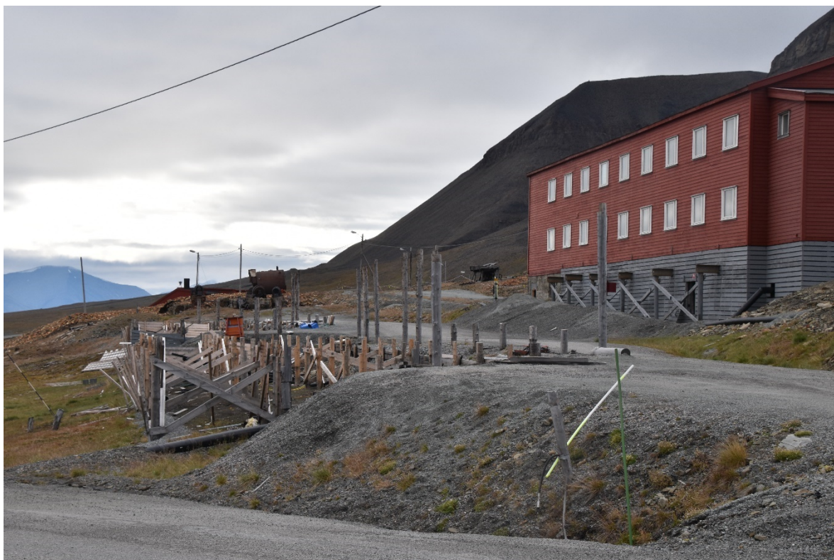
Figur 24. Når bygninger og infrastruktur i Svea skal fjernes skal det ikke oppstå nye inngrep i omkringliggende terreng. Dette krever felles forståelse og god dialog med alle som er involvert i planlegging og selve anleggsarbeidet. Da er «Grønt kurs» et nyttig verktøy.
