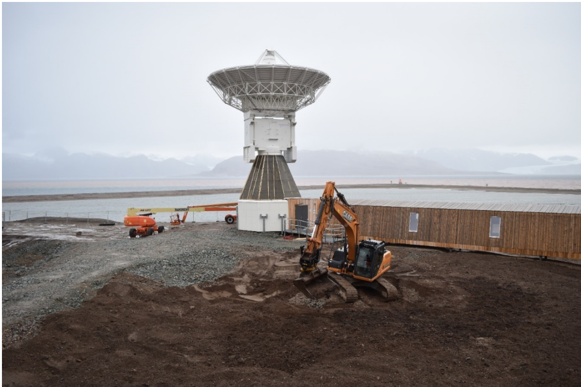
Figur 6. Etter at byggearbeidene var avsluttet ble jordmassene hentet fra mellomlager og lagt oppå inngrepsområdet nær bygningene. Foto: Dagmar Hagen/NINA.
