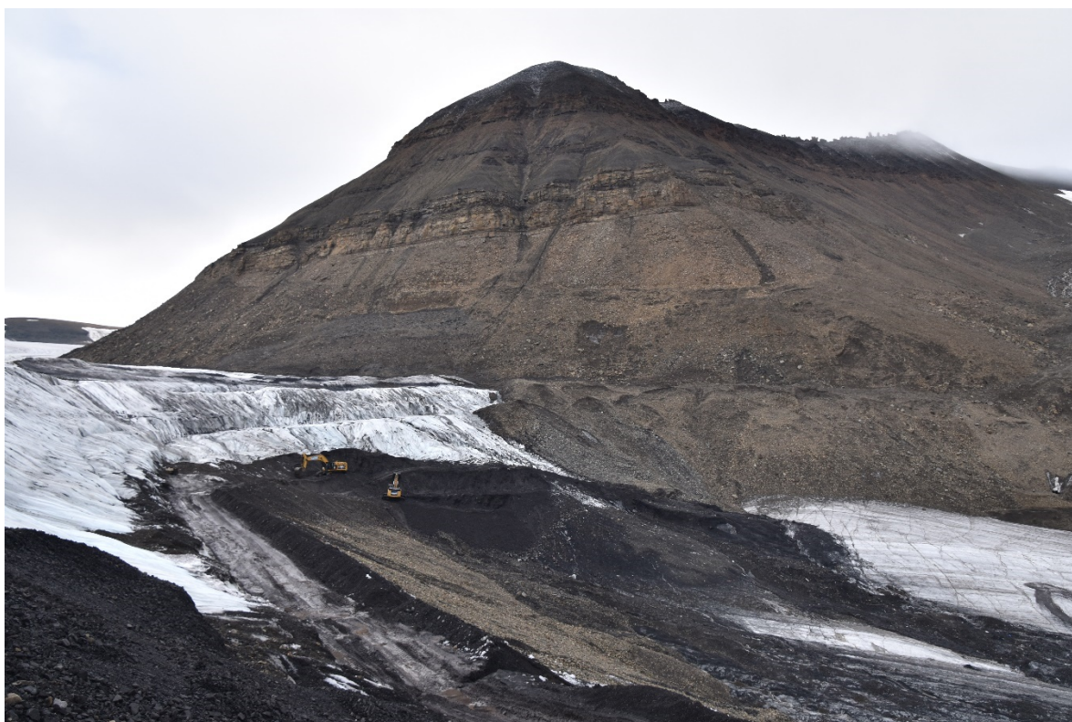
Figur 23. Fjerning av tilkjørte masser og tilrettelegging for naturlige prosesser er i tråd med prinsipper for naturrestaurering ved Svea Nord. Foto: Dagmar Hagen.
