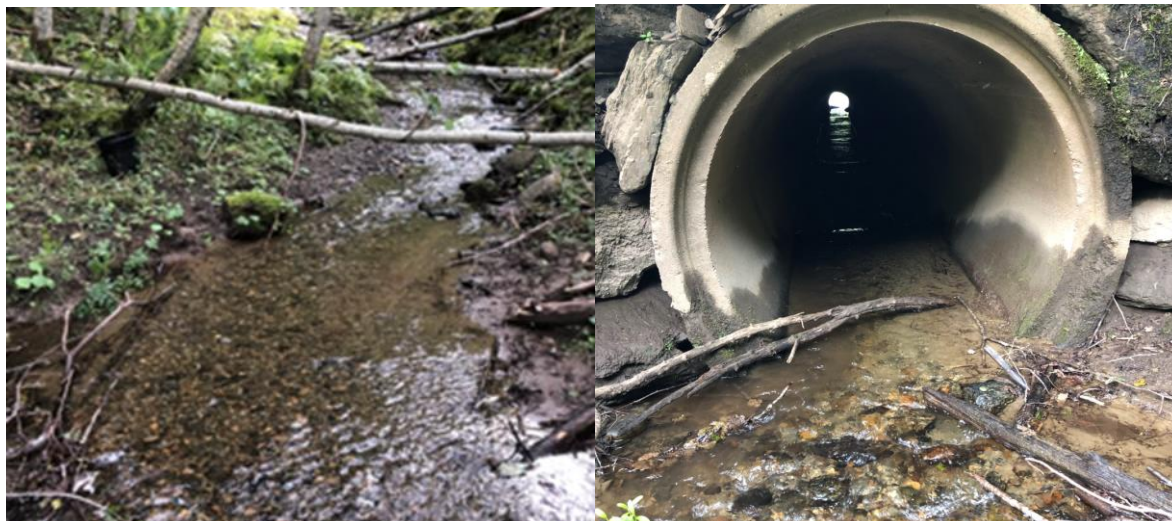
Figur 90. Kvennvassbekken på strekninger oppstrøms E6, med frie vandringsveier for fisk fra Gaula gjennom kulvert under E6. Foto: Morten André Bergan.
