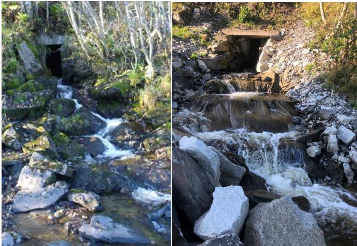
Figur 61. Forsøk på fiskepassasje i utløpsområdet til Ørbekken i Gaula. Bildene er fra før tiltak i 2014 (venstre bilde) og etter tiltak i 2019 (høyre bilde). Foto: Morten André Bergan.
