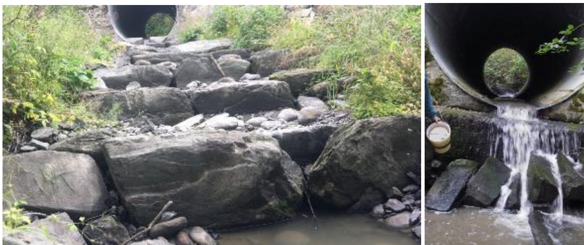
Figur 6. Etablering av terskler (bilde til venstre) i Stordalsbekken nedstrøms Fylkesvei 707, for å avbøte tidligere feil utforming av kulvert (bilde til høyre). Det bratte området nedstrøms tersklene er gjenauret og uten dypområder, slik at tiltaket i praksis fungerer som en fiskesperre tilsvarende før-status. Foto: Morten André Bergan (venstre bilde) og Hans Mack Berger (høyre bilde). Bildet til høyre er tatt i 2006, og er hentet fra Bergan mfl. (2008).
