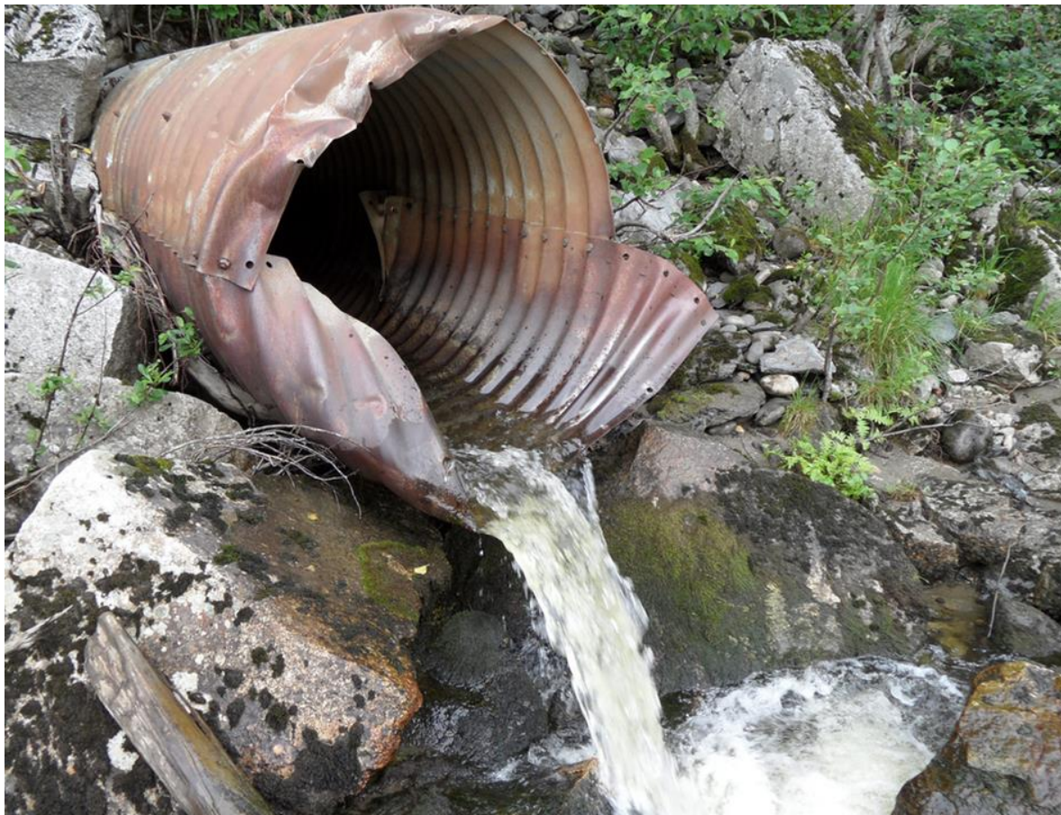
Figur 96. Spjeldbekken er i dag avstengt for sjøvandrende laksefisk som følge av bekkelukking. Bekkelukkingen er under dyrkamark og industriområde ved Støren, og bekken munner ut i Gaula gjennom kulvert i elveforbygninga. Foto: Vold Elveeierlag.
