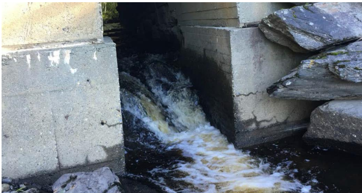
Figur 67. Stikkrenne under E6 i Gyllbekken. Da dette bildet ble tatt var vannstand og vannføring i Gaula (100-150 m 3 /s), det vil si på et nivå som gjør det mulig for sjørørret å vandre opp i bekken. Foto er hentet fra Bergan & Solem (2017).
