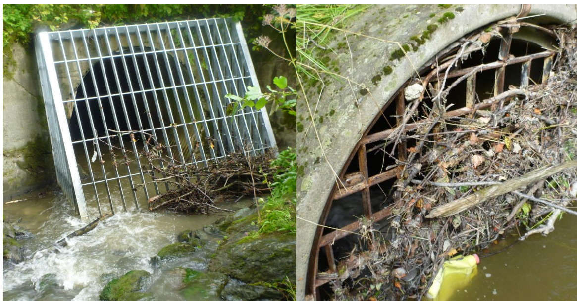
Figur 108. Rist foran kulverten under E6 (venstre bilde) og jernbane (høyre bilde) i Langbekken på Melhus. Foto: Morten André Bergan.
