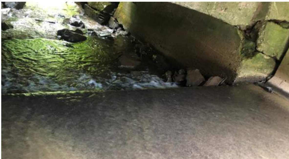
Figur 25. I 2019 ble det avdekket et nytt vandringshinder for fisk i Ratbekken. Under veien ved Stokkaunet er det etablert en betongbunn med fall. Foto: Morten André Bergan.
