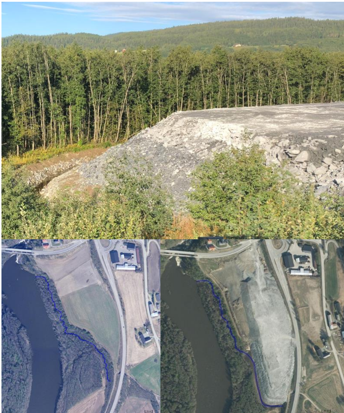
Figur 55. Et nylig etablert massedeponi (øverste bilde) har ødelagt store deler av anadrom strekning i bekken like oppstrøms Gaulfossen. En sammenligning av flyfoto fra 2018 (venstre bilde) og 2019 (høyre bilde) viser at massedeponiet har medført fjerning av kantvegetasjon og flytting av bekkeløpet (indikert med blå linjer). Foto: Morten André Bergan. Flyfoto: www.kart.finn.no .
