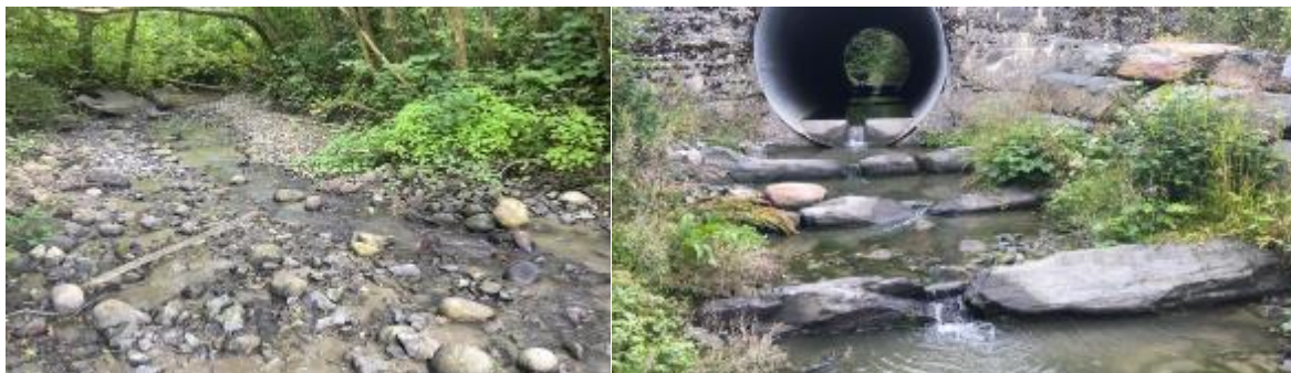
Figur 4. Stordalsbekken ved Leinstrand nedstrøms fylkesvei 707 (venstre bilde), og strekning med terskler og kulvert ved fylkesveien (høyre bilde). Strekningen nedstrøms inngrepsområdet har et naturlig bekkeløp, men bekkebunnen er nedslammet etter avrenning fra områder med landbruk og boliger. Foto: Morten André Bergan.
