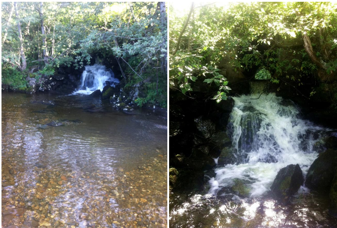
Figur 111. Hansbakkbekken før tiltak. Stengte vandringsveier i forbindelse med veikrysning under Riksvei 30. Foto fra 2011: Morten André Bergan.
