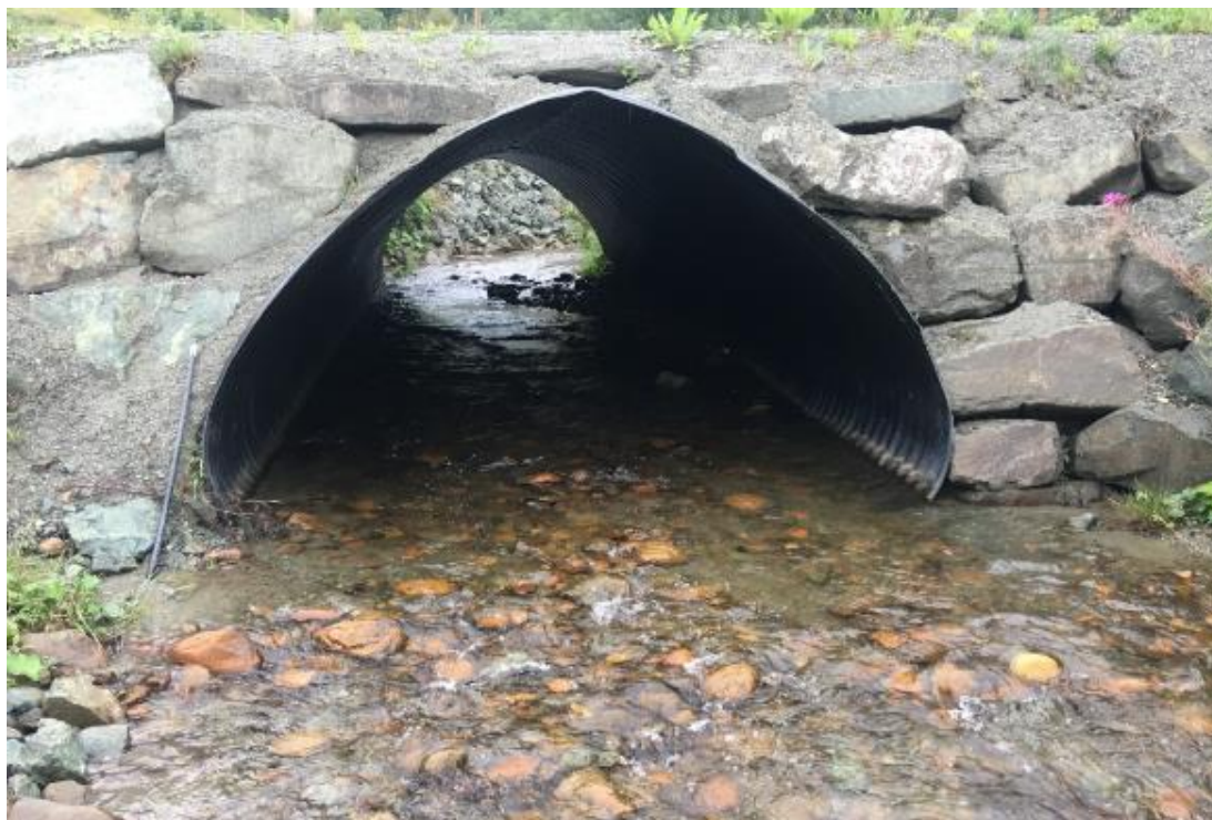
Figur 107. Den nye kulverten i Loa under Lebergsveien. Foto: Morten André Bergan.
