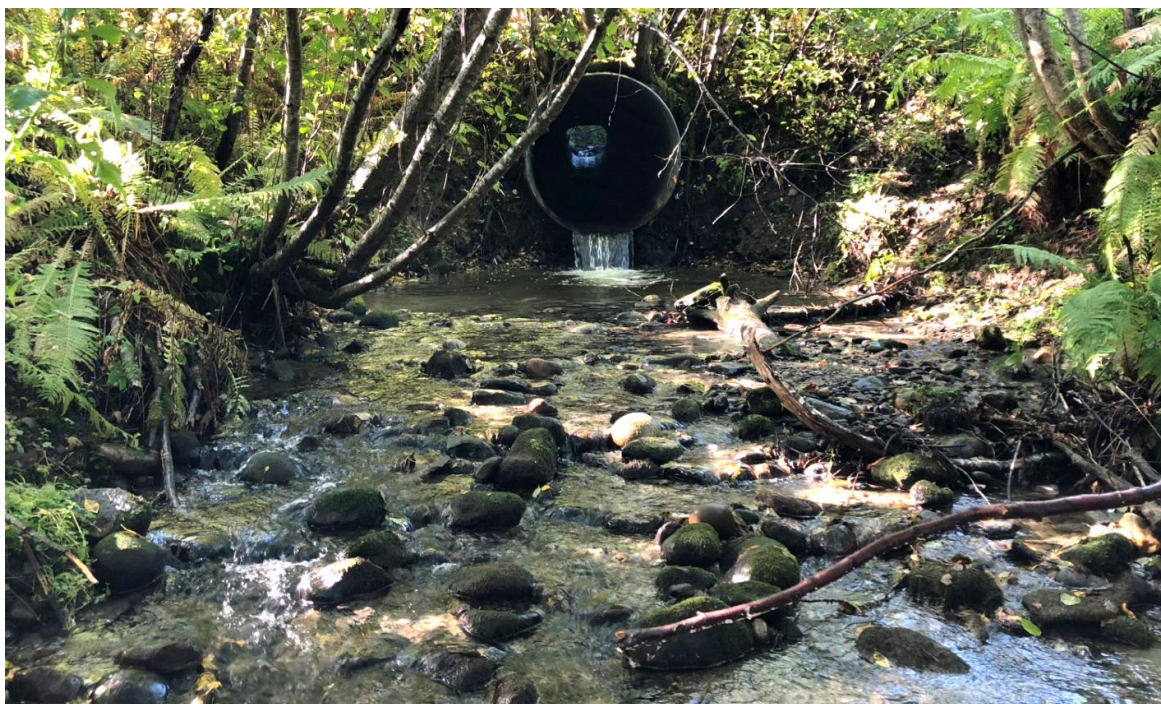
Figur 98. Vandringshindrende veikulvert under vei ved Spjelddalen. Foto: Morten André Bergan
