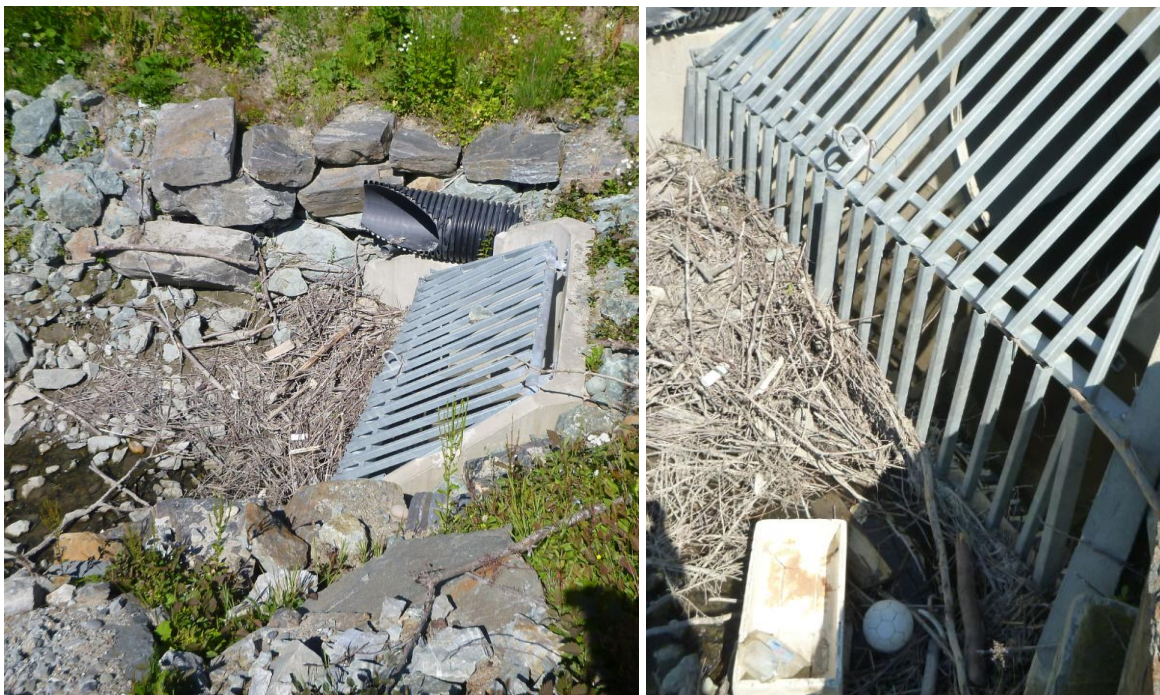
Figur 110. Rist foran kulverten under Strandvegen/Øyan, like før munning til Gaula. Foto fra 2014, før noen stenger i rista ble fjernet som et forsøk på avbøtende tiltak. Foto: Morten André Bergan.
