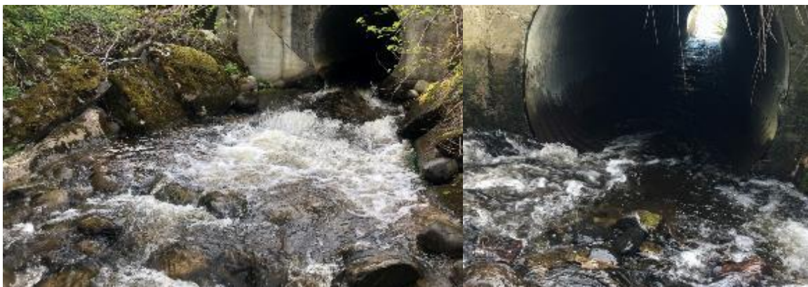
Figur 10. Til venstre: Nedstrøms vei. Til høyre: Oppstrøms vei (innløp til kulverten). Begge foto fra mai 2019, under vannføringsforhold som teoretisk kan føre gytefisk forbi veikulverten i dag. Foto: Morten André Bergan.
