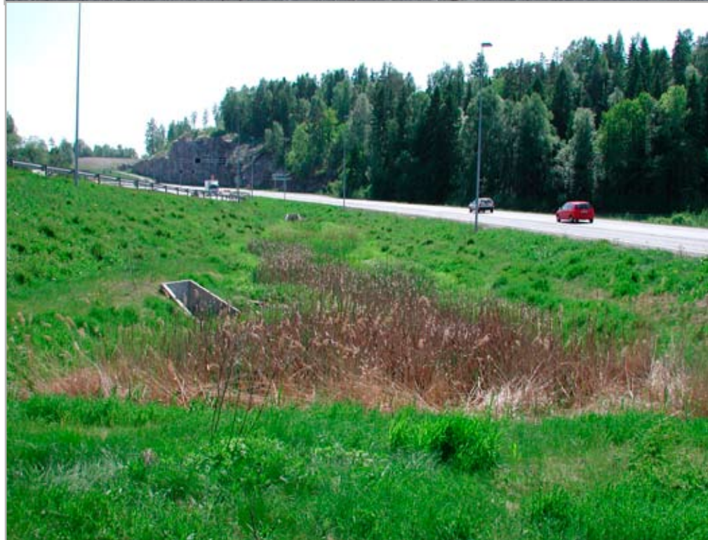
Figur 3.2. 1. Undersøkelsene har foregått i to rensedammer langs ny E6 i Akershus, en dyp dam uten vegetasjon i Ski og en grunn dam med våtmarksvegetasjon i Ås. Foto: R. Roseth.
