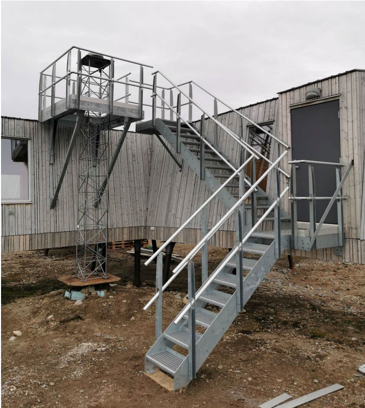
Figur 3.2. Ny dør og trapp ved krysset av gangbanene. Foto: M. Øien/ Hæhre.
