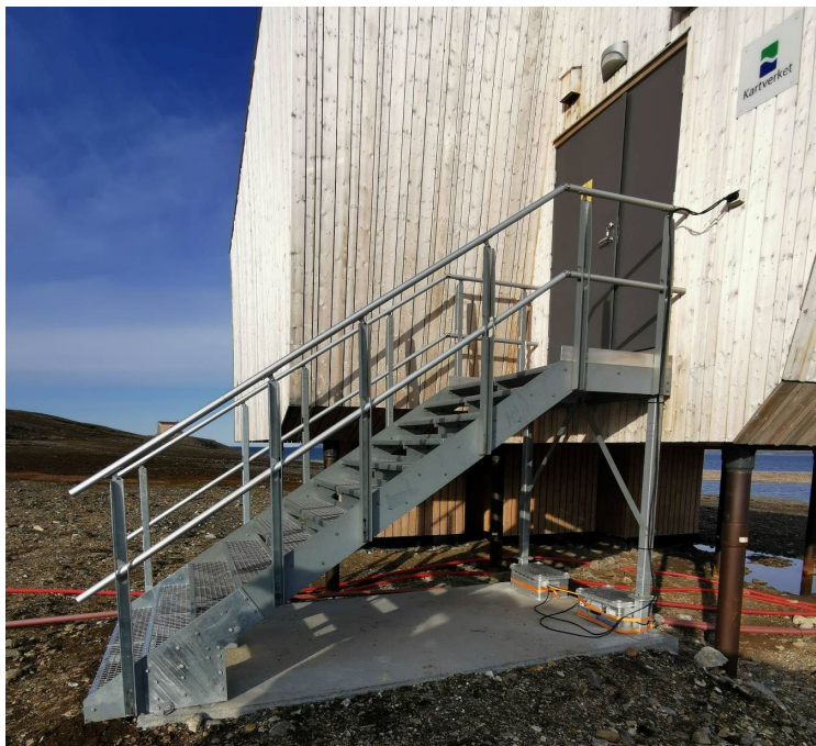
Figur 3.1. Utbedret trapp til gravimeterbygget. Foto: M. Øien/Hæhre.
