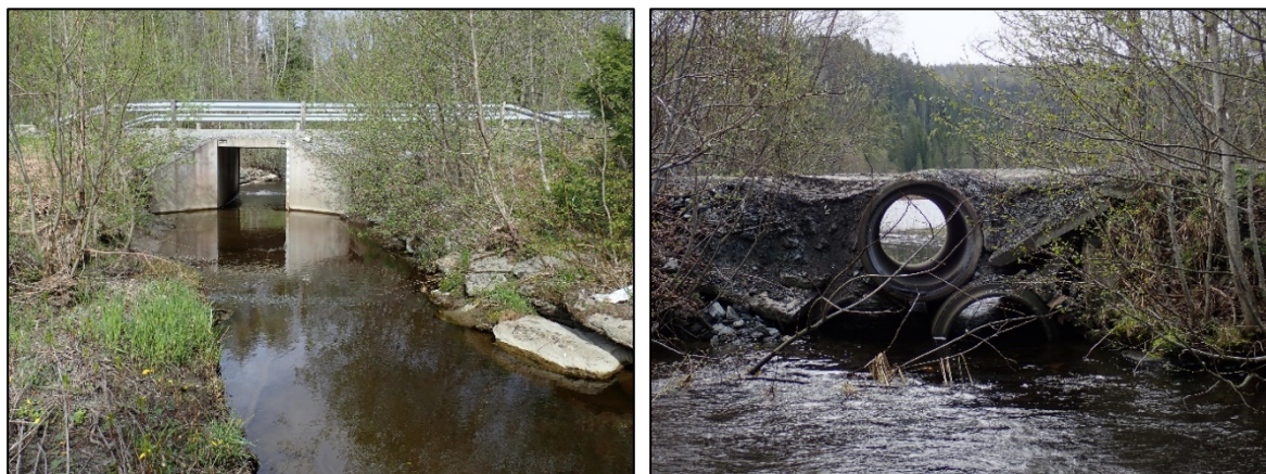
Figur 14. Vegkryssinger over offentlig og privat vei i Sagelva. Hasetvegen krysser Sagelva i en betongbro nedenfor deponiet på Skjenstad. Hønstadvegen krysser utløpselva fra Langvatnet i en fylling med tre betongrør som sikrer vanngjennomstrømningen. Foto: Bjørn Mejdell Larsen.
