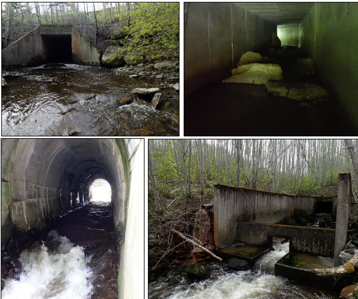
Figur 13. Kulverter og passasjer som ørretet må passere på opp- eller nedvandring i Sagelva under jernbanen (bildene øverst), under Rv 705 (til venstre nede) og under nåværende E6 (til høyre nede). Foto: Bjørn Mejdell Larsen.
