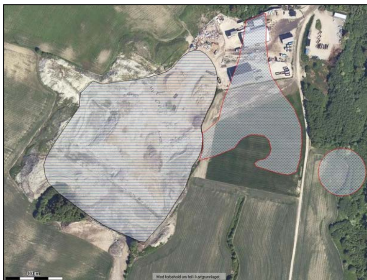
Figur 6. Plassering og avgrensning av deponiet på Skjenstad. Blå skravur viser avgrensning av dette deponiet (inklusive planlagt avslutning). Stiplet skravur viser antatt plassering av tidligere kommunale deponier. Fra Asplan Viak (2009).
