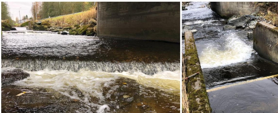
Figur 8. Nedre del av Leirelva ved avkjøringsrampe fra E6. To vandringshindre for laks og sjøørret med kort mellomrom; kulvert under avkjøringsrampe (t.v.) og eldre vannmålerstasjon (t.h.). Foto: Morten Andre Bergan.
