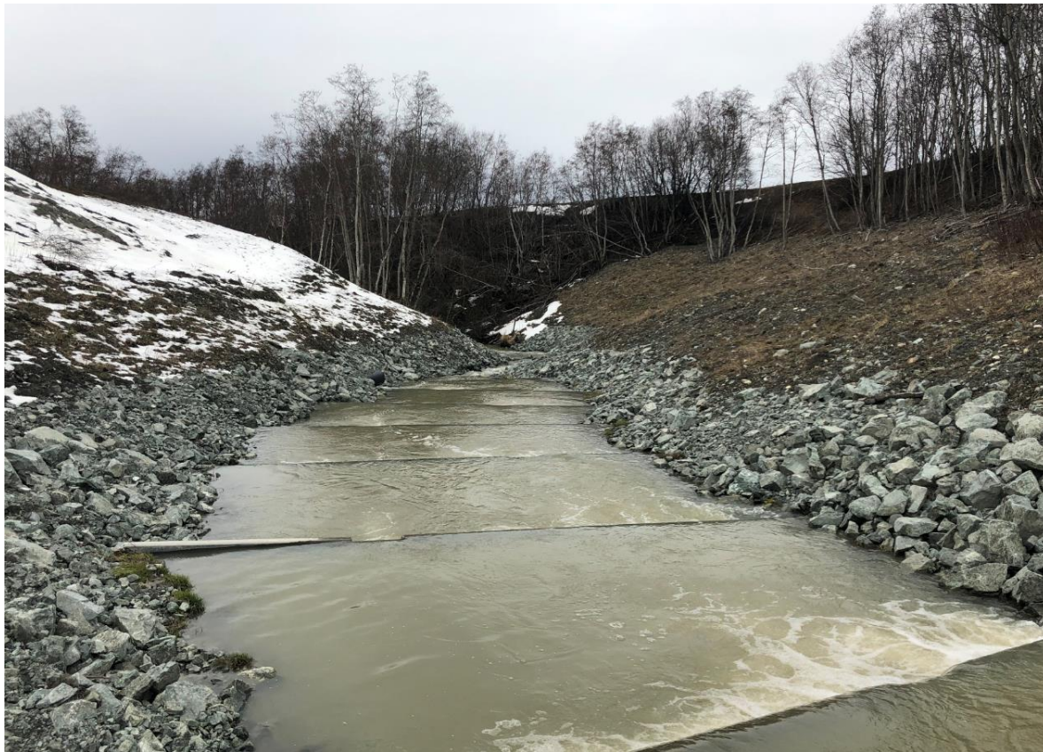
Figur 31. Nedre restaurert strekning av Sørå, med fisketrapp- lignende terskler for å sikre oppvandring og reetablering av sjørret fra Gaula på sikt. Foto: Morten Andre Bergan, NINA.
