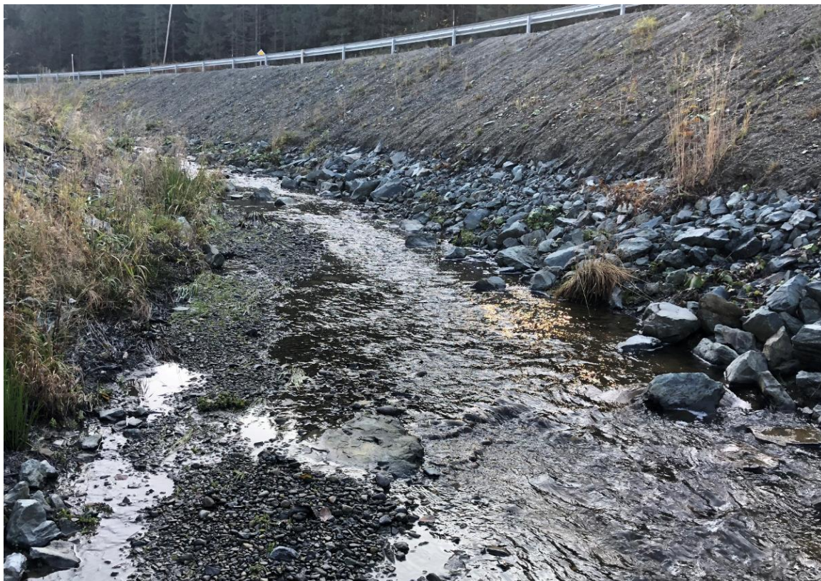
Figur 15. Nedre del av Solemsbekken (st. 32) høsten 2019. Foto: Morten Andre Bergan.
