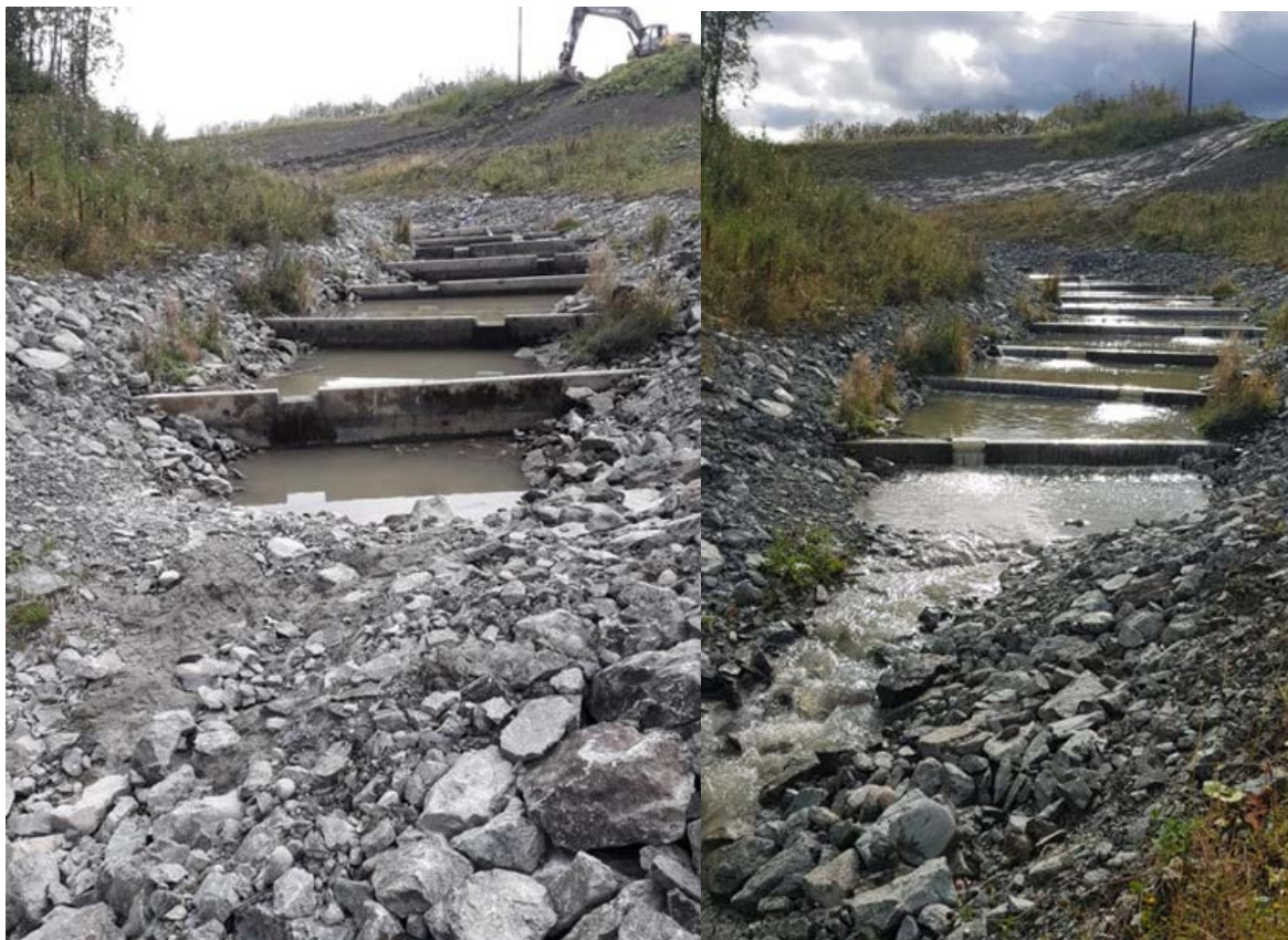
Figur 8. Foto fra terskelpartiet den 20.08.2019 (til venstre), der kun tersklene hadde vannspeil. Samme parti 21.08.2019 (til høyre), etter at feilen var utbedret og vannføringen igjen på plass. Foto til venstre: Morten Sæther/Privat. Foto til høyre: Terje Nøst/Trondheim kommune.
