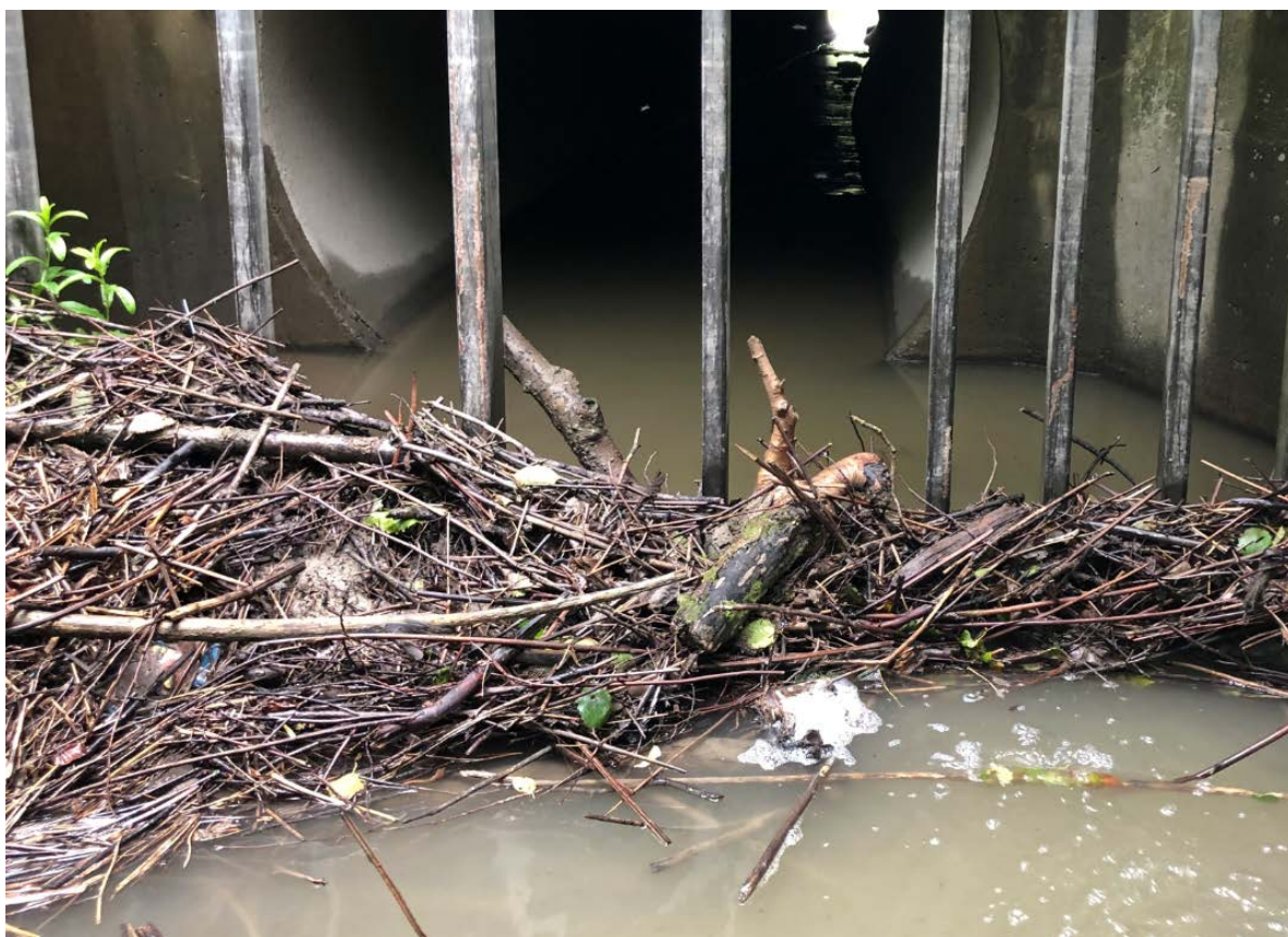
Figur 20. Rister foran veikulverten har nylig fått fjernet vertikale spiler, men går fortsatt svært fort tett, med fare for å danne oppgangshinder for ungfisk og gytefisk fra Gaula. Foto: NINA.
