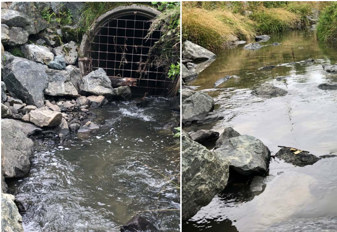
Figur 17. Rister foran jernbanekulvert, og bekkepartier ovenfor er steinsatt med grov skutt/sprengstein og blokk. Rista må fjernes, og partiene må få tilført naturlig elvestein og gytesubstrat. Foto: NINA.
