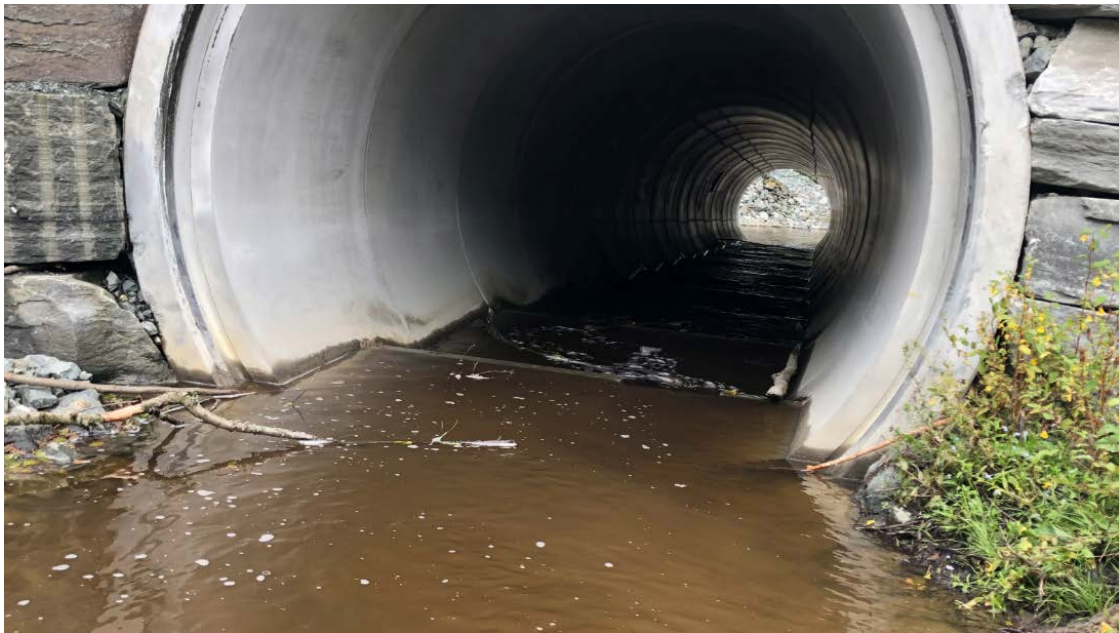
Figur 12. Veikulvert med innlagte terskler som fungerer som fisketrapp i Ratbekken. Foto: NINA.
