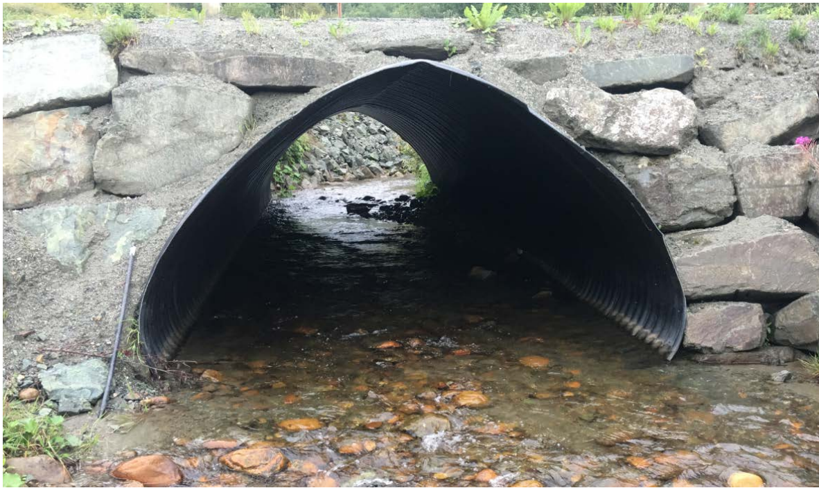
Figur 32. Den nye kulverten i Loa under Lebergsveien er et forbilledlig eksempel på en god løsning på krysning av vei over vassdrag. Foto: NINA.
