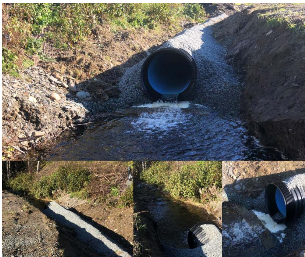
Figur 53. Nylagt kulvert og lukking av bekken nedstrøms Fossvegen. Foto: NINA.
