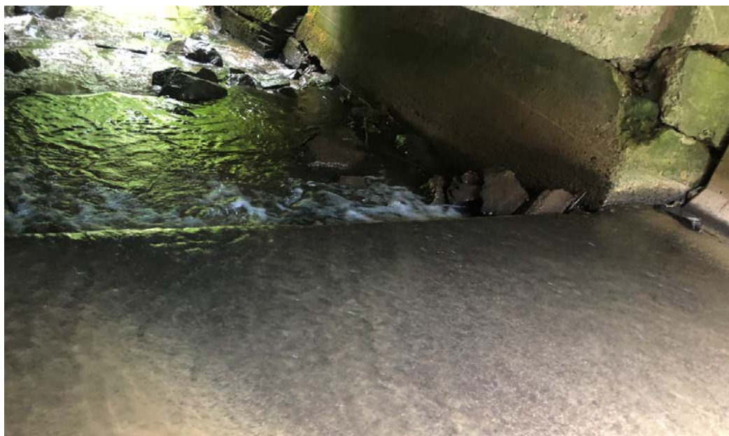
Figur 13. Ukurant, flat betongbunn med nedstrøms fall under privat vei ved Aasgarden. Foto: NINA.
