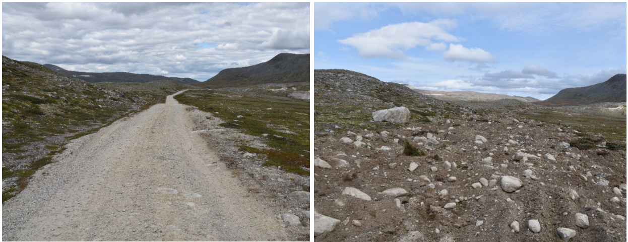
Figur 3.20. Eksempel på restaurert veg i Hjerkinnskytefelt i grovt substrat og omtrent samme høyde over havet som Tverrfjellet.
