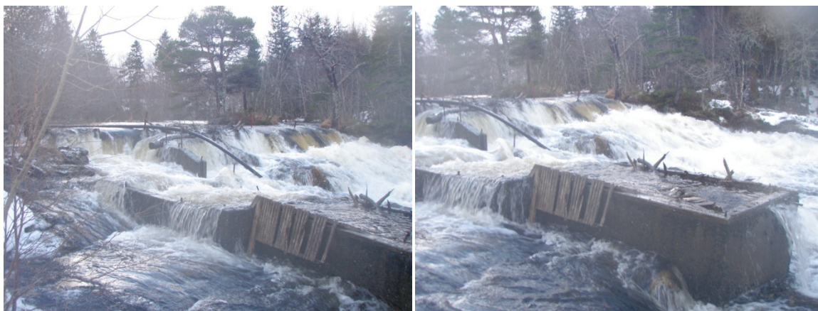
Rester av ålefelle (wolf-felle) bygd av Direktoratet for naturforvaltning (DN) på 1980-tallet i Oldenelva i Bjugn i Sør-Trøndelag. Bildene er tatt under en stor flom i januar 2011. Foto Nils Arne Hvidsten.
