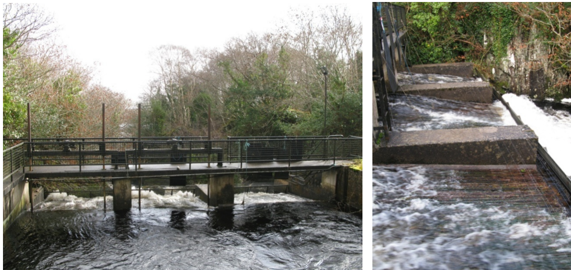
Wolf-felle i Burrishoole i Irland, hvor utvandrende ål fanges på samme måte som i Imsa i Rogaland. Det finnes bare et fåtall slike totalfeller som fanger ål i europeiske vassdrag. Foto: Eva B. Thorstad.
