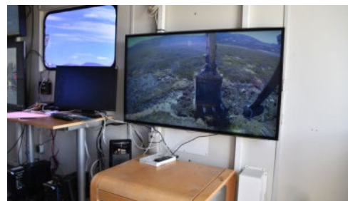
En del av arbeidet foregår med fjernstyrt maskin. Da sitter maskinføreren 1000 meter unna maskina og styrer via en skjerm. (Foto: Dagmar Hagen)
