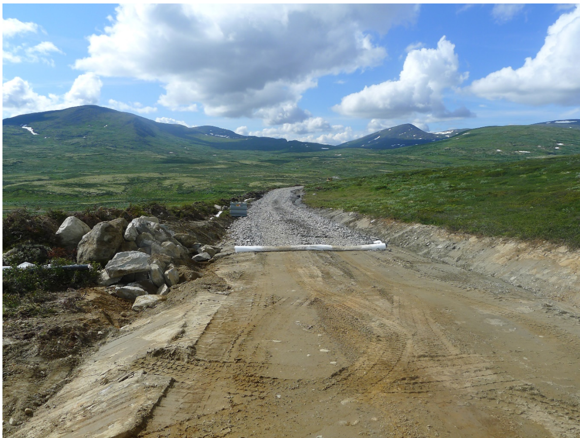
Figur 1.1. Etablering av midlertidig anleggsveg med nedsenka og permanent bærelag langs det tidligere kjørsporet inn til Dam Elgsjø. Foto 15.08.2012.
