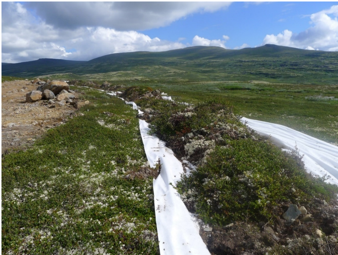
Figur 2.2. Mellomlagring av vegetasjon og toppmasser på duk i anleggsfasen.
