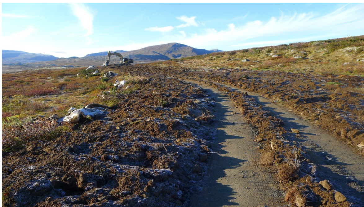
Figur 2.3. Mellomlagrede jordmasser og vegetasjon ble lagt oppå bærelaget som avslutning på anleggsfasen i 2013.
