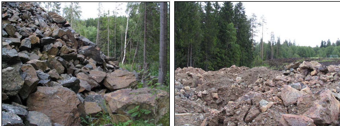
Figur 17. Deponier av fyllmasse og sprengstein er anlagt delvis innenfor 50-meters beltet langs Hunnselva. Dette kan gi uheldig avrenning bl.a. av nitrat mot elva.
