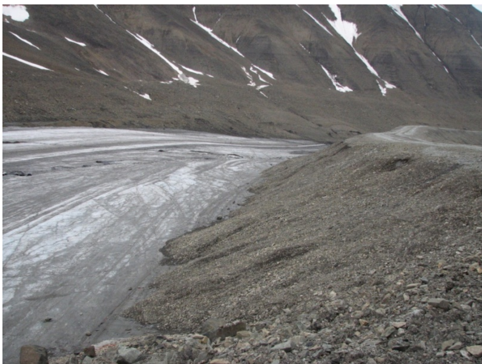
Figur 5.4. Veien ned Höganäsbreen. Her ses effekten av veimassens isolasjon tydelig. Veien ble bygd med lav høyde over datidens breoverflate, men rager nå med beytdelig høyde over breoverflaten. Denne veien kan imidlertid ikke brukes som en direkte parallell fordi den ligger lavere i områder med høyere avsmelting og fordi den går opp langs breen, ikke på tvers som den planlagte veien på Marthabreen.
