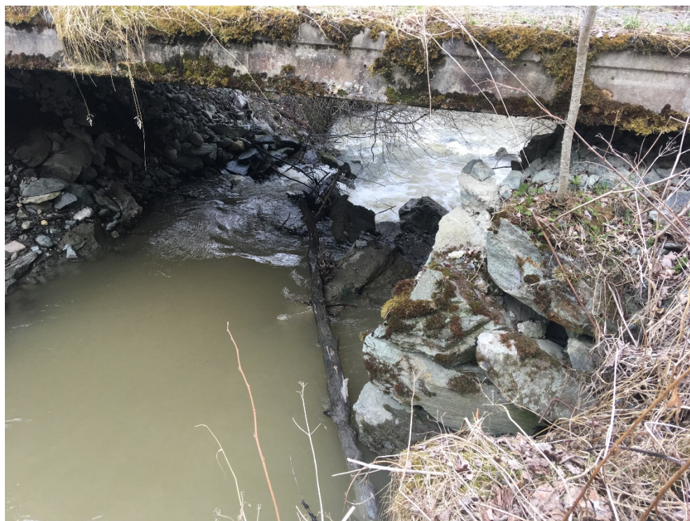
Figur 14. Betongklosser, stein og lignende dumpet i Eggbekken ved landbruksveikrysning forverrer allerede vanskelige oppgangsførhold. Foto fra april 2018. Foto: Morten Andre Bergan.
