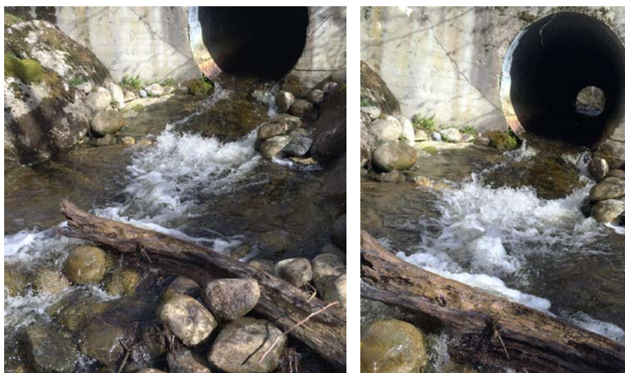
Figur 10. Veikrysning i kulvert under Fv 707 Leinstrandveien i 2015, etter at NINA la ut storstein og trevirke for å forøke å avbøte på vanskelige oppgangsmuligheter for sjørøret. Foto: Morten Andre Bergan.
