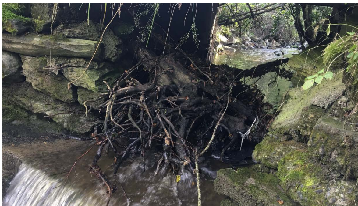
Figur 22. En større rot og trevirke har kilt seg i kulvertutløpet under veien etter flom, og sperrer når for oppgang av sjørørret. Foto: Morten Andre Bergan.
