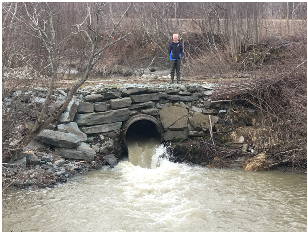
Figur 13. Landbruksvei stopper for alle oppgang av sjørrret til gyteområder i Eggbekken. Foto fra april 2018. Foto: Morten Andre Bergan.
