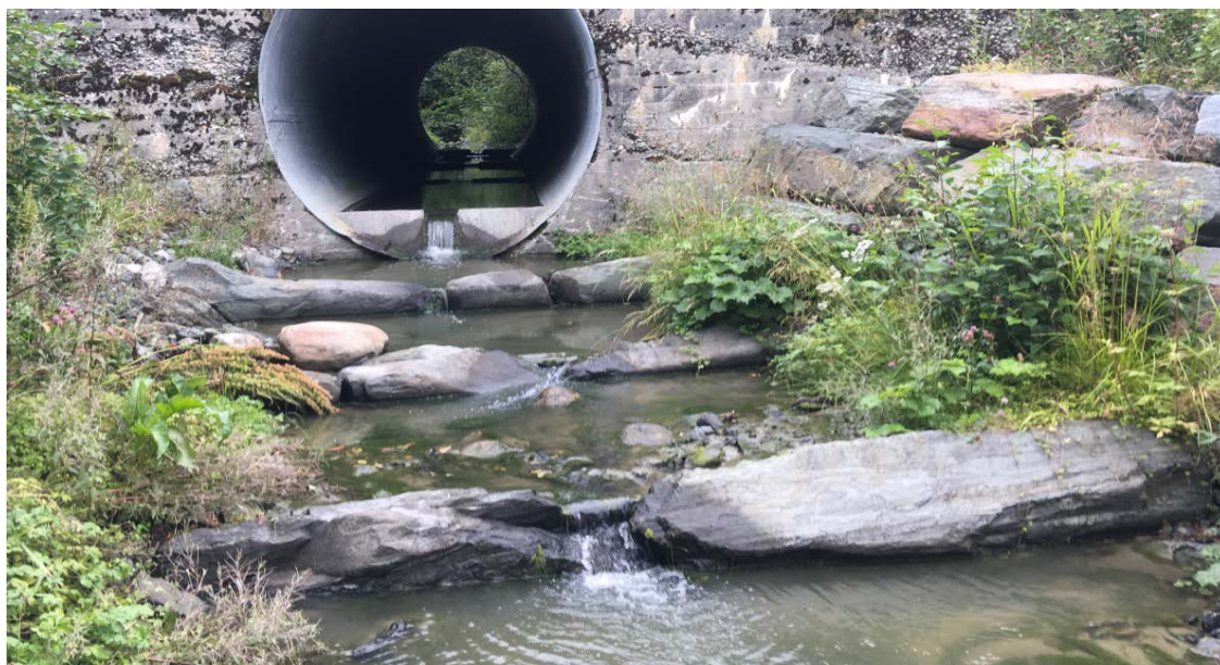
Figur 8. Storbekken opp mot terskler og kulvert under Leinstrandvegen i august 2017. Turbid vann, synlig nedslammet bekkebunn og algebegroing. Foto: Morten Andre Bergan.
