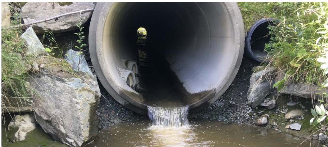
Figur 26. Kulvert under Fv 735 Strandvegen i 2017, nyanlagt mellom 2012-2014, er ikke egnet for fiskevandring. Foto: Morten Andre Bergan.
