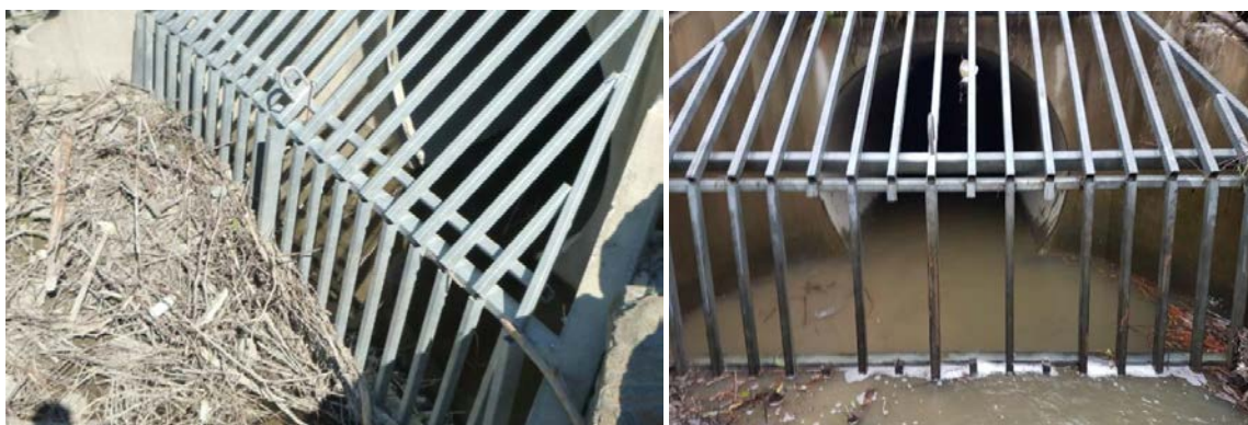
Figur 25. Rista foran kulvert under Fv 735 Strandvegen i 2014 (t.v., tiltettet av kvist) og i 2017 (t.h. etter rensking). Foto: Morten Andre Bergan.
