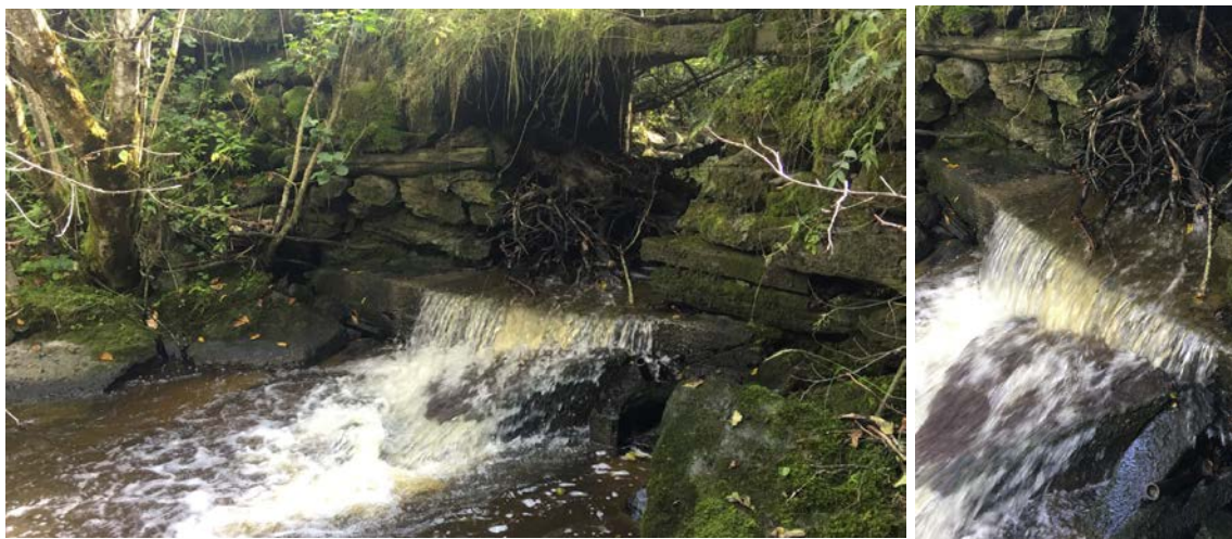
Figur 21. Vandringshindrende kulvert under privat vei har blitt vandringsstoppende etter tilstopning fra en større rot og annet trevirke. Foto: Morten Andre Bergan
