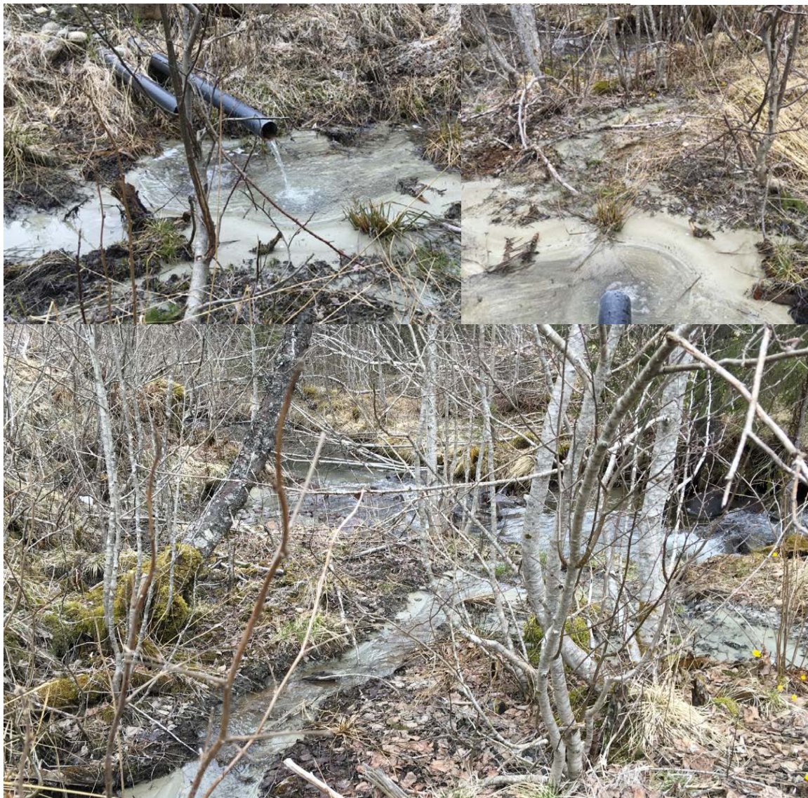
Figur 46b. Øvre del av Sandbekken, april 2016. Drensrør fra steinbruddet med avrenning av finstoff direkte til Sandbekken. Forholdet skal være utbedret av virksomheten. Foto: Morten Andre Bergan
