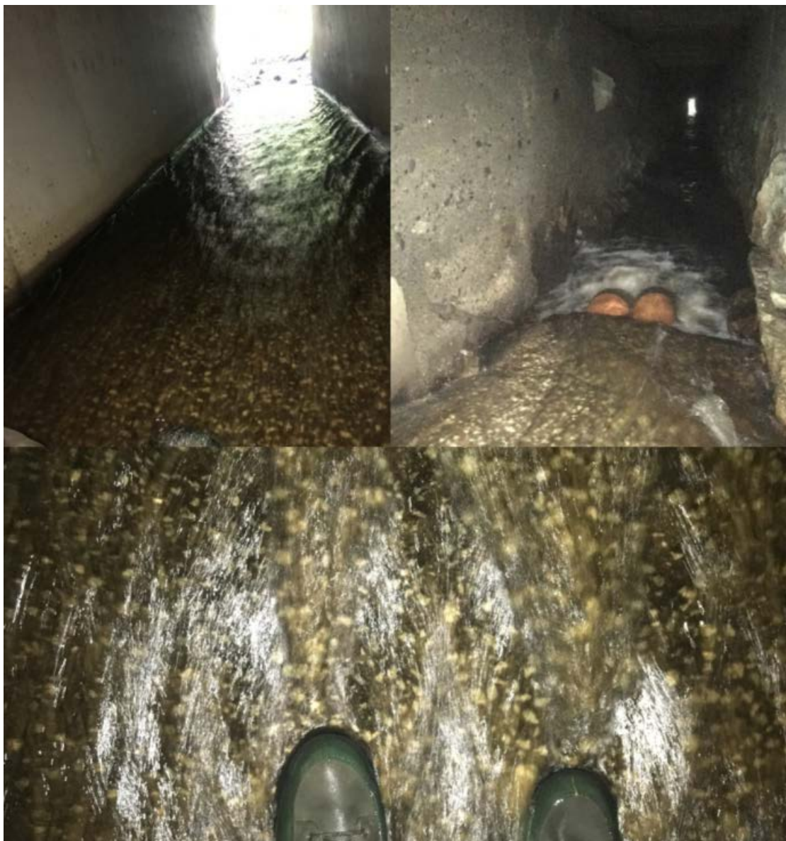
Figur 20. Krysning av jernbane i øvre del av Ratbekken ved Rødde har medført at viktige gyteområder er vanskelig eller umulig å nå for sjøørret. Sammenligning av tetthet av årsyngel ovenfor og nedenfor inngrepet støtter vurderingen. Foto: Morten Andre Bergan.
