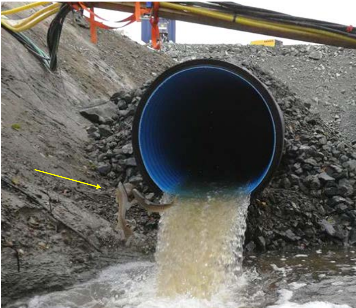
Figur 24. To stk sjørret gytefisk (gul pil) forsøker å passere inngrepet og opp til gyteområdene i Ratbekken høsten 2017, men må gi tapt for summen av høydesprang, vannhastighet og lengde på rørlagt strekning. Foto: Lars Petter Wassmo.
