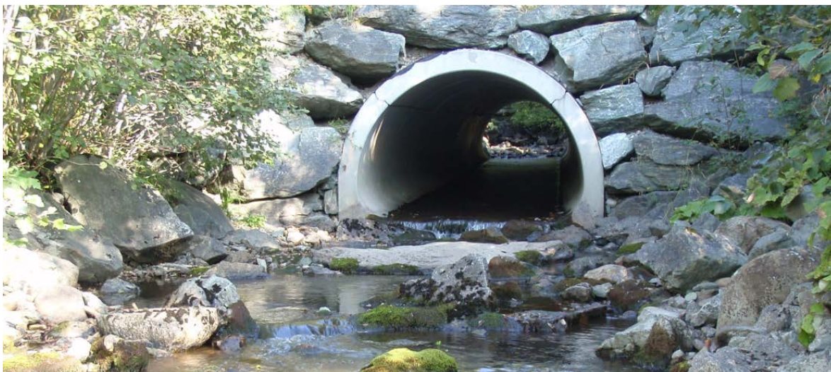
Figur 67. Kulvert i Kvålsbekken like før munning til Gaula i 2008, på lav vannføring i både bekk og Gaula. Flat betongbunn og dårlige oppgangsforhold. Høye ungfisktettheter på strekningen nedstrøms. Vesentlig mindre ungfisk ovenfor. Foto: Morten Andre Bergan
