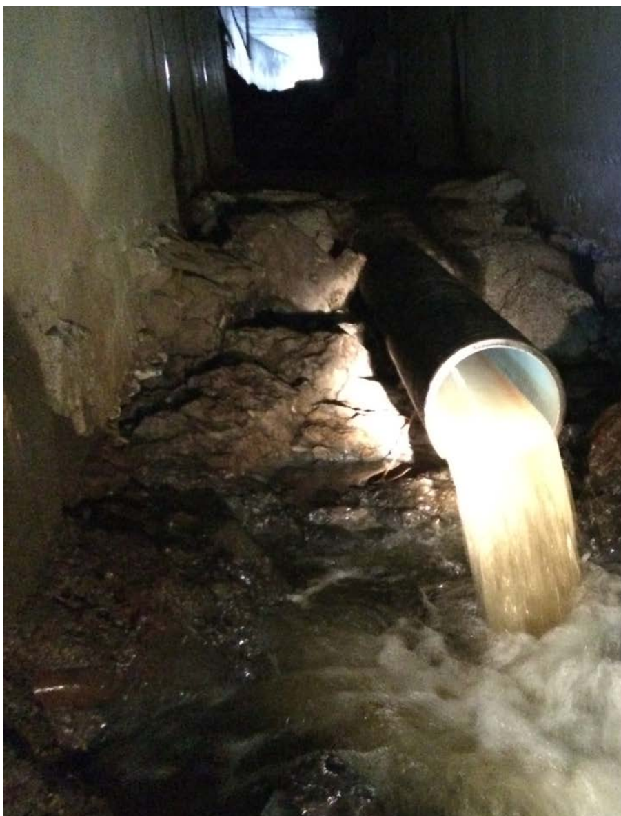
Figur 8. Rørlagt strekning ved Dalebakken Mølle stopper oppgang av all anadrom laksefisk, og hindrer ål for videre oppgang i store deler av året. Foto: Morten Bergan.
