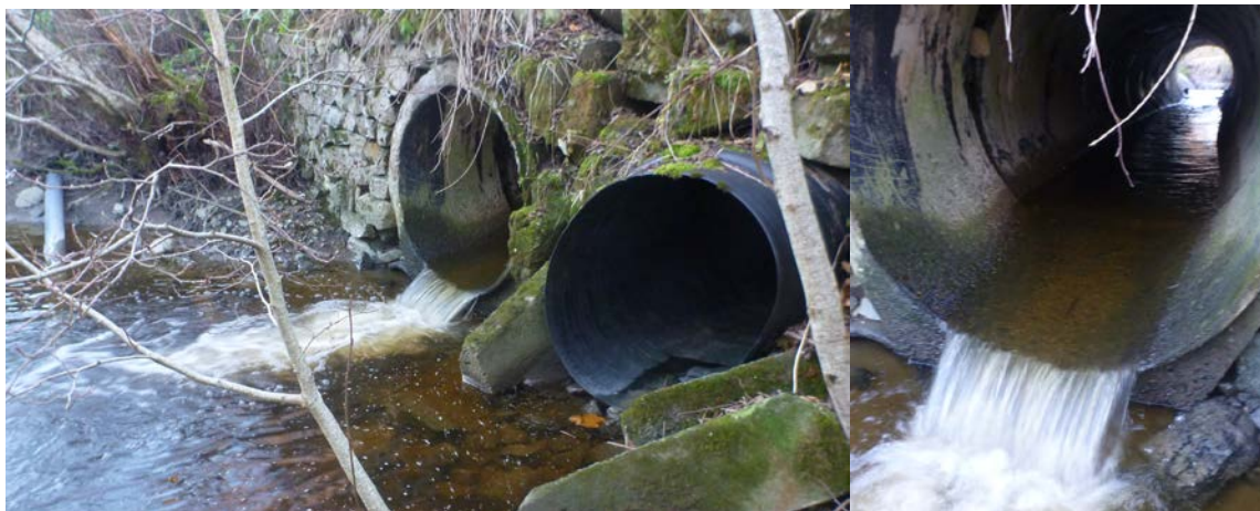
Figur 9. Veikrysning under FV 231 ved Lundal kan forsinke, hindre eller stoppe oppgang, men er passerbar for sjørret dersom vannføringsøkning inntreffer under gytevandringen. Inngrepet bør utbedres. Foto: Morten Bergan.
