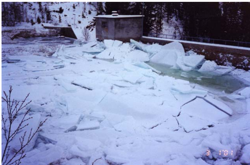
Figur 5. Isforholdene ved inntaksdam 3.01.01. Foto: Rauma Energi AS. Ice problems in the inlet dam 3.01.01. Photo: Rauma Energi AS.
