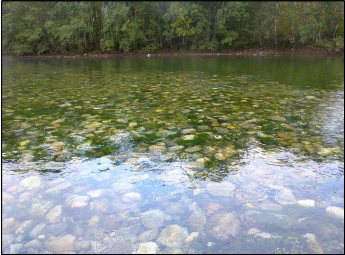
Bilde 4. Et utsnitt av området ved Kirkehølen der finmateriale har blitt fjernet. Det er et tydelig skille mellom behandlet elvebunn (lyst område) og ubehandlet elvebunn (mørkt område ved motsatt elvebredd). Bildet ble tatt 25. september 2013. Foto: Jan Gunnar Jensås.
