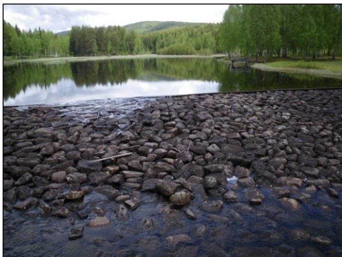
Skrankefoss Træsliperi ble bygget i 1910-1911, og lå gunstig til ved Fallselva like ved Fall stasjon. Fabrikken fikk kraft fra elva, og like inntil fabrikken ble det anlagt en demning for å samle opp tømmer – Skrankefossfløyta. Foto: Bjørn Mejdell Larsen.
