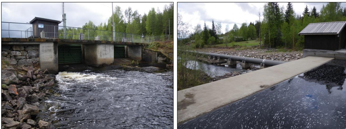
Trevassdammen på utløpet av Trevatna (til venstre) og Linderuddammen som er inntaksmagasin for Fall kraftverk (til høyre). Foto: Bjørn Mejdell Larsen.
