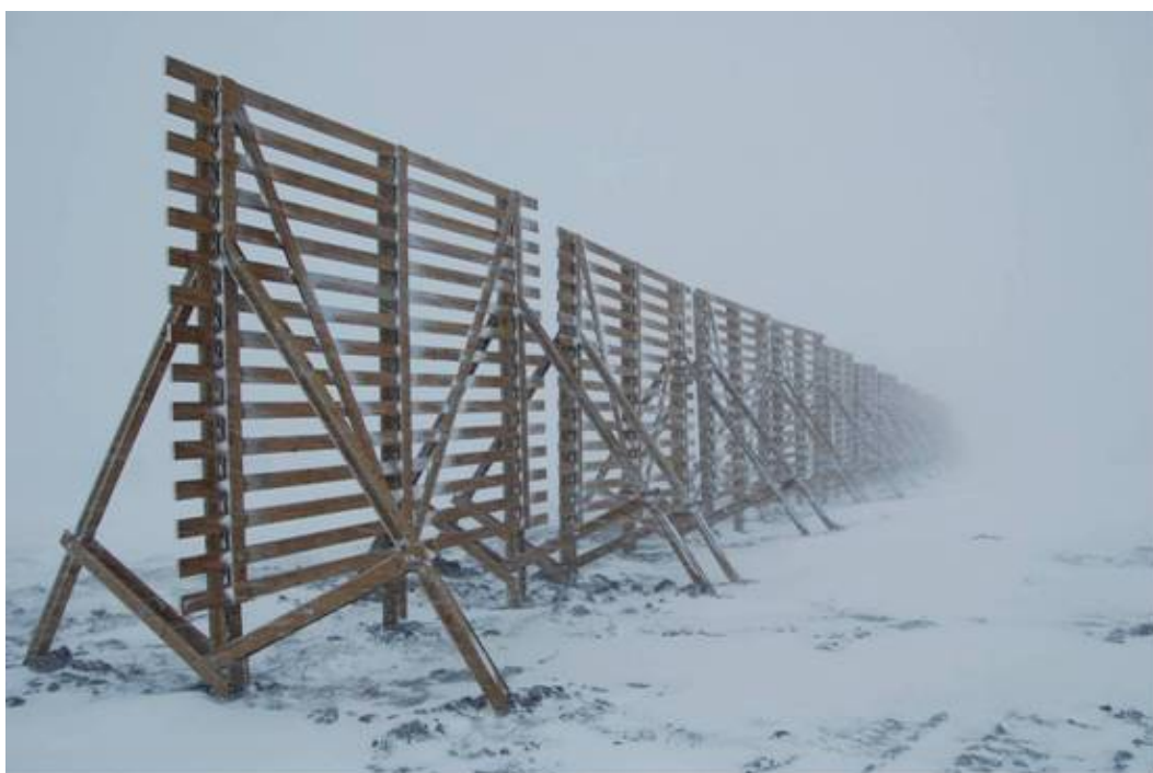
På grunn av store utfordringer med været og akkumulasjon av snø rundt gjerdene i avlsstasjonen, ble det høsten 2008 besluttet at man skulle sette opp snøskjerm for å avlaste dette. Denne skjermen er satt opp i overkant av anlegget og bak stasjonsbygningen. Foto: Roger Meås, NINA
