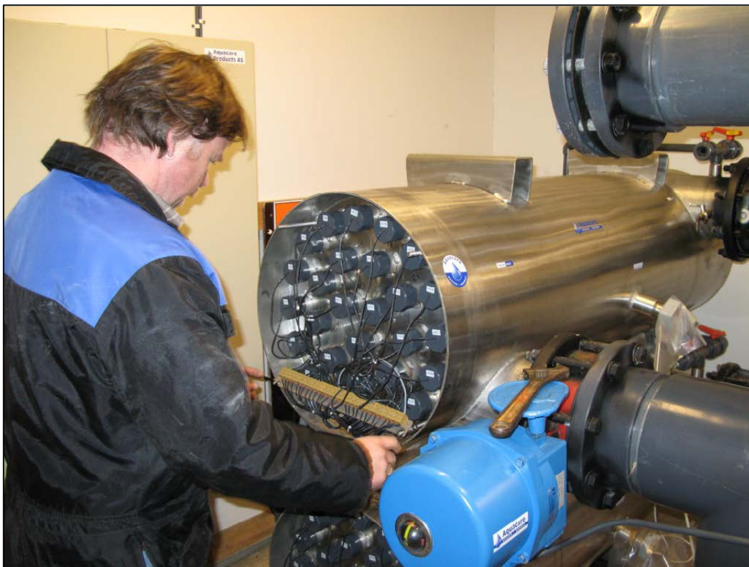
Morten Ims utfører vedlikehold på UV-anlegget. Foto: Knut Aanestad Bergesen.
