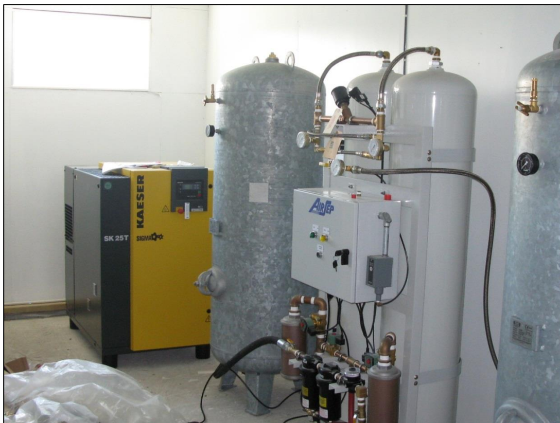
Montering av nytt oksygenereringsanlegg. Foto: Knut Aanestad Bergesen.
